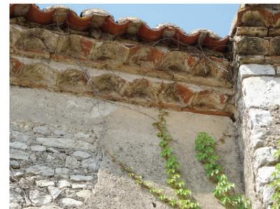
Moellons de pierre visibles, sous l'enduit dégradé
