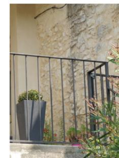
Les **ferronneries** (garde-corps, grilles de défense...) pourront être restaurés par brossage, éventuellement décapage et mise en peinture (dont une couche d'impression anti-rouille).
