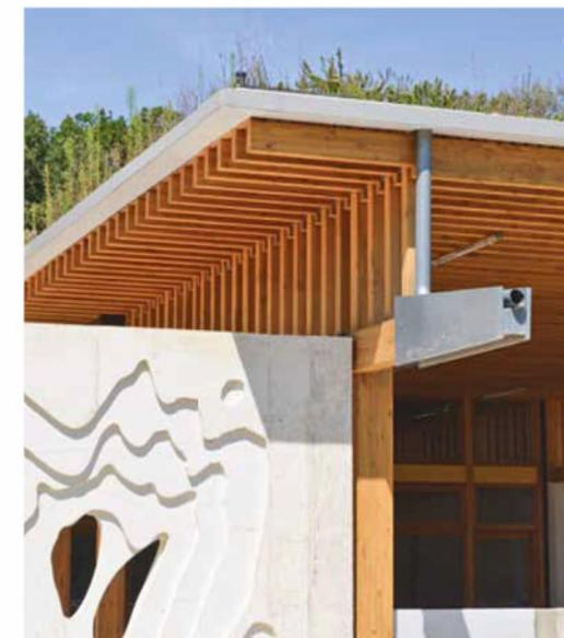
Gestion de l'eau Les eaux pluviales provenant de la terrasse végétalisée sont dynamisées et se dispersent partiellement en brume en tombant à travers des gargouilles en bois habillées de zinc.
