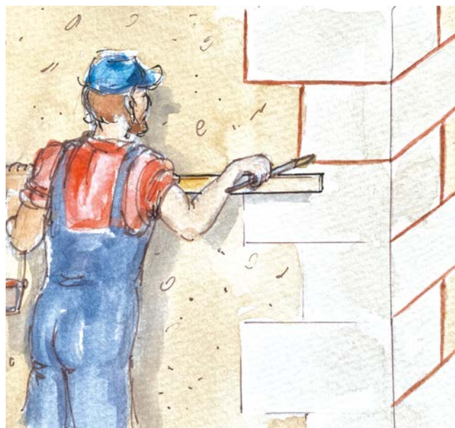
Réalisation d'une chaîne d'angle harpée. ▲
