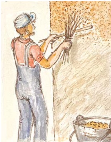
Projection à la main et projection mécanique à la « tyrolienne ».
