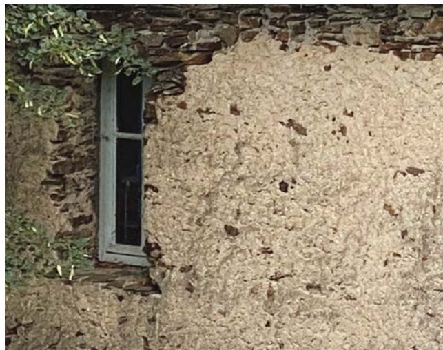
▲ Enduit de chaux et sable (gravette) de schiste.
