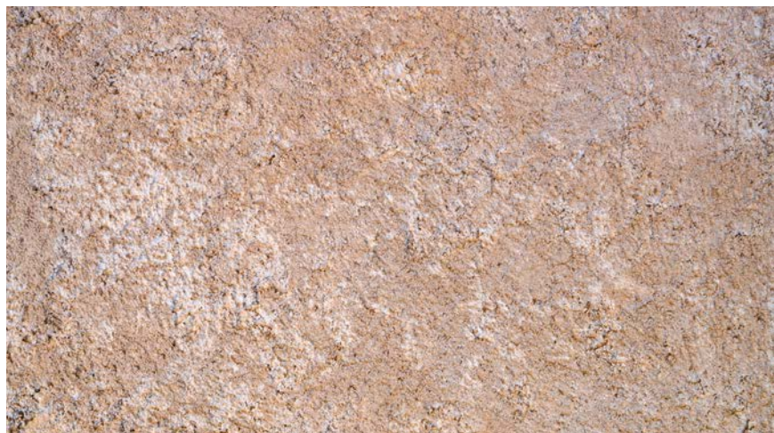
▲ Enduit « jeté-recoupé » : texture grenue.
