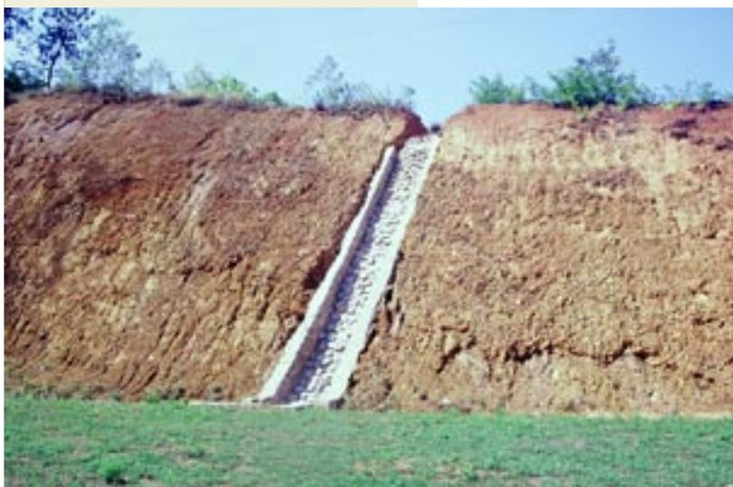
Pôle mécanique-Alès : un exemple d'évacuation des eaux pluviales vers des espaces verts
