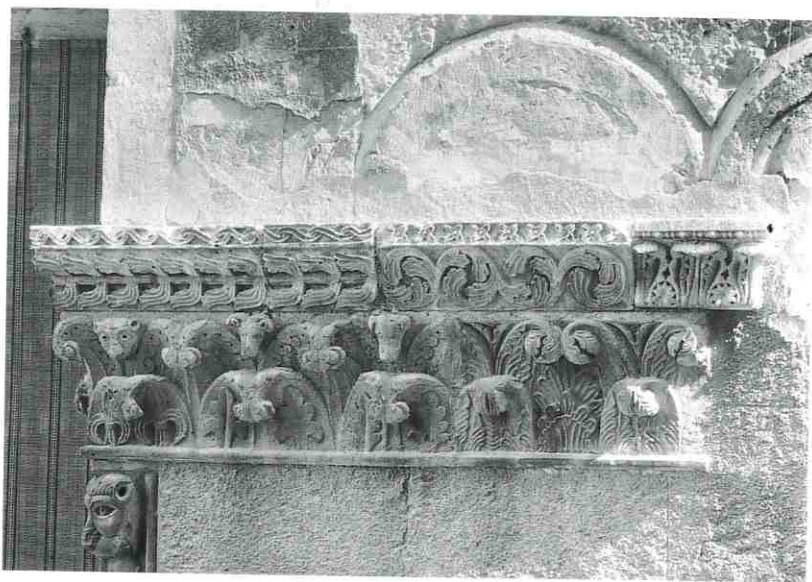
Nîmes. Hôtel, 1, rue de la Madeleine. Détail de la façade.
