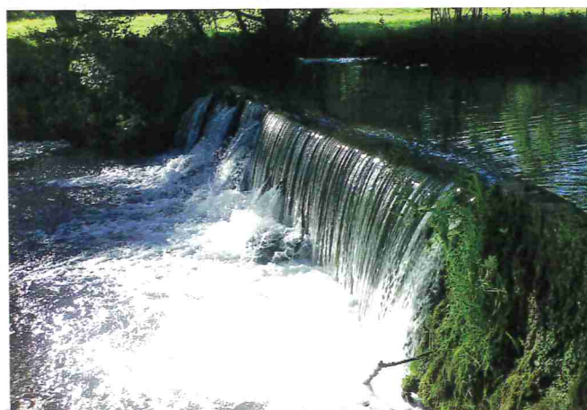
Figure 11: Levée de détournement de l'eau vers un béal
