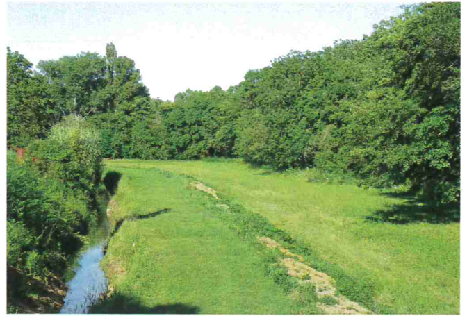
Figure 13: Bassin ou écluse
