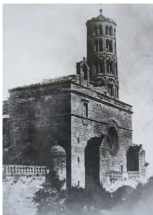
Façade occidentale (XVII e siècle) et la tour Fenestrelle avant 1870. Cl. CRMH.
