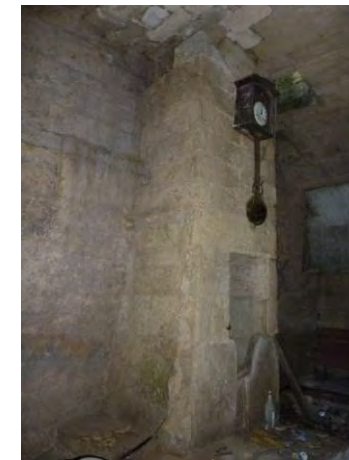
26, rue du Docteur Blanchard. Niveau de cave.
