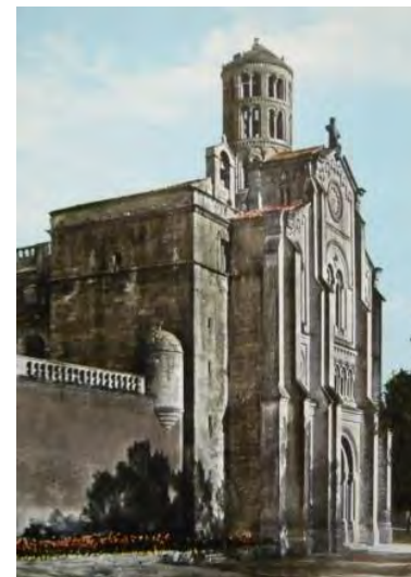
La façade occidentale reconstruite à la fin du XIX e siècle. Cl. CRMH, 1968.
