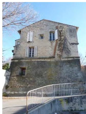
L'extension occidentale du XVII e siècle de l'ancien réfectoire.
