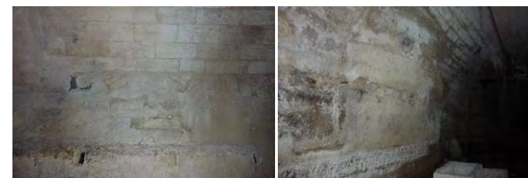
Cave sud. Le berceau de la voûte recoupe deux arcs latéraux (côté nord). A droite, des trous de boulins creusés dans le rocher peuvent indiquer des aménagements antérieurs au voûtement.
