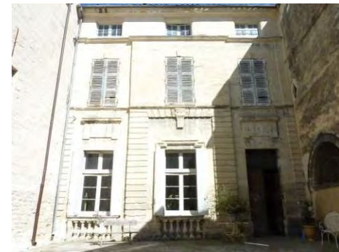
La façade sur cour de l'hôtel du diocèse civil.
