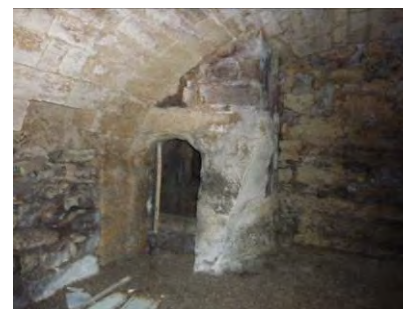
13, rue Pélisserie. Niveau de cave.
