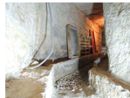
Passage souterrain reliant les deux caves. Deux conduites ouvertes ont été taillées dans le substrat calcaire.
