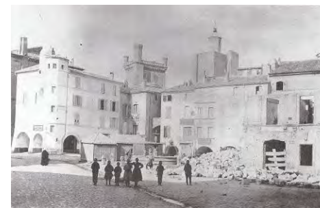
La destruction d'un îlot à l'est de la place aux Herbes en 1890.
