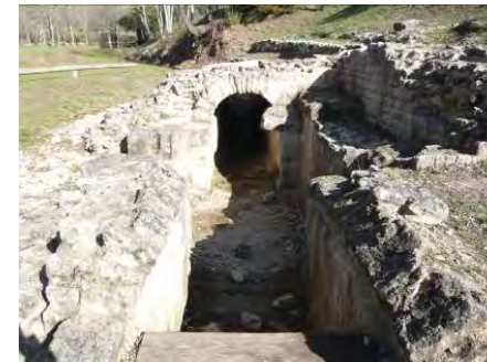
Le bassin de régulation de l'aqueduc.
