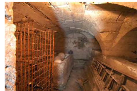
Cave 2. Local artisanal sous voûte en berceau et pénétrations (1750) accessible depuis la cave 1 par un passage souterrain. Deux cuves maçonnées sont rattachées à un système de conduites hydrauliques complexe (conduites d'amenée et d'évacuation, trop-plein). L'hypothèse d'un atelier de teinturier est à considérer sous réserve d'une analyse du dépôt coloré conservé sur les parois intérieures des deux cuves.
