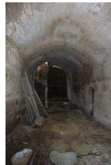
Cave sud. Voûte en berceau surbaissé sur arcs doubleaux
