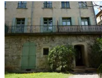
Enceinte médiévale repérée sous la terrasse de l'immeuble au 1, rue Saint-Julien.
