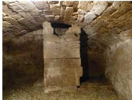
3, rue Saint-Etienne. Voûte de la cave avec son puits, XVII e siècle ?
