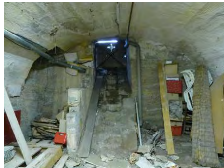
2, rue du Collège, voûte en plein cintre surbaissé du XIX e siècle.
