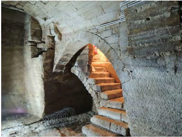
2, rue de la Calade, cave 1 (partie nord-est). L'escalier qui la dessert est un ajout de la période moderne.
