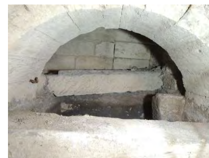
Cave 2. Cuve, conduite de pierre et trop-plein. On remarque sur les parois de la cuve les traces de dépôt.
