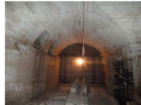
14, rue du Collège, cave sous voûte en berceau en plein cintre du XIX e siècle.
