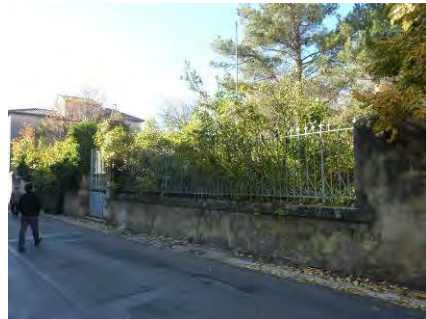
La clôture et le portail d'entrée sur la rue du Collège.
