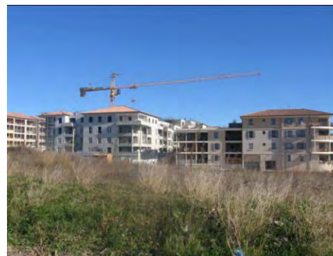
ZAC Chauvin en construction, G2C Environnement, 2009
