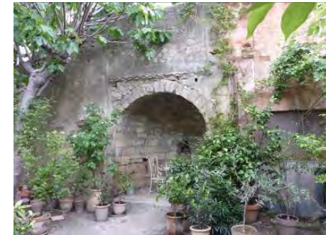
Les vestiges de l'église Saint-Roman dans le jardin du 5, rue Saint-Roman.
