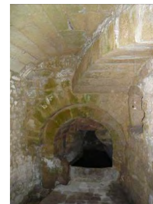
La fontaine Saint-Théodorit et la conduite (à gauche en bas) alimentant le réservoir.
