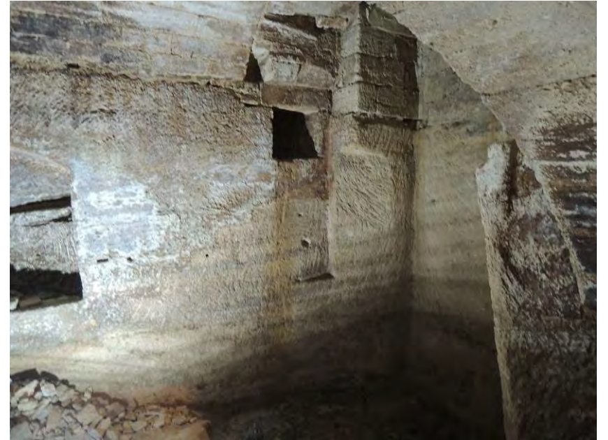
Cave 1 vue du sud-est. Le substrat rocheux taillé en surplomb reçoit la retombée de la voûte en berceau. La paroi rocheuse conserve les traces des outils des carriers.
