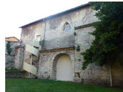
L'ancien réfectoire des Cordeliers (?) annexé au temple protestant (vue de la façade nord).
