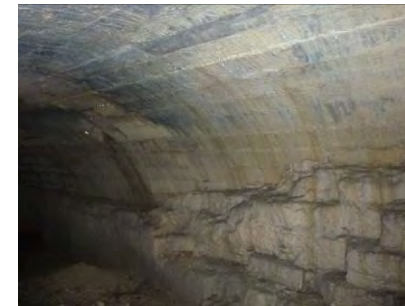
Tronçon de l'enceinte médiévale dans le réservoir du Portalet.
