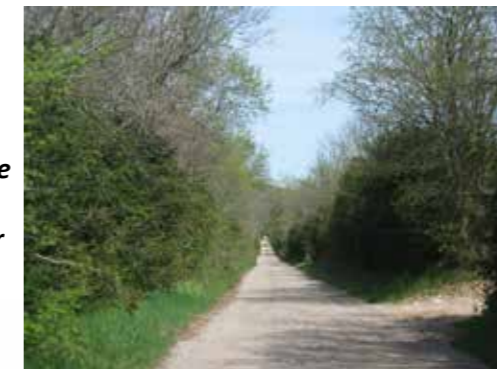
RD 130: La chaussée est bordée d'un remarquable alignement de buis qu'il convient de préserver. L'élargissement de la voie n'est pas souhaitable.
