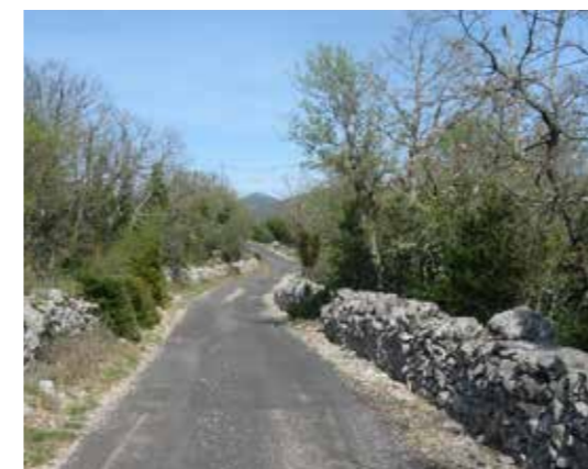
La route menant du Coulet à Saint Maurice bordée de murets de pierres
