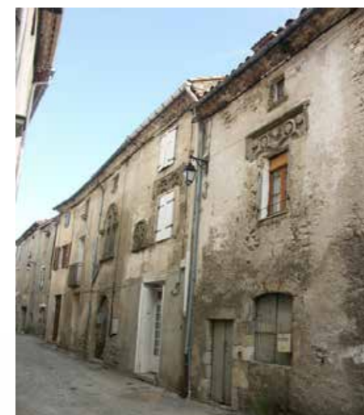
Montdardier, bâti de valeur patrimoniale
