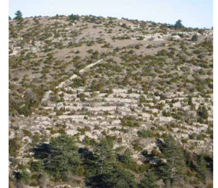
Paysage de terrasses très dégradés en surplomb de la Vacquerie
