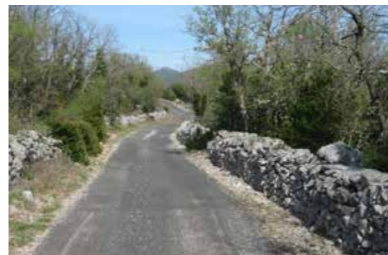
RD 130: l'alignement de murets cadre la chaussée et ancre la voie dans une continuité historique et patrimoniale par la présence d'un vocabulaire hérité des anciennes drailles.
