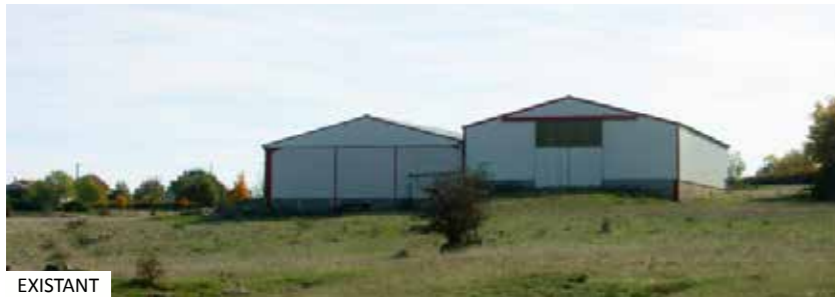
EXISTANT Bâtiments aux Rives en bac acier (état existant)
