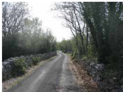
RD 130: Muret en pierres sèches à préserver et gabarit de la chaussée à conserver. En cas d'élargissement nécessaire, il convient de reconstruire à l'identique les murets et de restaurer le maillage bocager.
