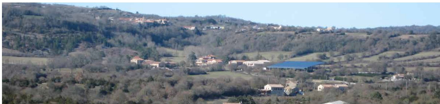
Panneaux solaires à Madières
