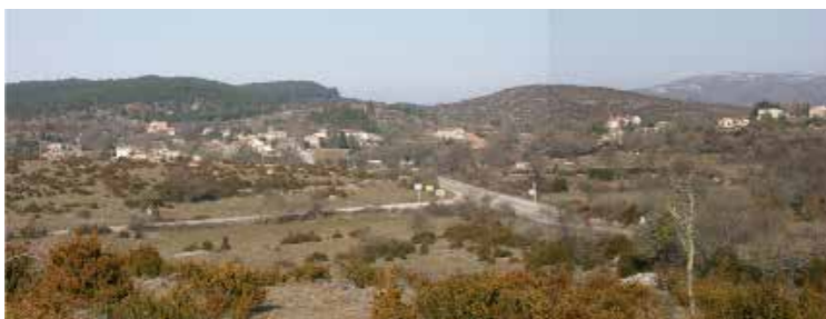
4- Enjeu sur le front nord du village de Blandas et les extensions situées à l'est
