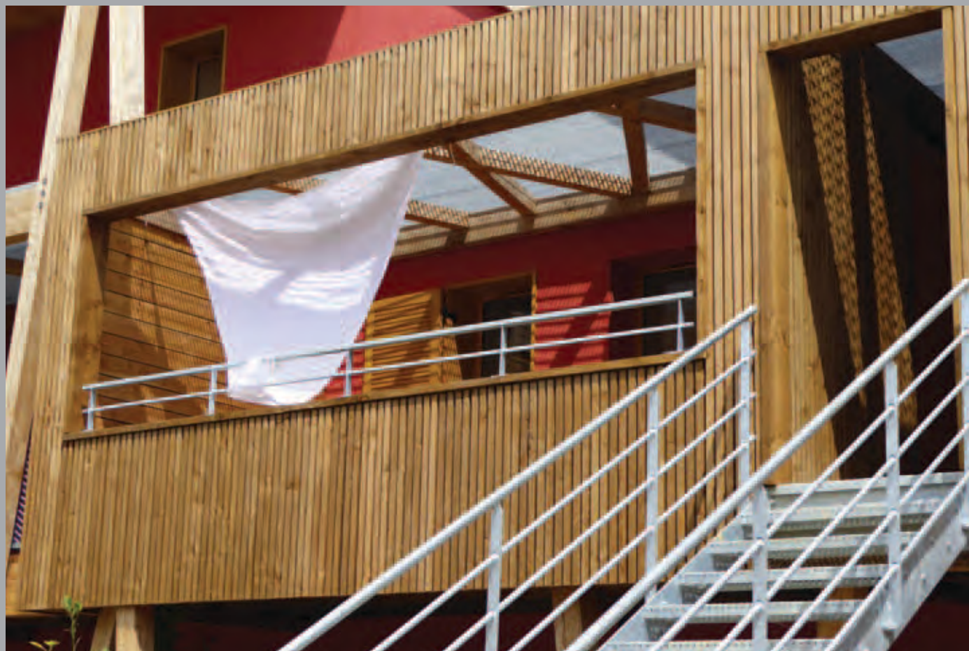
Coursive nord desservant les logements. Bâtiment A, rez de jardin.
