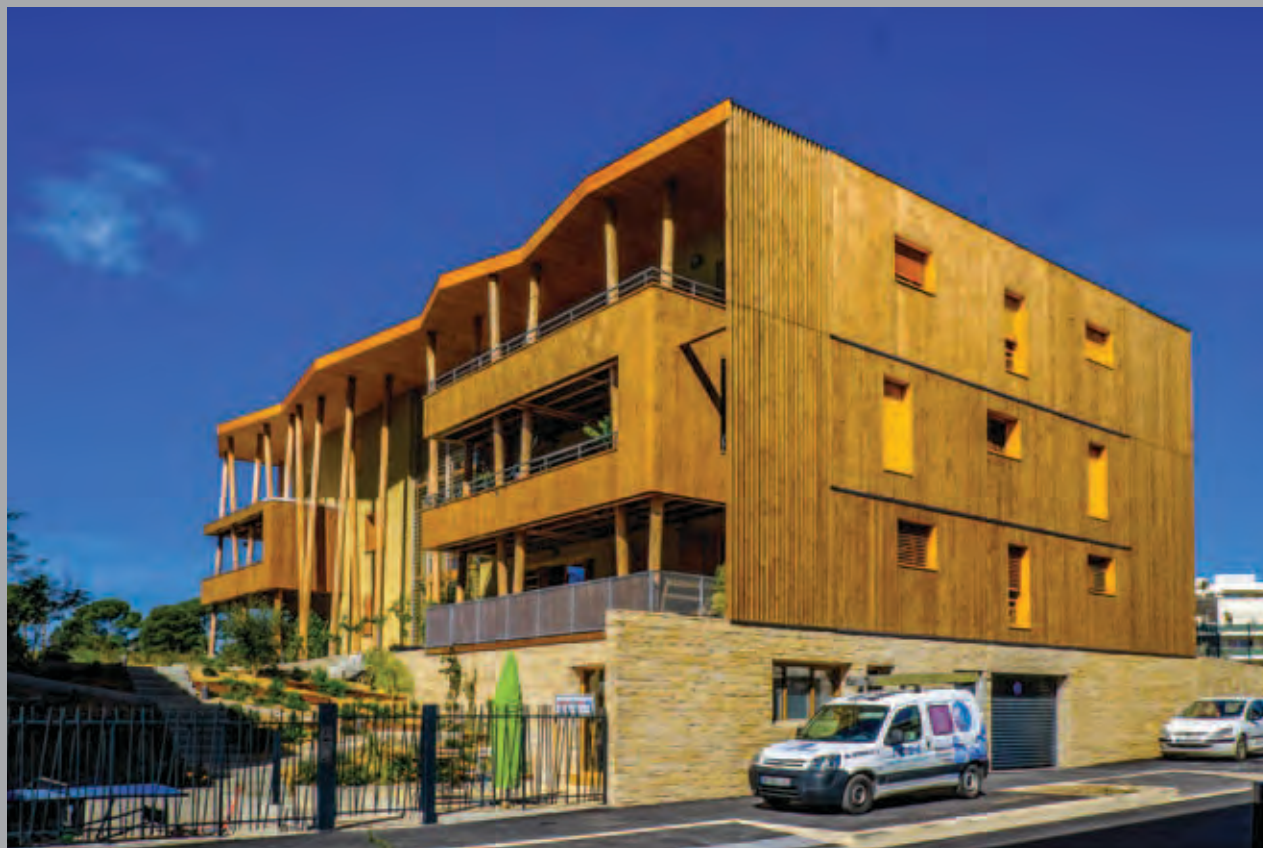
Bâtiment B : façade sud avec les terrasses privées.
