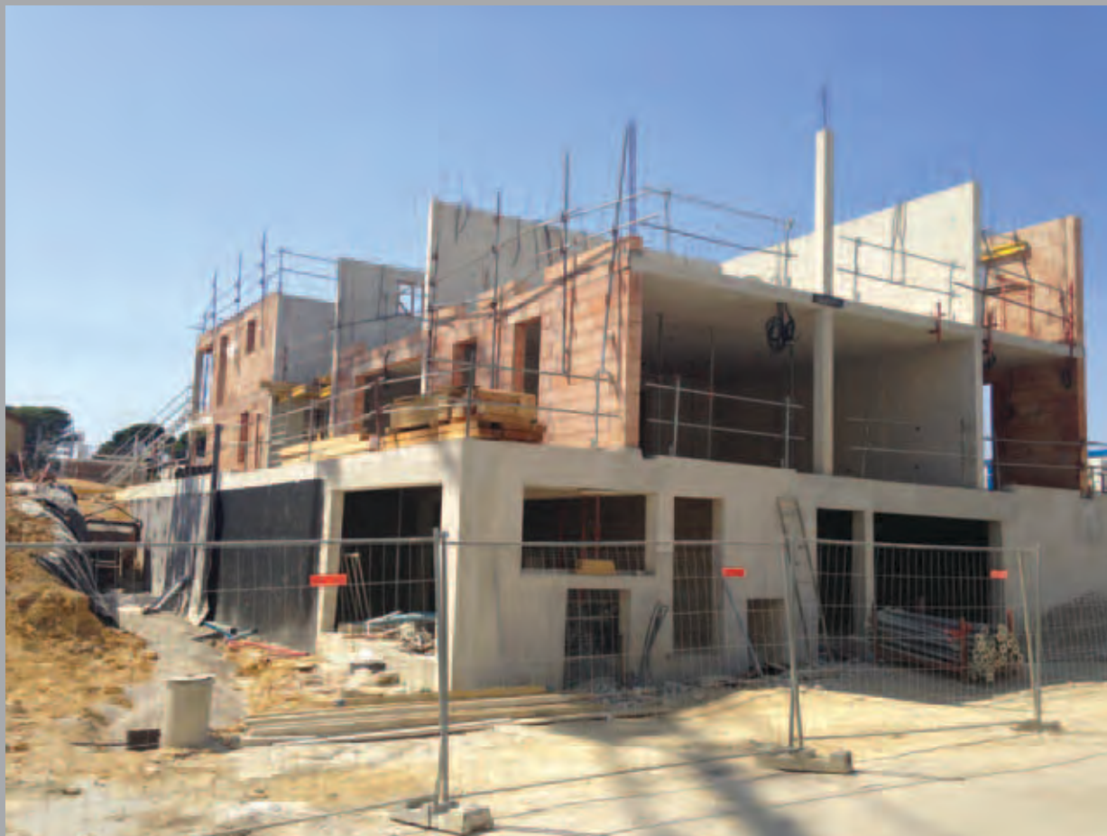
Bâtiment B : vue depuis la rue sur la future salle polyvalente au rdc.
