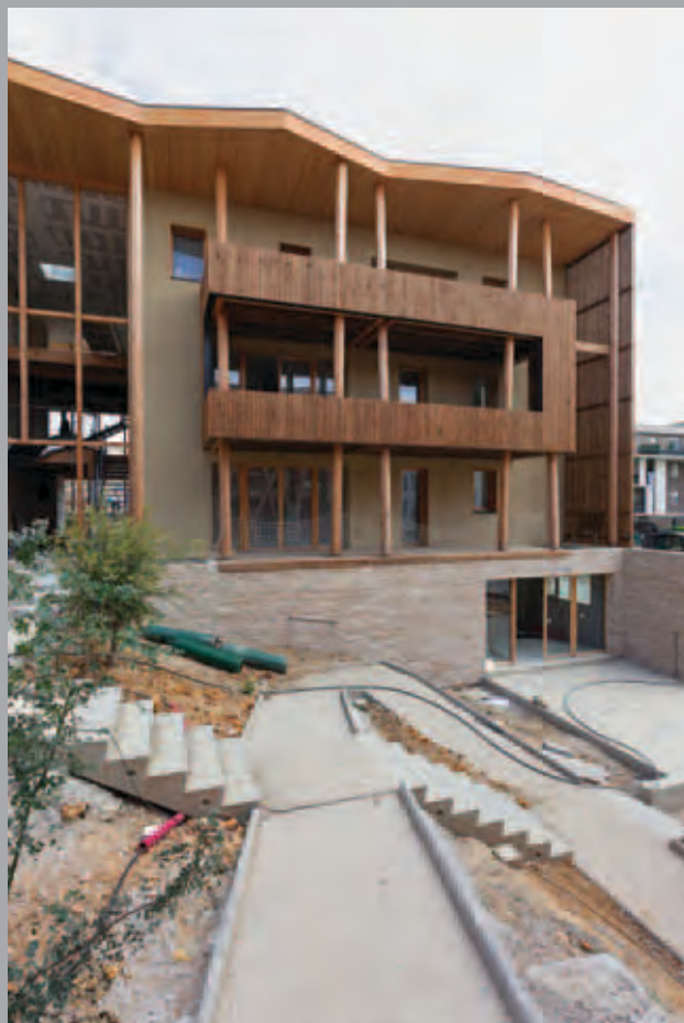
Bâtiment B : côté rue, avec la salle polyvalente.
