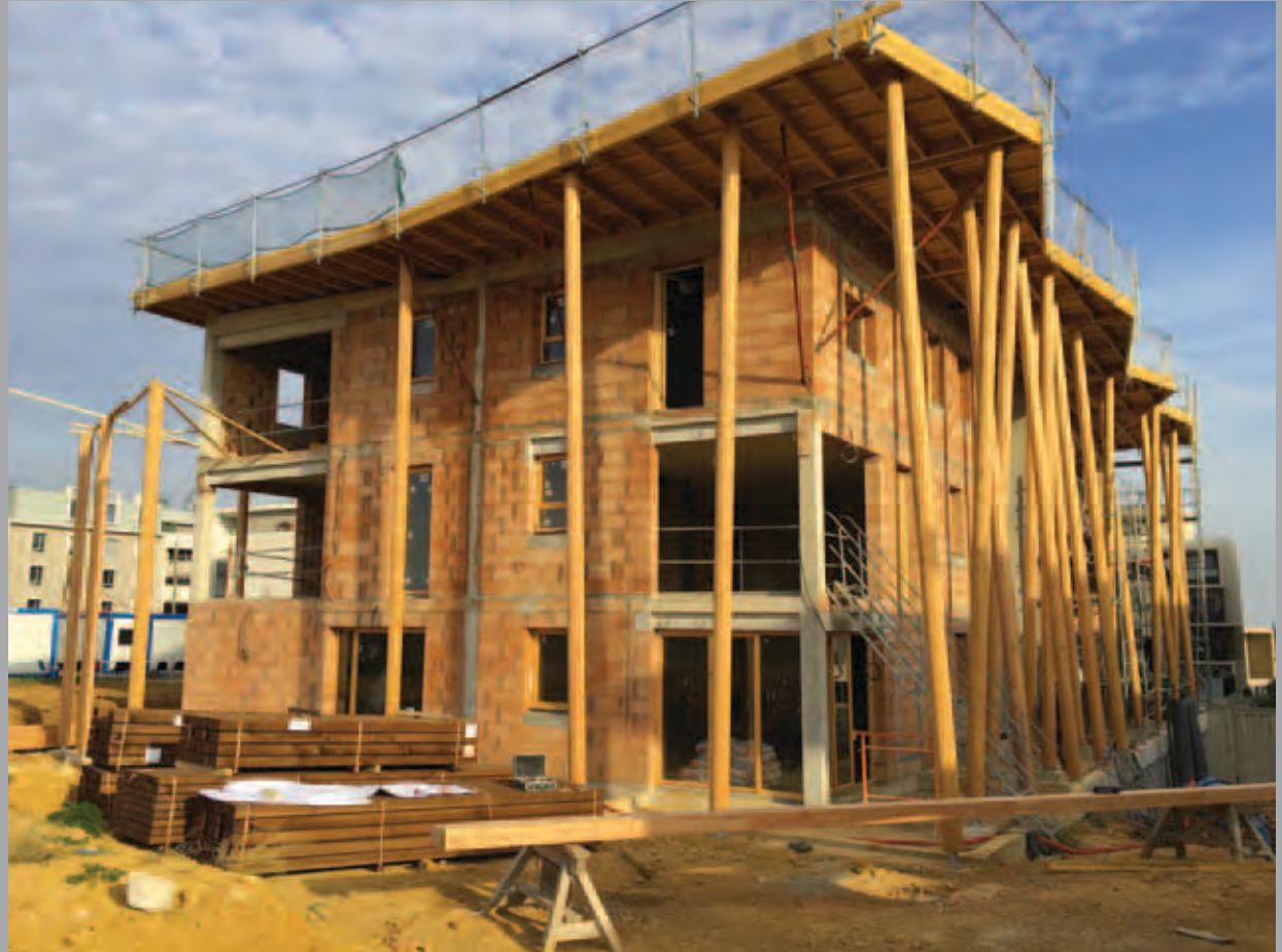
Bâtiment B : la « forêt de poteaux » est prête à recevoir les structures des terrasses.
