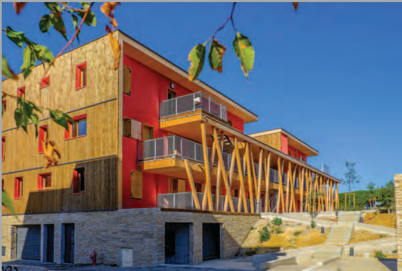
Bâtiment A : façades est et nord.
