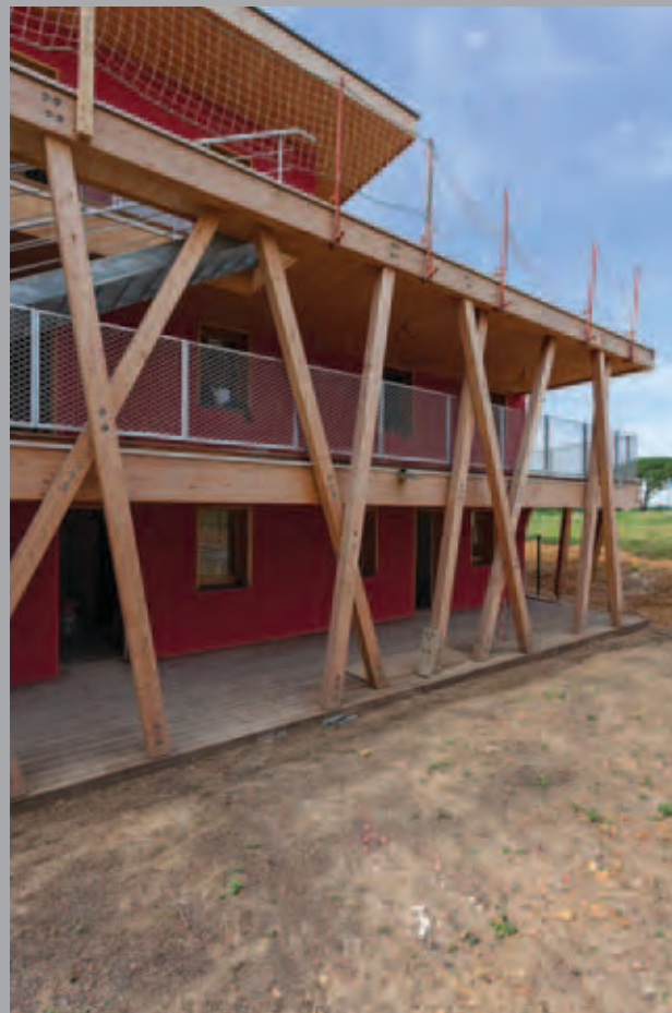
Bâtiment A : détail de la résille porteuse des coursives nord.
