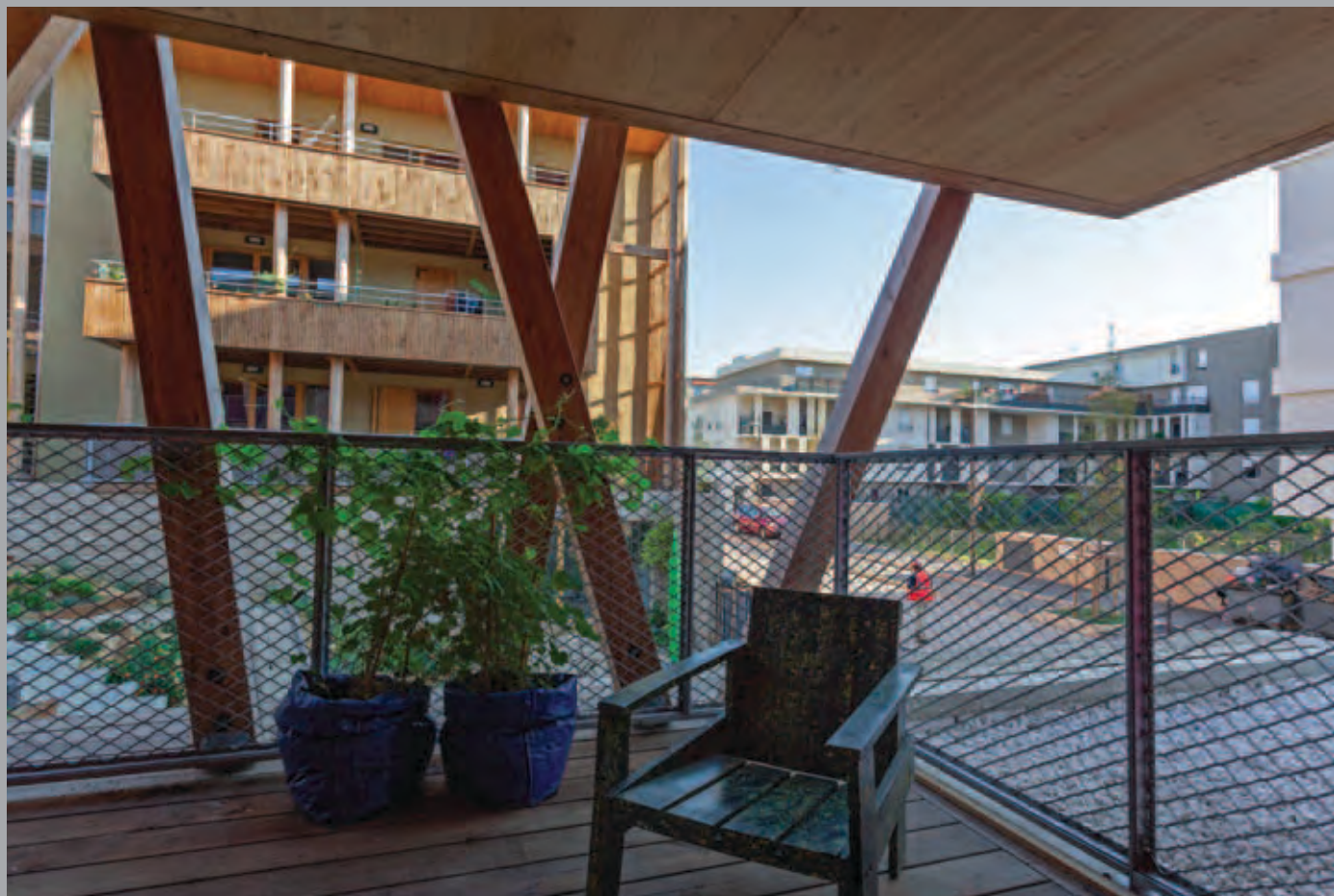
Détail d'une coursive de distribution des logements du bâtiment A.
