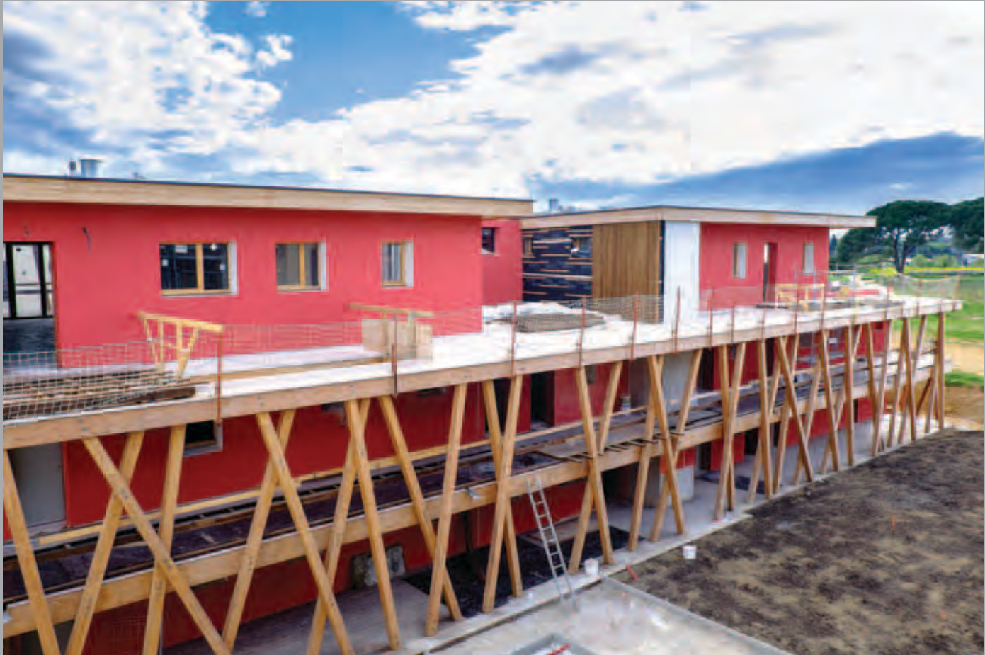
Bâtiment A : vue depuis le bâtiment B.
