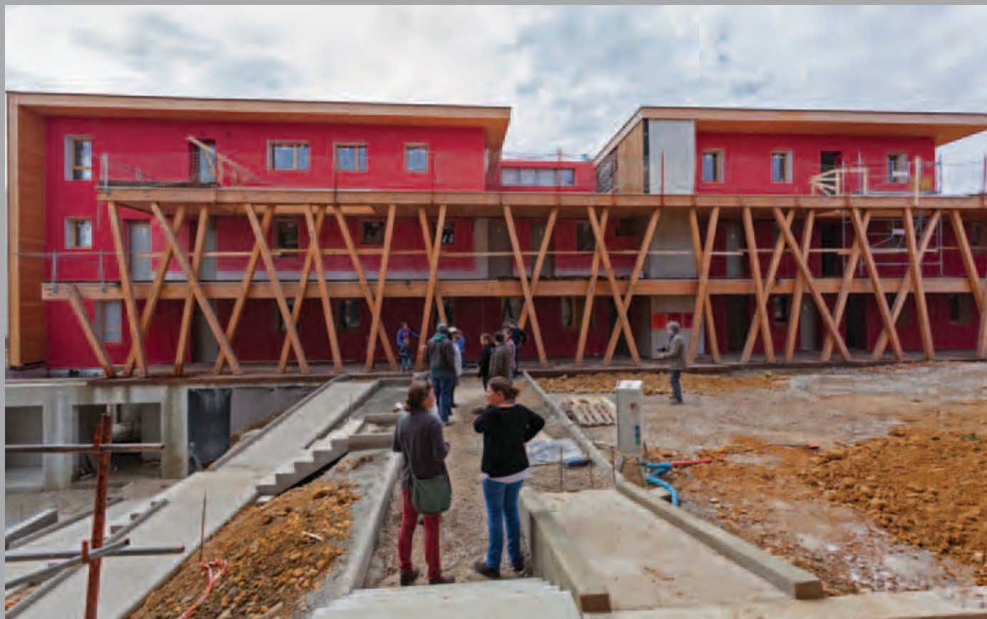
La « Place du Village » et le bâtiment A : visite du chantier.
