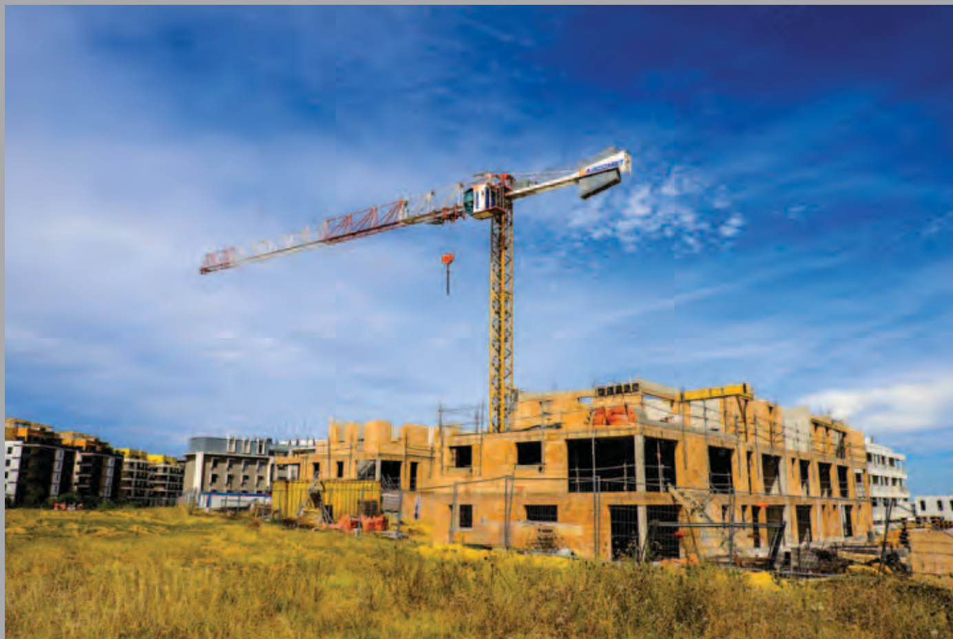
Vue du chantier depuis l'agriparc.
