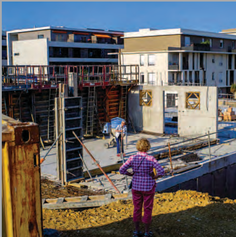
Bâtiment B : lors d'une visite de chantier, Christiane dans son futur « chez elle ».
