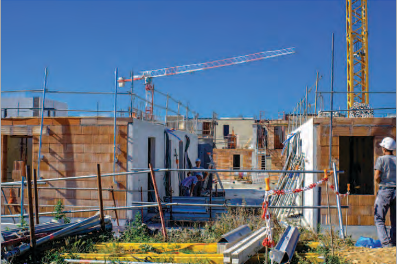
Bâtiment B : le futur patio se dessine entre les deux blocs de logements.
