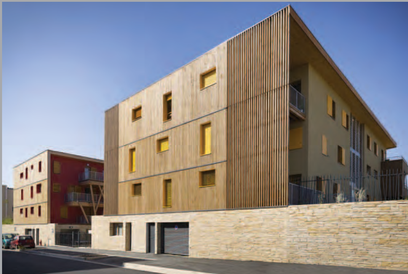
Bâtiment B, façade est sur rue et façade nord.
