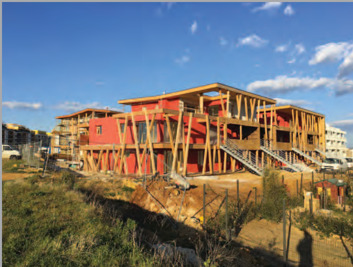
Bâtiment A : vue depuis l'agriparc, avant la pose des garde-corps.
