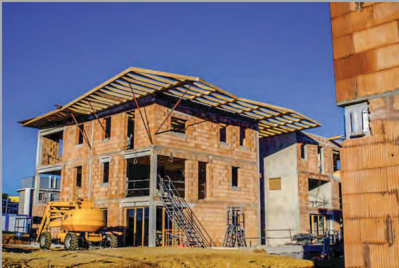
Bâtiment B : vue depuis le jardin. Le porte à faux des débords de toiture avant la pose des poteaux bois.
