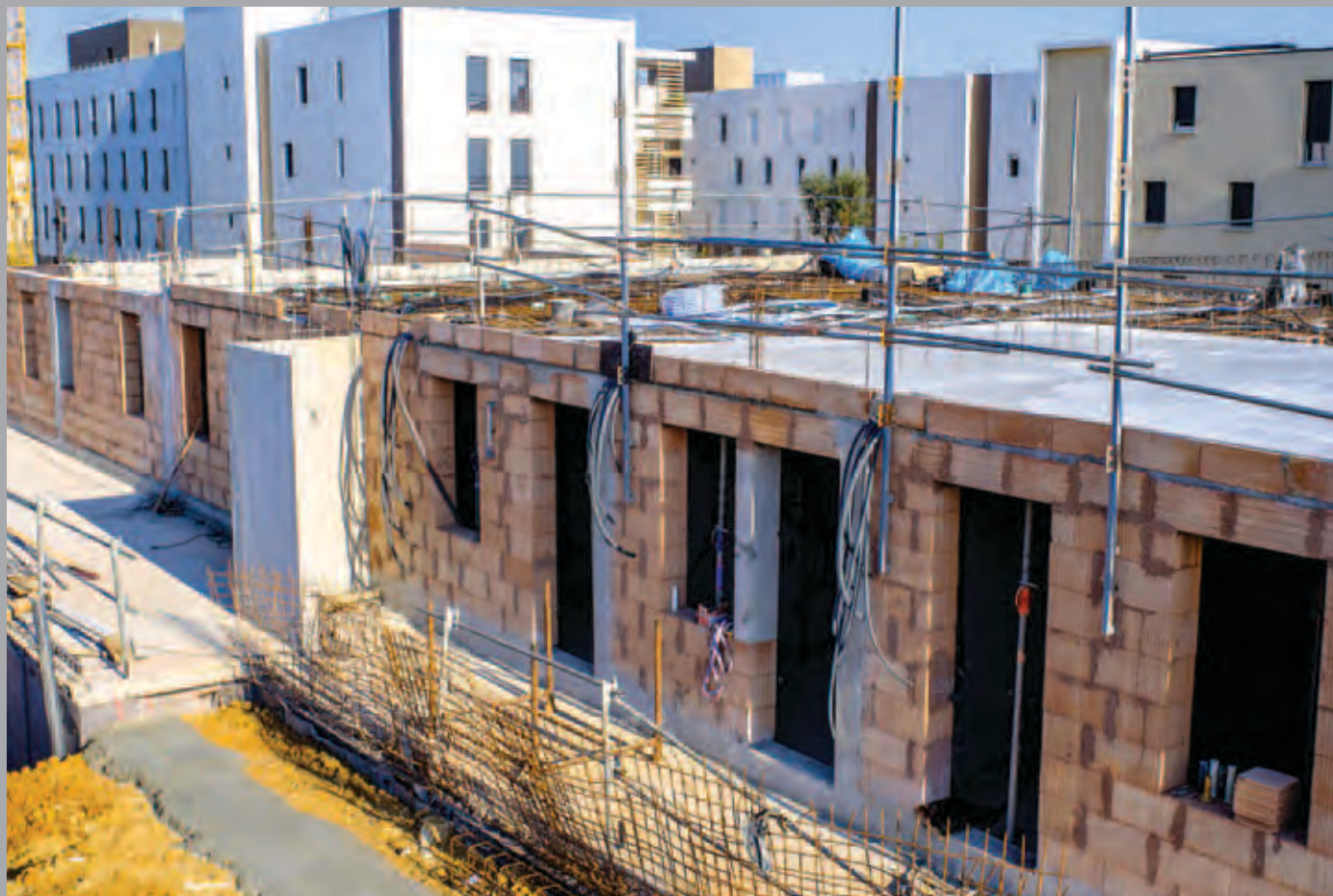
Bâtiment A : gros-œuvre du rez-de-jardin. Murs réalisés en brique à isolation répartie de 25 cm.
