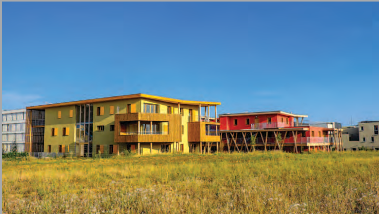
Vue d'ensemble de MasCobado. Façades nord depuis l'agriparc.
