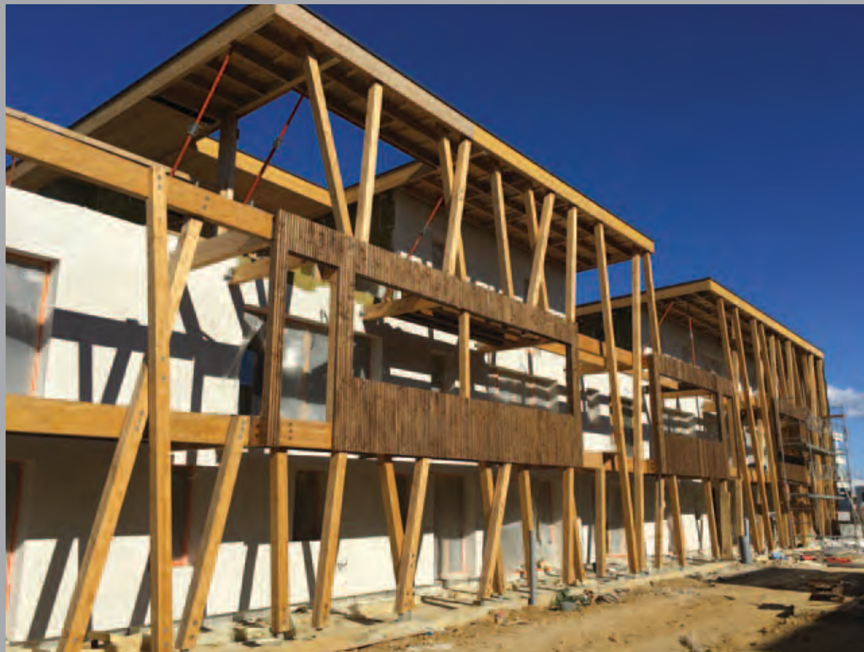
Bâtiment A : façade sud. L'isolation par l'extérieur est posée et enduite, les bardages des loggias sont en cours de réalisation.
