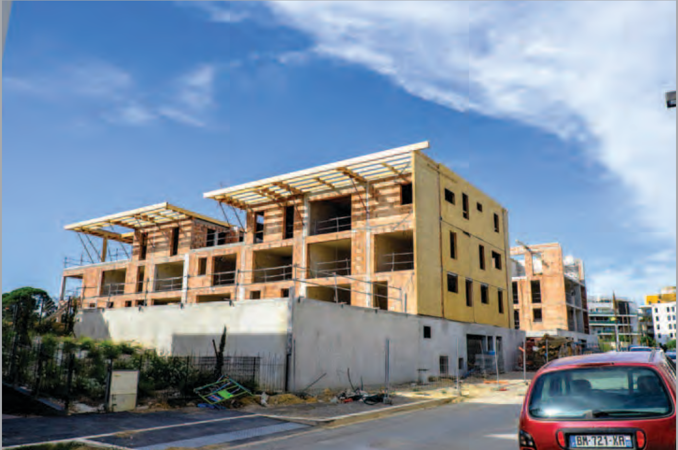
Bâtiment A : montage du mur à ossature bois et de la charpente.
