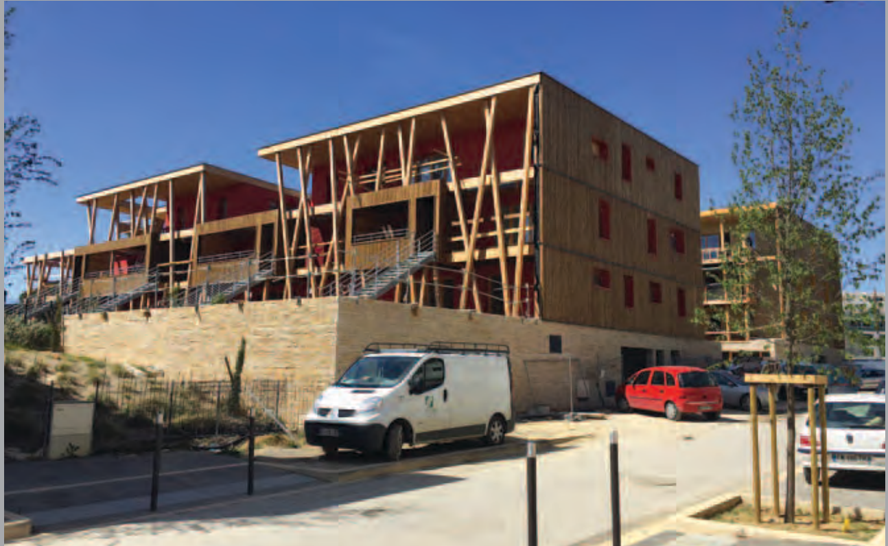
Vue d'ensemble avant la livraison des bâtiments, façades sud.
