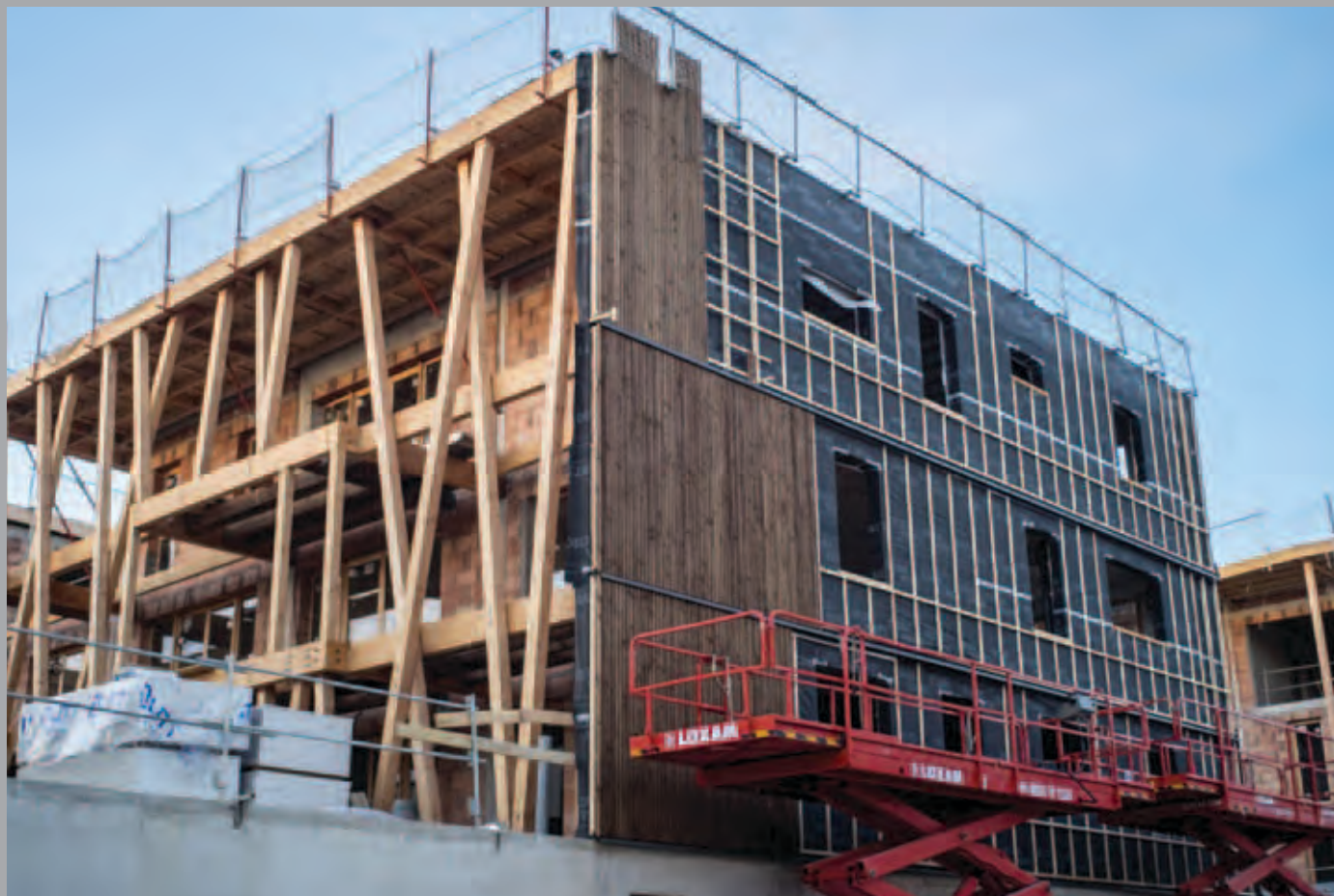
Bâtiment A : réalisation du bardage du mur à ossature bois (côté rue).
