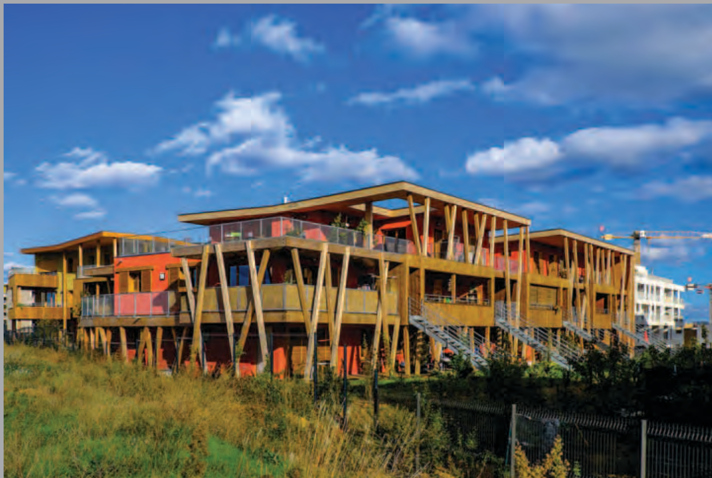
Bâtiment A, façades sud et ouest, vue depuis l'Agriparc.
