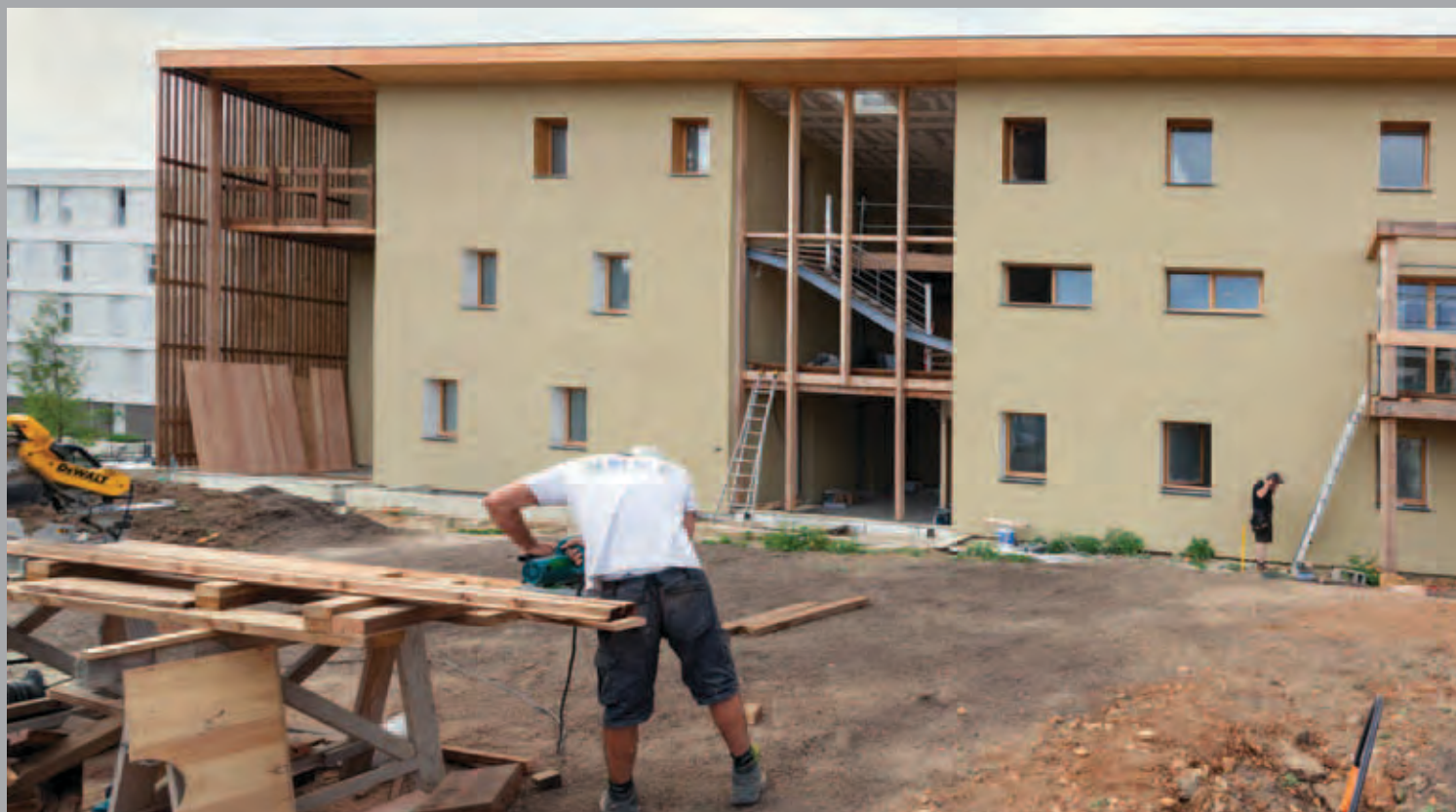
Bâtiment B : façade nord. Les charpentiers terminent les terrasses.
