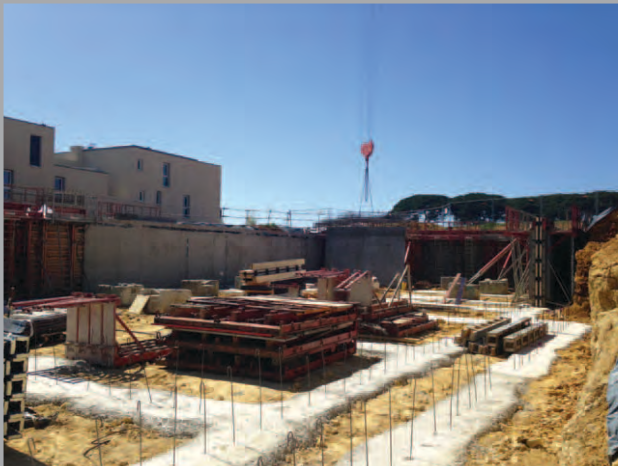
Bâtiment A : les fondations au niveau des parkings.
