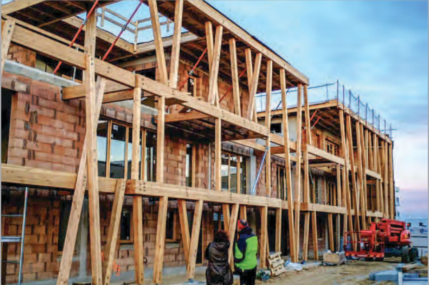
Bâtiment A : façade sud. Eléments de charpente et des terrasses.
