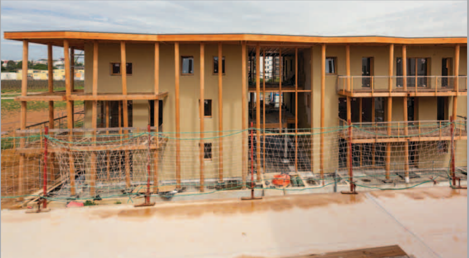
Bâtiment B : vue depuis la terrasse partagée. Le Patio attend la pose des lames de verre orientables pour ventiler l'été et se protéger des vents l'hiver.
