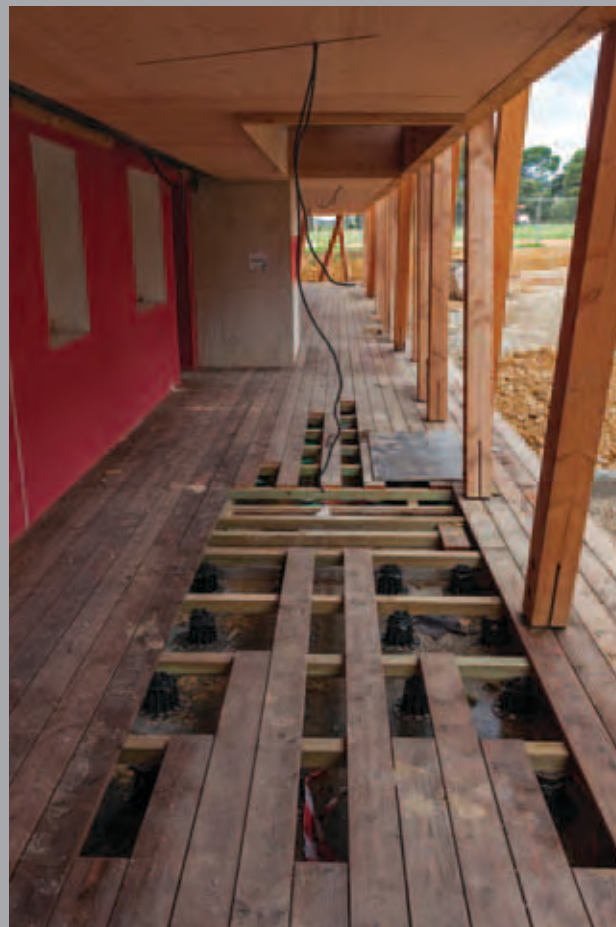
Bâtiment A : finitions du sol des coursives.
