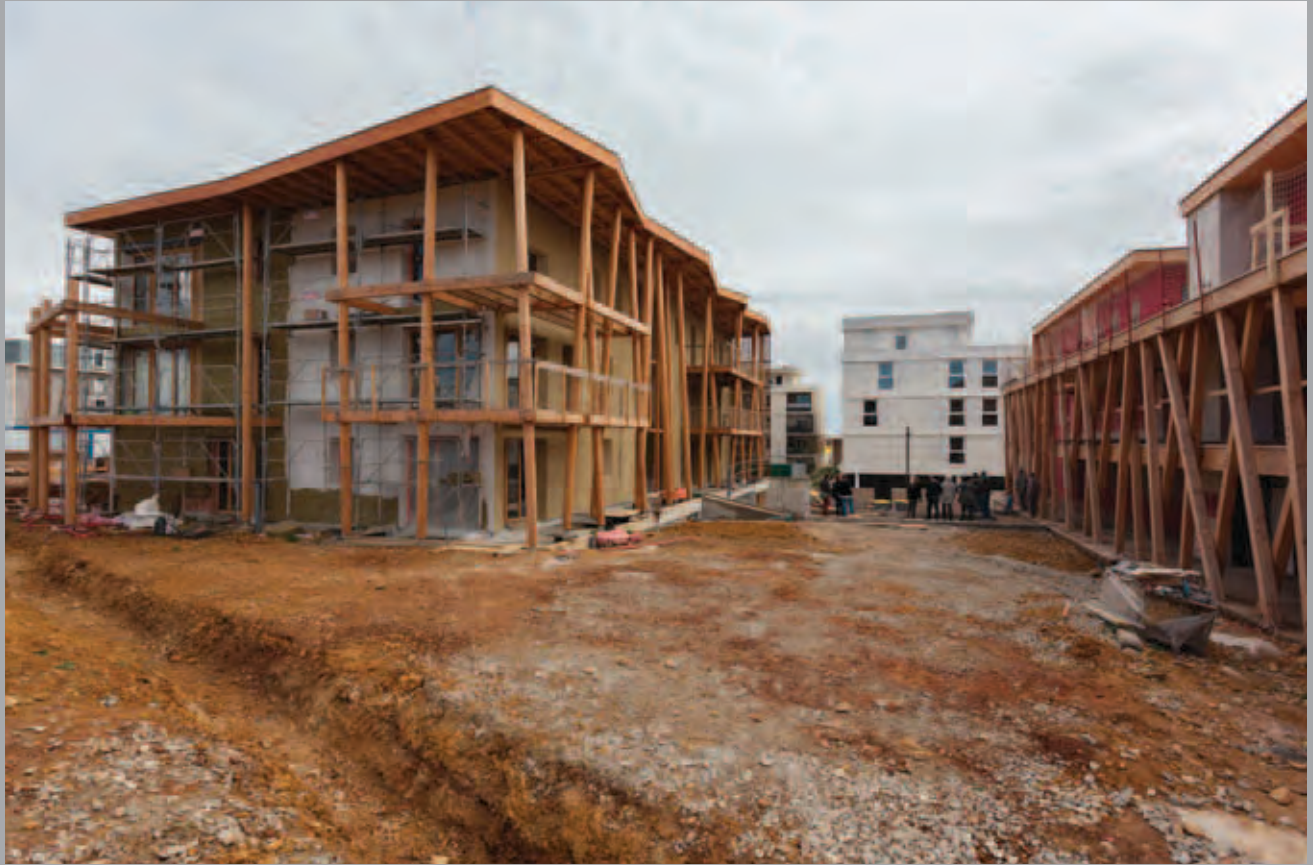
La « Place du Village » entre les deux bâtiments, vue depuis l'agriparc, avant la pose des clôtures.
