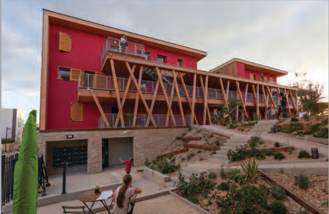
Bâtiment A (façade nord) et parvis d'accueil. En bas à gauche, les boîtes aux lettres de la résidence et l'accès aux locaux techniques et partagés (local OM, buanderie, parking...)
