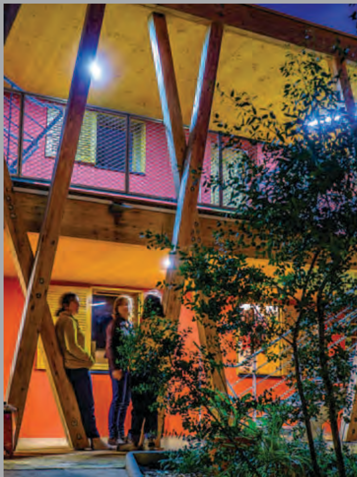
Le bâtiment A et ses coursives, lieu de rencontres et de convivialité.
