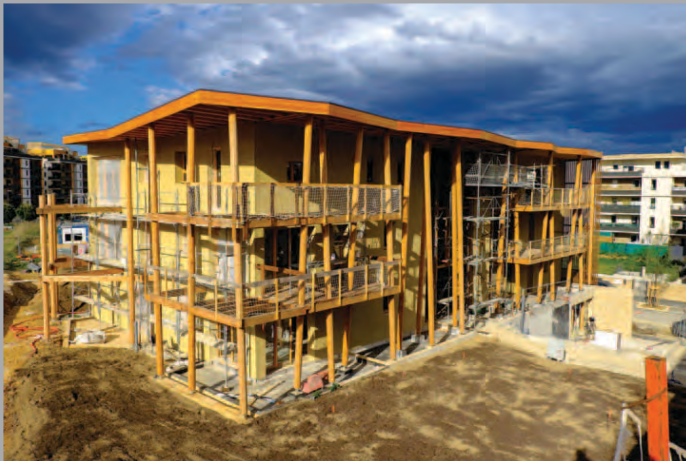
Bâtiment B : vue depuis le bâtiment A.
