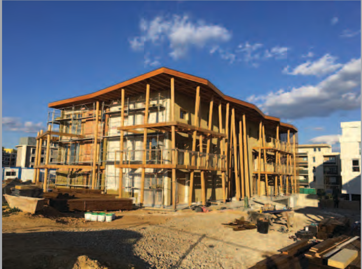
Bâtiment B : pose de l'isolation thermique par l'extérieur.
