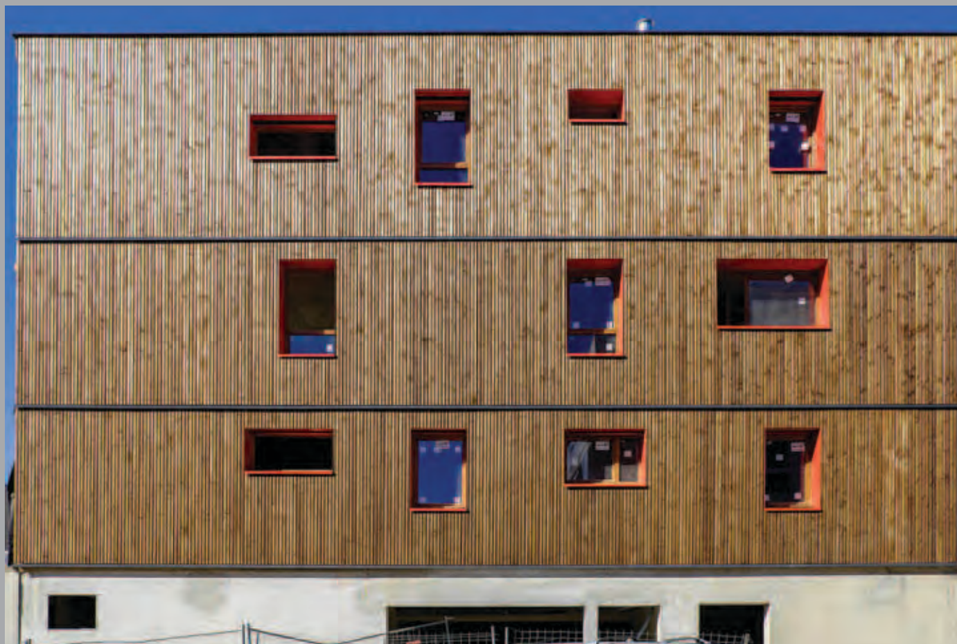
Bâtiment A : entrée du parking.
