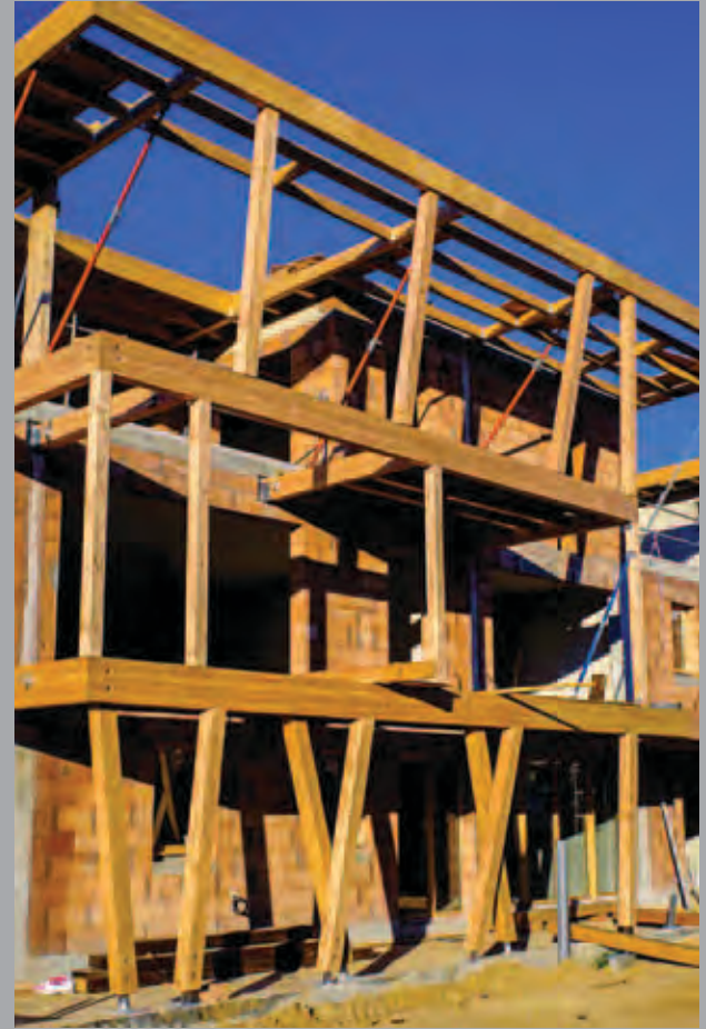
Bâtiment A : façade sud. Eléments de charpente porteurs des terrasses au sud.
