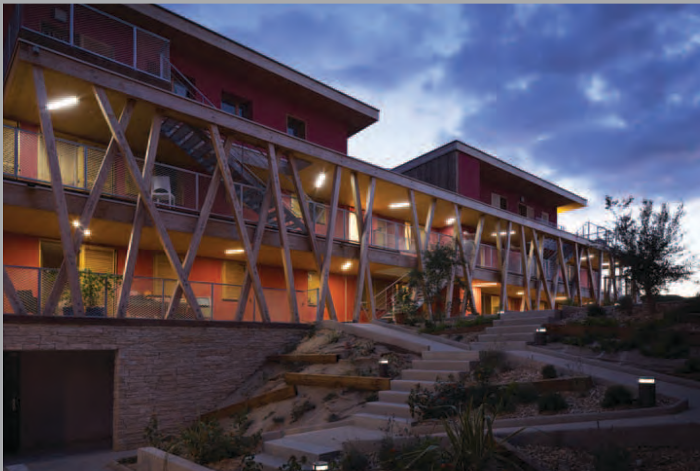
Bâtiment A : façade nord. Coursives vues depuis le parvis d'accueil. Les coursives sont éclairées par des LED agencées en écho à la résille des poteaux bois et le parvis par des plots solaires.
