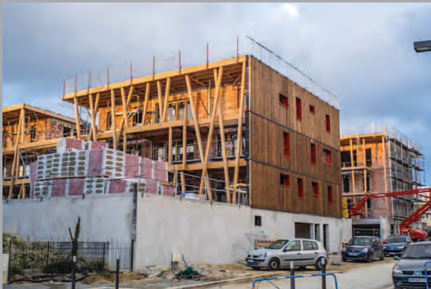
Vue d'ensemble depuis la rue.
