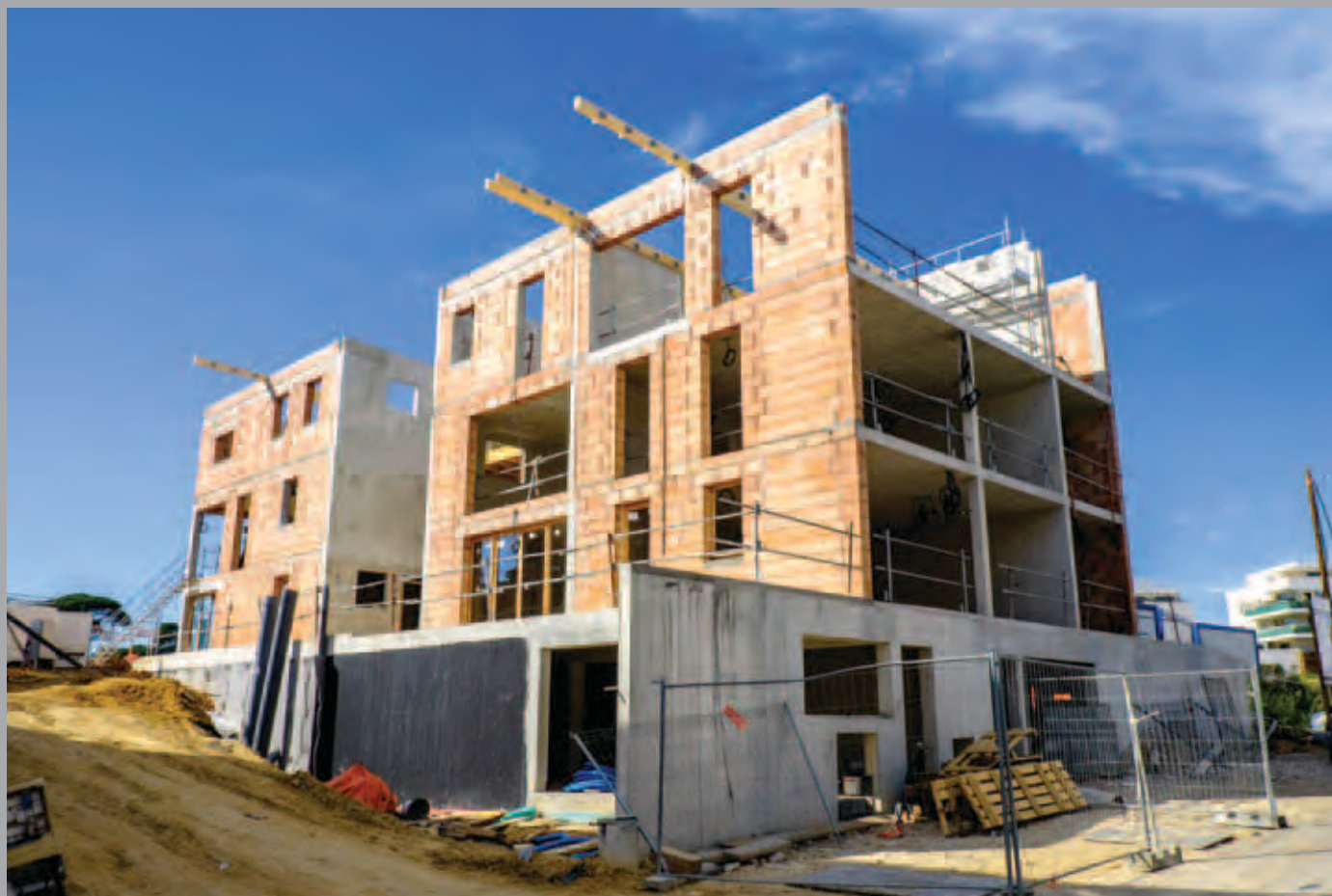
Bâtiment B : en façade sud, la pose de la charpente débute.
