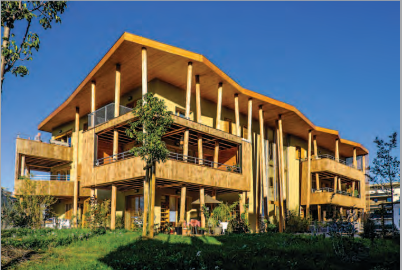
Bâtiment B, façades sud et ouest, vu depuis le jardin.
