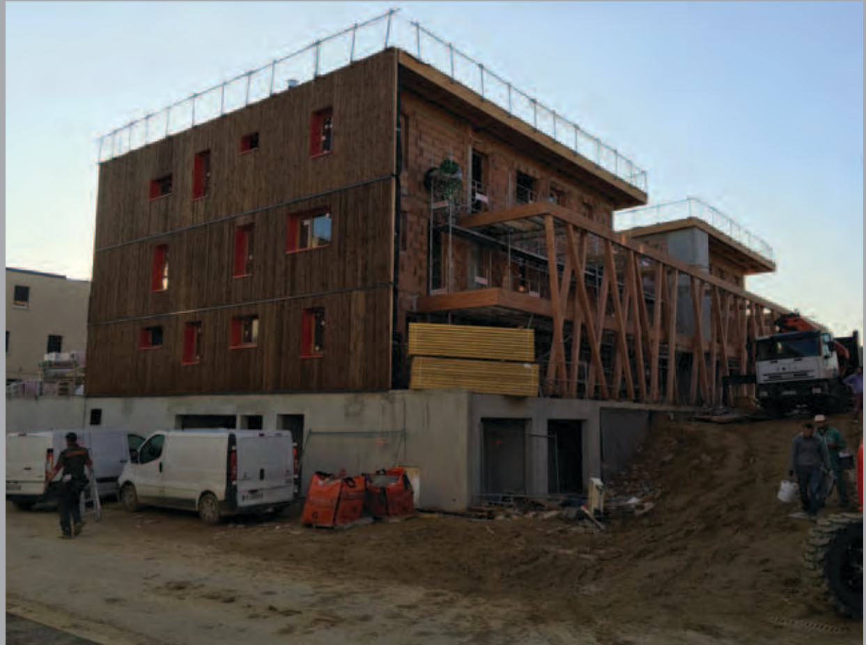
Bâtiment A : mur est avec son bardage, pose des menuiseries.
