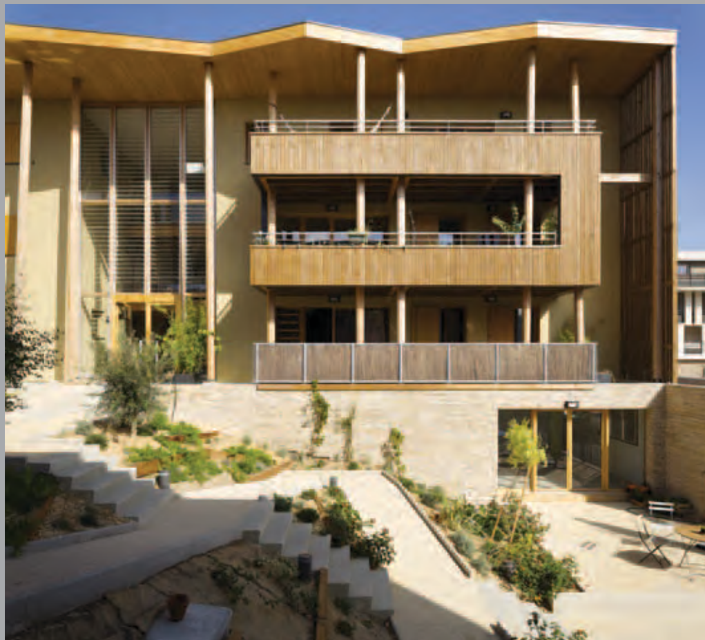
Bâtiment B : façade sud, côté rue (est). Vue sur la salle polyvalente et le patio partagé.
