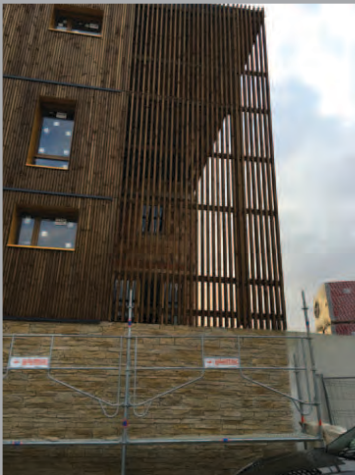
Bâtiment B : bardage à clair-voix pour laisser passer la lumière sur les terrasses.
