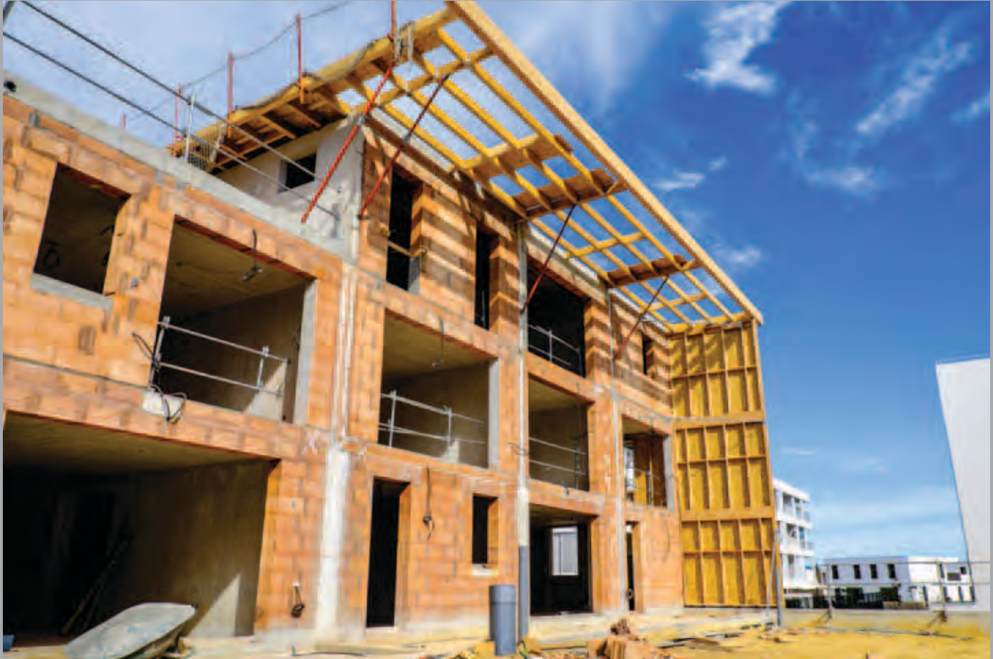
Bâtiment A : façade sud. Vue depuis le jardin sur la charpente et la façade à ossature bois.
