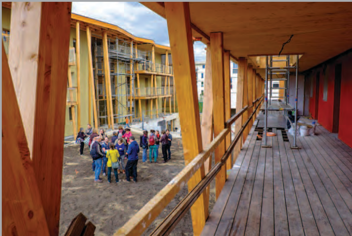
Bâtiment A : la coursive nord du premier étage un jour de visite de chantier.
