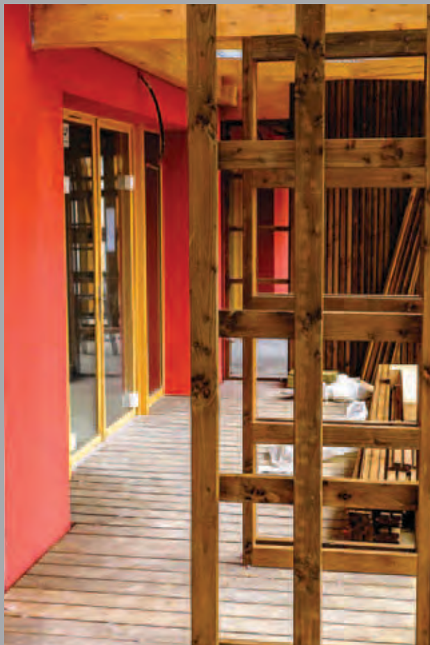
Bâtiment A : sas d'accès aux escaliers en cours de montage.
