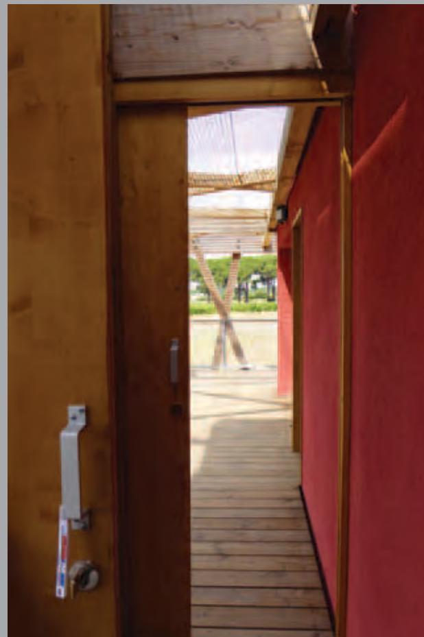
Enfilades de terrasses séparées par un sas (entre les deux portes) donnant sur un escalier commun pour aller dans les jardins partagés.
