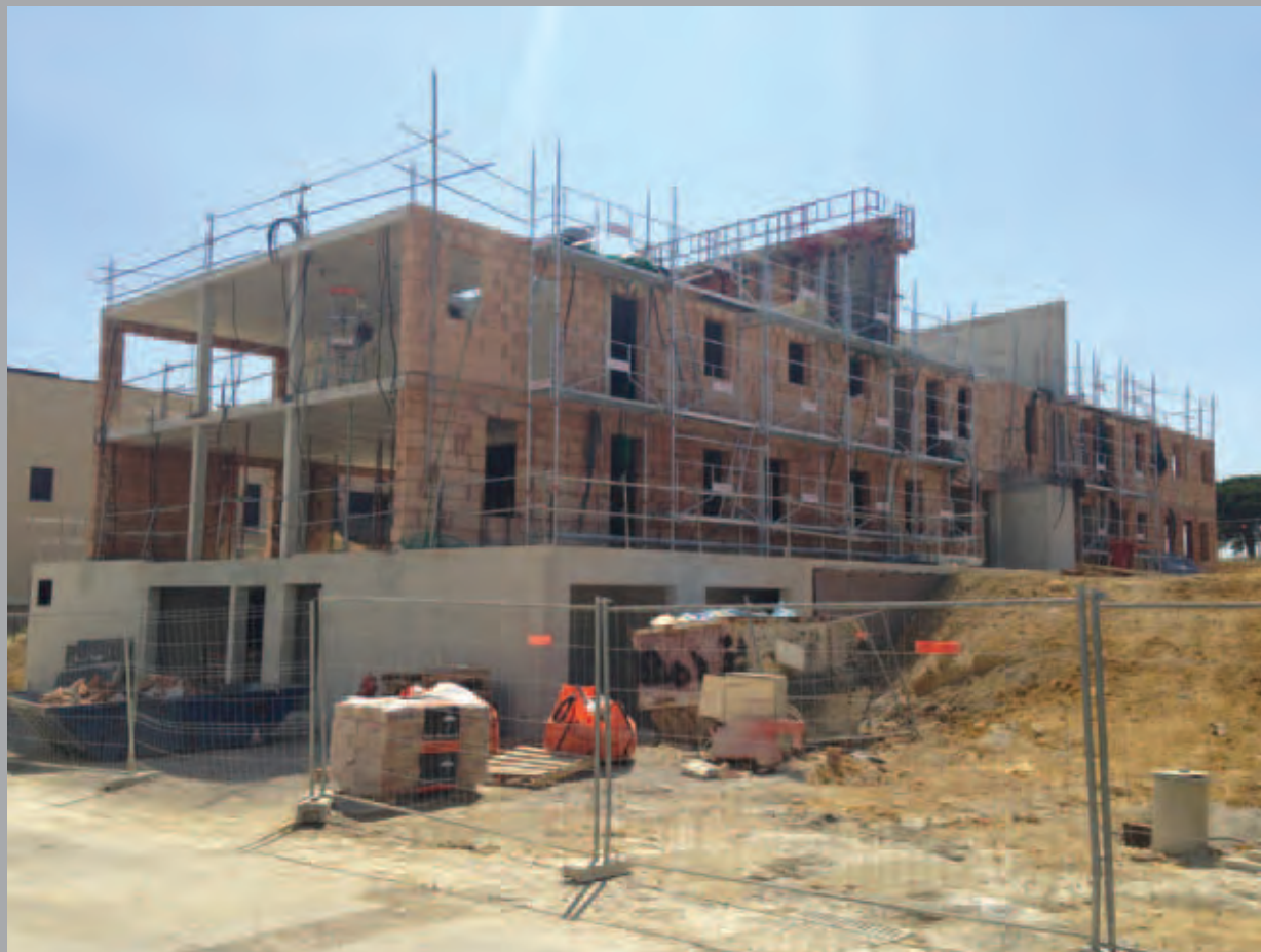
Bâtiment A : façades nord et est. Les bâtiments sont construits avec des refends et dalles béton, les murs extérieurs nord, ouest et sud en brique et les façades est en ossature bois.
