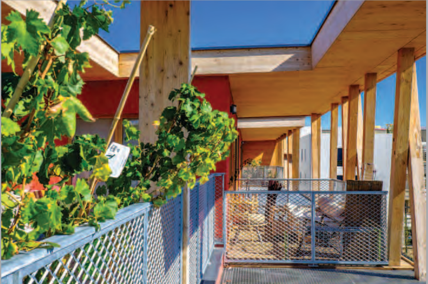
Vue des terrasses sud du bâtiment A, dernier étage.
