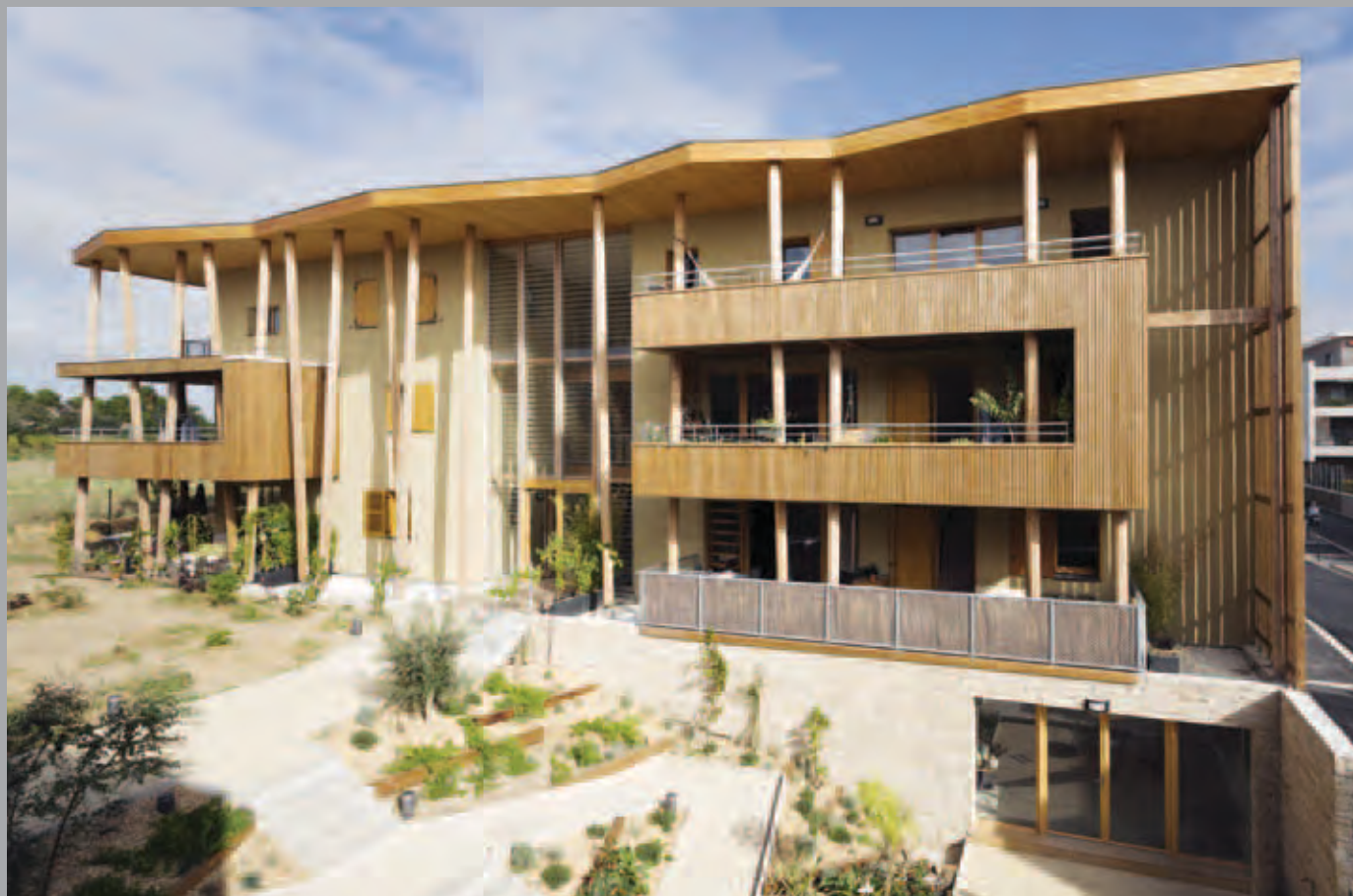
Bâtiment B : façade sud. En bas à droite, la salle polyvalente.
