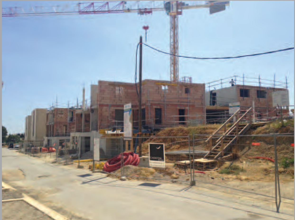
Vue du chantier depuis la rue.
