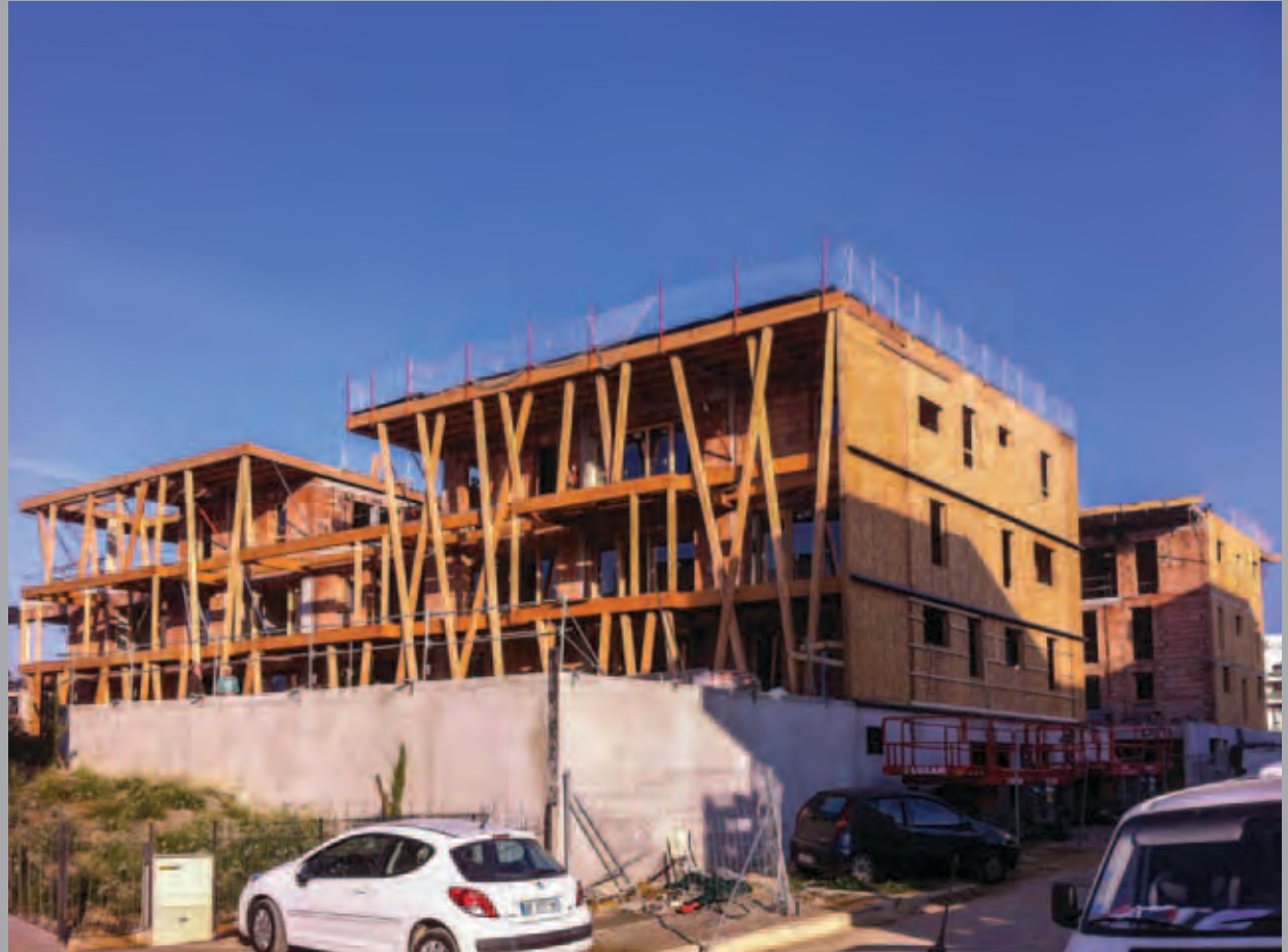
Bâtiment A : façade sud. La résille porteuse des terrasses au sud est bientôt terminée.
