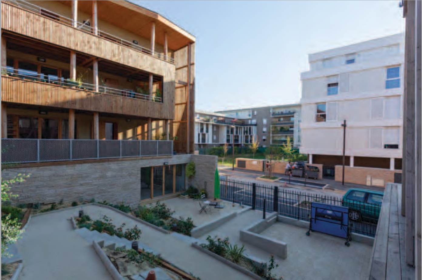
Le bâtiment B, le parvis d'accueil et les bâtiments voisins.
