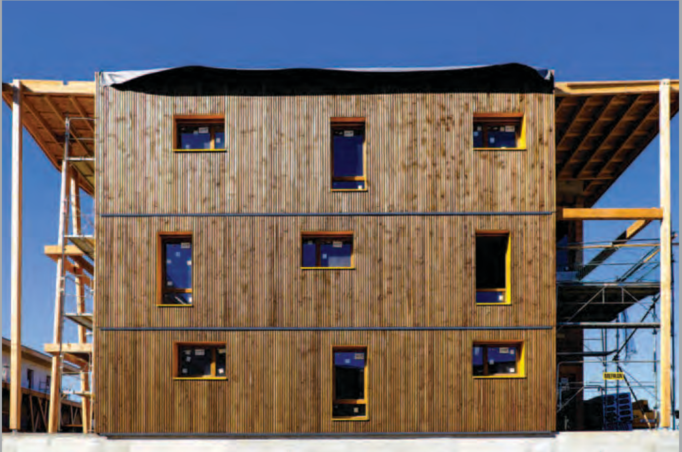
Bâtiment B : façade est. La répartition aléatoire des menuiseries reflète les demandes de chaque habitant.
