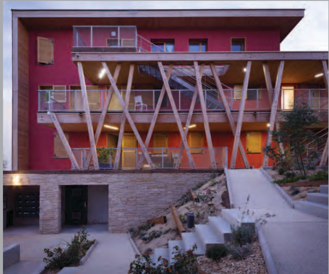
Bâtiment A : façade nord, côté rue (est). Coursives « habitées ».
