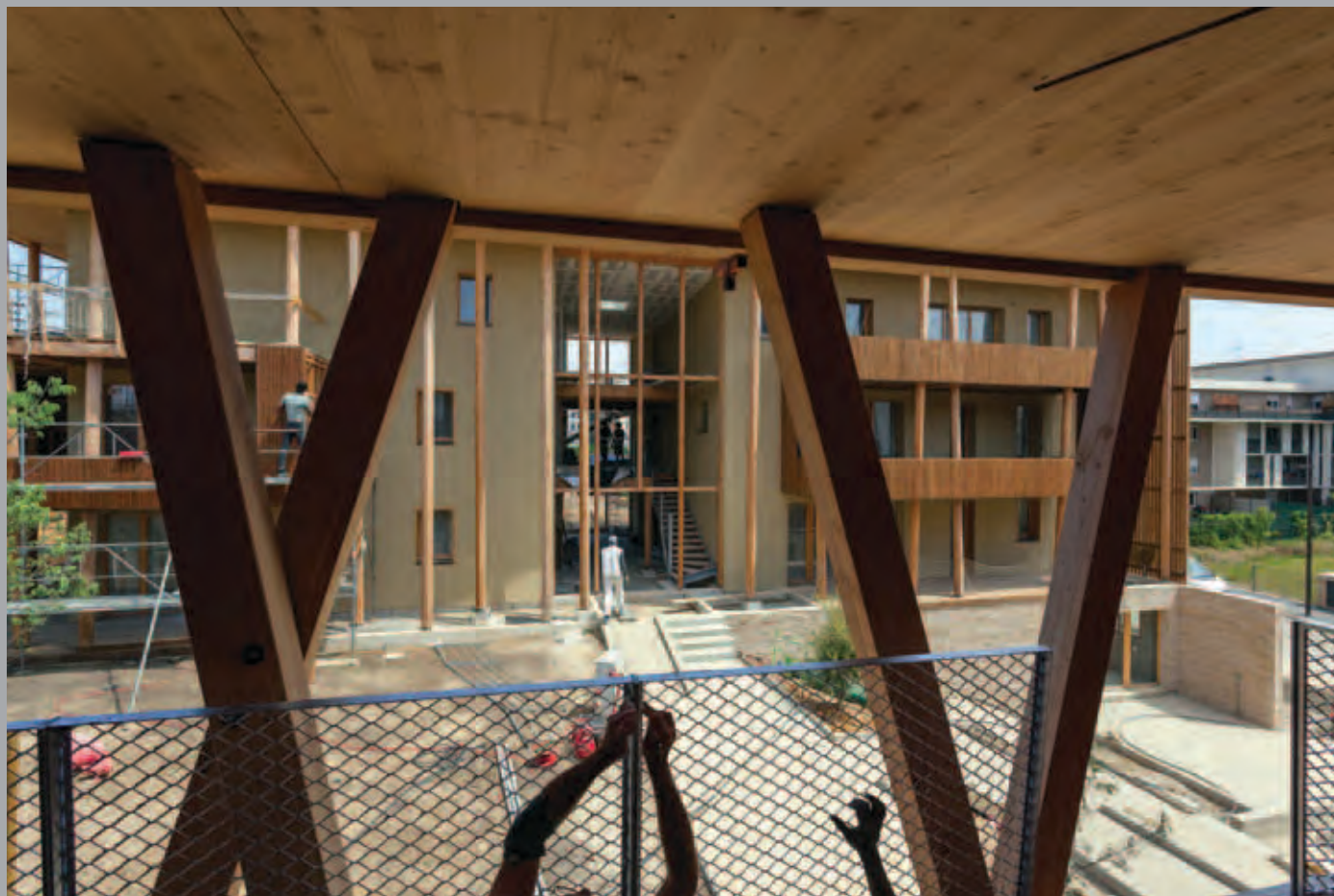
Bâtiment B : vue depuis les coursives du bâtiment A.
