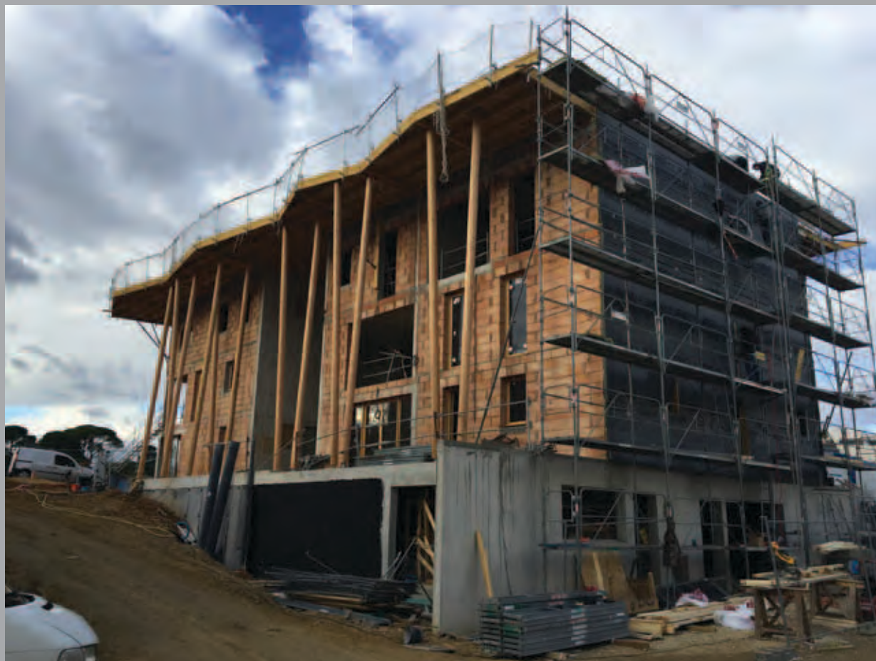
Bâtiment B : façade sud. Les poteaux, éléments porteurs du débord de toiture et le mur à ossature bois (côté rue) en construction.
