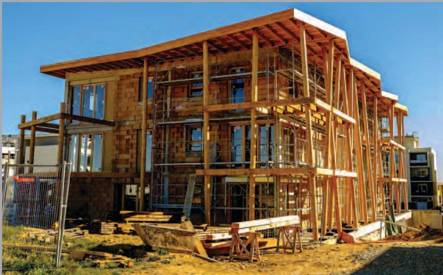
Bâtiment B : accrochage des premiers éléments de terrasses aux poteaux.
