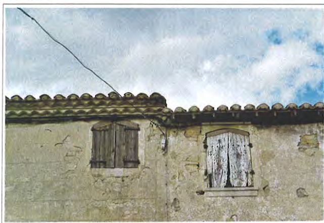
Exemples de génoise à deux rangs et de débords de chevrons
