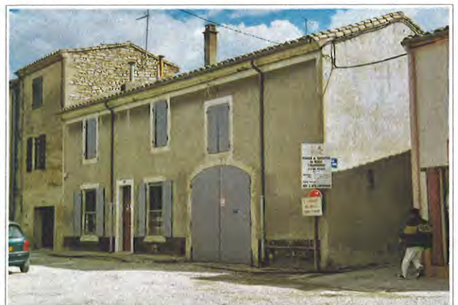
L'ordonnancement original constitue l'harmonie de la façade
