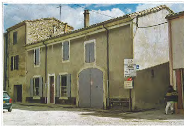
L'ordonnancement original constitue l'harmonie de la façade
