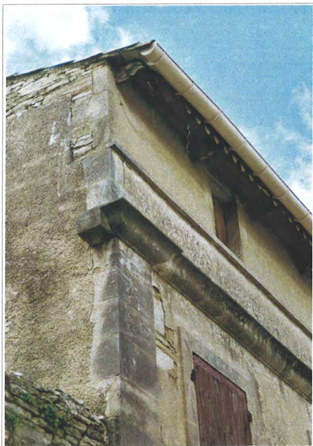
Corniche, bandeaux, chaîne d'angle animent la façade
