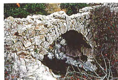
Pont du Passadou
