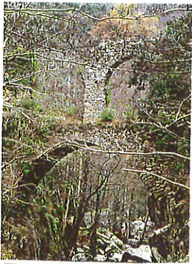
Aqueduc de Gorgues
