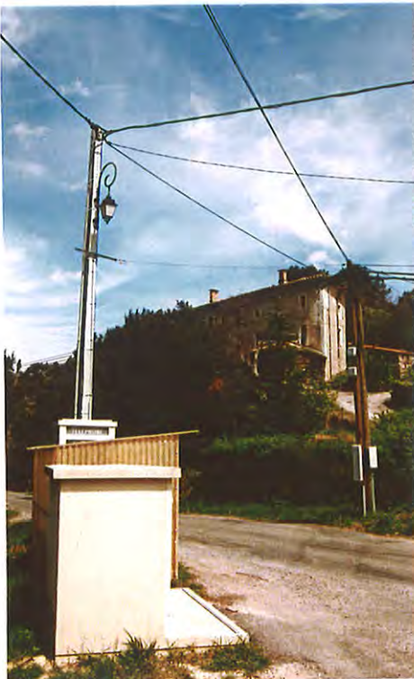
Réseaux à Sanissac
