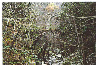
Aqueduc de Gorgues
