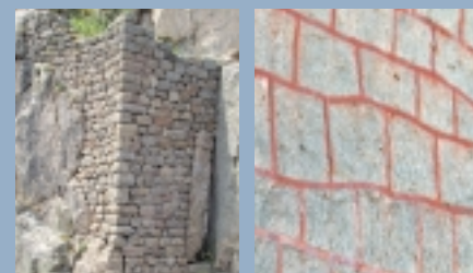
Mur à deux parements
