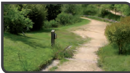
Allée stabilisée en voie de végétalisation. Surdimensionnée à la conception, elle se réduit à la surface pratiquée. Dans ce cas, on conseille de laisser faire. Désherber, quelle qu'en soit la méthode, est inutile.
