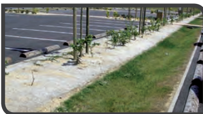
Un fossé sec avec des enrochements permet une bonne gestion des limites et favorise la collecte des eaux de surface et l'infiltration.
