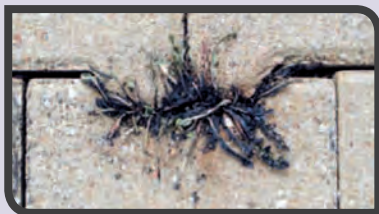
► Désherbage thermique entre pavés autobloquants
