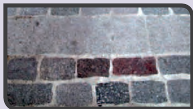
► Pavés en granit avec joints ciment
