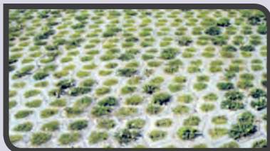
► Dalles alvéolaires intégrant une surface engazonnée
