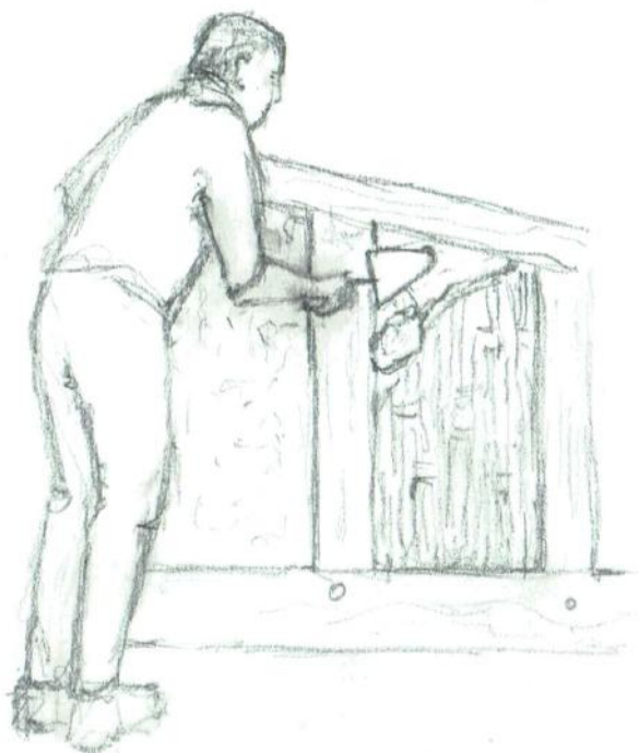
Illustration 27: Pose bourrée ou plaquée : sur un lattis ou sur un clayonnage (espacement inférieur à 4 cm). A la main ou avec un outil (truelle, taloche en bois). Finition par pression verticale. Les deux parements ne sont pas exécutés en même temps. La surface intérieure gagne à être garnie en premier, car elle bénéficie alors d'une ventilation naturelle qui lui assure un séchage plus rapide.
