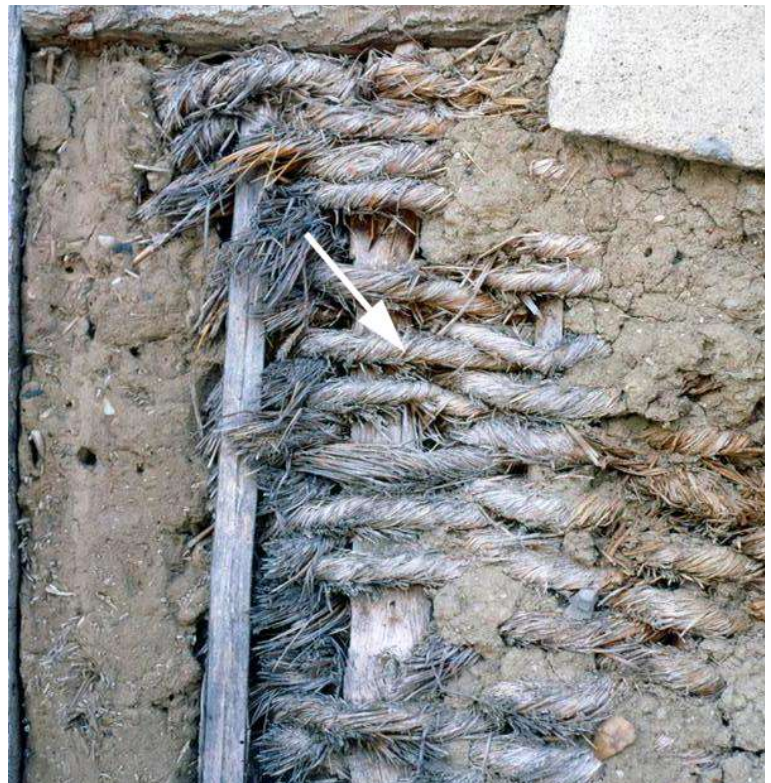
Illustration 21: Détail. De l'illustration 20- La paille est torsadée directement ou après trempage dans une barbotine de terre, puis elle est tressée sur la première trame. (Choplain Roger; Maston Roland)
