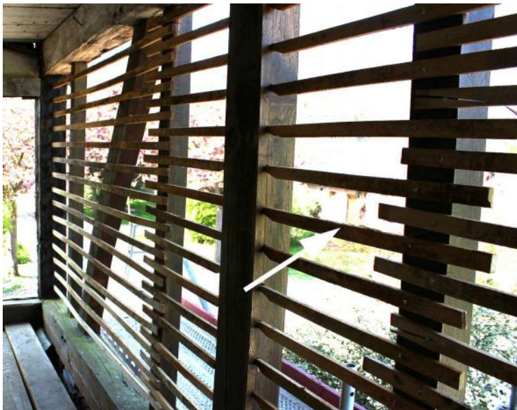
Illustration 16: Lattage formant lattis par endroit (Yan Minne)
