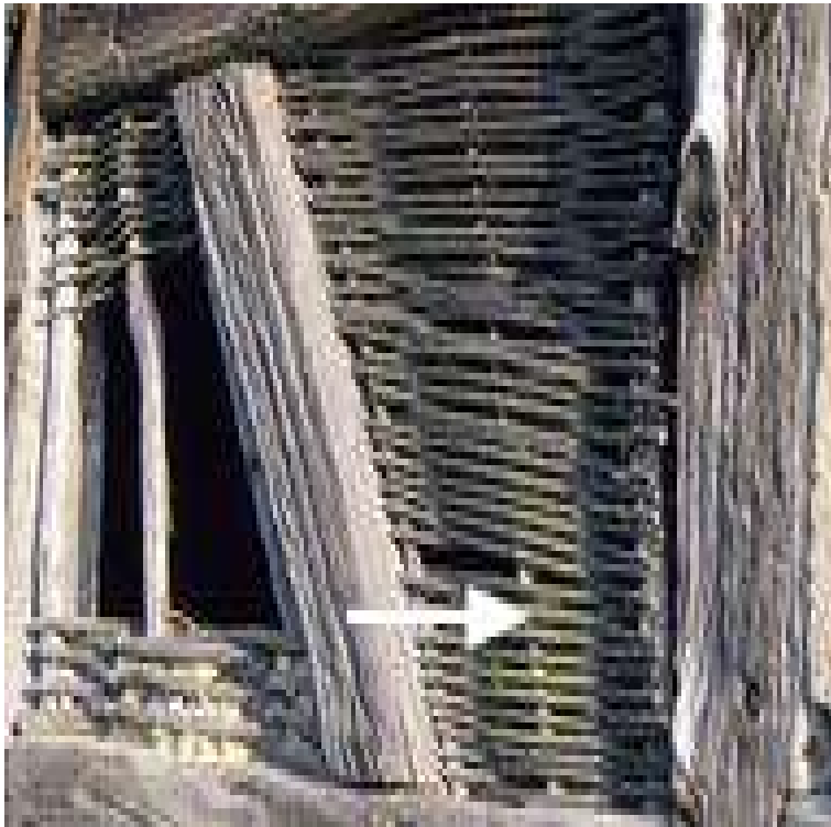
Illustration 22: Clayonnage composé de palançons verticaux en première trame (Fig. 9) et de baguettes horizontales en 2e trame. (© Médiathèque de l'architecture et du patrimoine (Centre de recherche des monuments historiques - CRMH) diffusion RMN, Charles Hurault)
