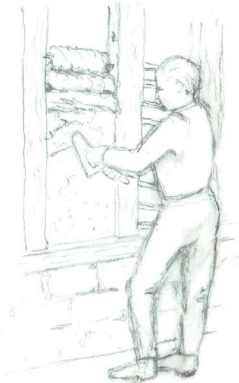
Illustration 31: Finition d'égalisation après pose à cheval ou pose en fusées.
