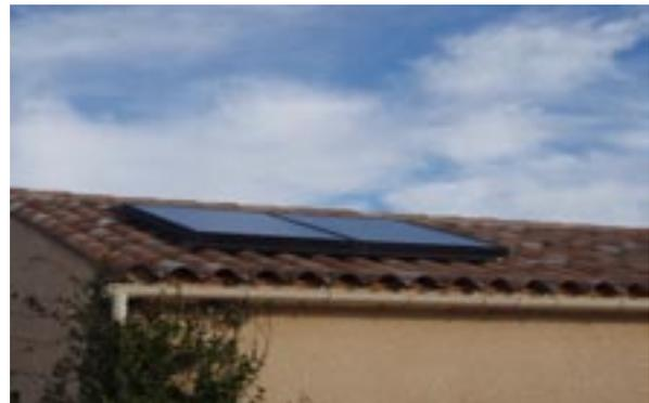
Capteurs en surimposition de toiture (4 m<sup>2</sup> environ de surface de capteurs solaires thermiques pour 200 à 300l d'eau chaude)
