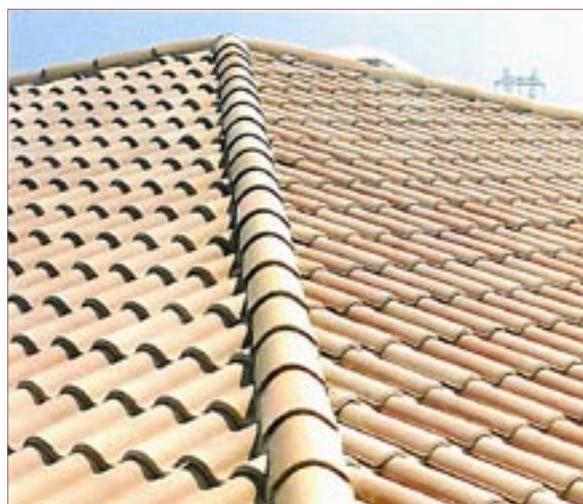
*Tuiles romanes : couverture "mécanique" à l'aspect proche de la tuile canal*
