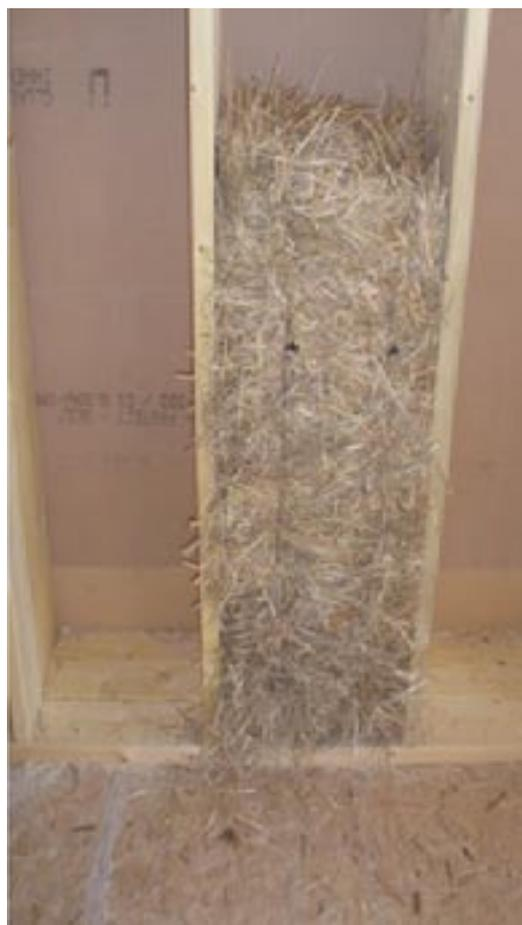
*Remplissage d'une ossature bois par des bottes de paille*
