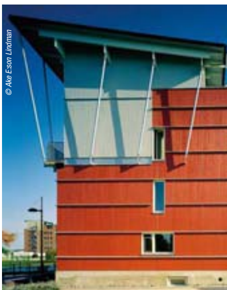
Revêtement de façade en panneaux trois-plis avec lasure, photos prises lors de la réception du bâtiment et huit ans après, sans qu'il y ait eu une rénovation de la finition.
