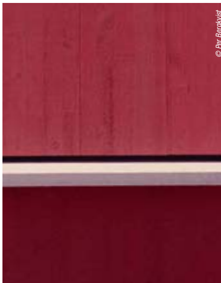
Revêtement de façade en panneaux trois-plis avec lasure, photos prises lors de la réception du bâtiment et huit ans après, sans qu'il y ait eu une rénovation de la finition.
