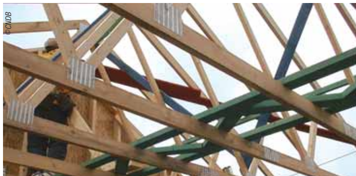
Charpente industrielle cachée en bois massif
