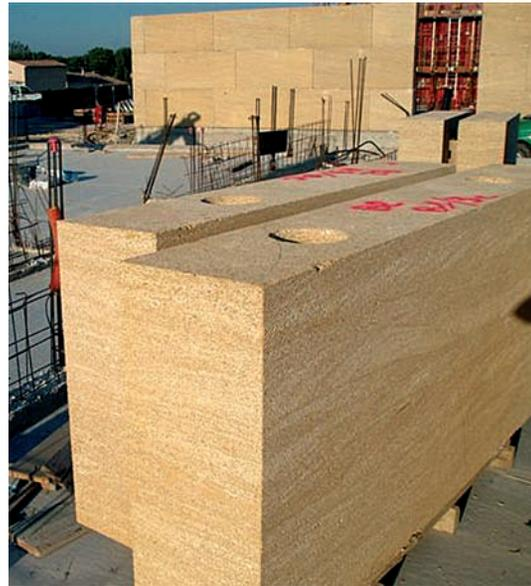
*Pour répondre aux règles antisismiques qui conditionnent l'obtention du permis de construire, de nombreux blocs ont été carottés en atelier. Le plan de calepinage place les blocs, comme dans un gigantesque légo, en situation de recevoir le coulis béton sur armatures, calculé pour répondre à ces impératifs.*
