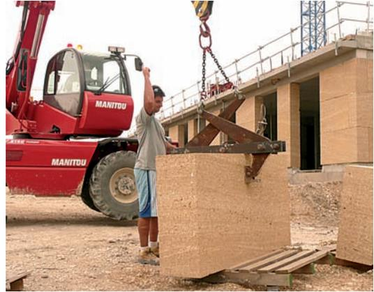
*Les blocs de pierre stockés avant d'être amenés sur le chantier pour être mis en œuvre par empilage maçonné à l'aide d'un chariot élévateur muni d'une pince.*
