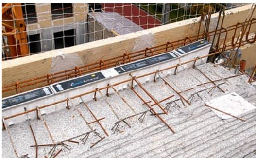
Vue des rupteurs de ponts thermiques installés entre les planchers et la façade en pierre autoporteuse.
