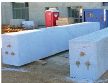
*Chaque bloc avait son emplacement bien défini. Pour leur mise en œuvre, les blocs ont été carottés et des tiges filetées ont été scellées. Une puissante grue équipée d'élingues les ont soulevés et posés sur des massifs en béton parfaitement de niveau. Outre leur côté esthétique, les mégolithes de granit avaient également une fonction de murs porteurs pour la toiture et des passerelles.*
