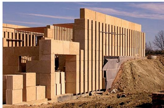
Les blocs de pierre massive sont posés sur une semelle filante qui sert de fondation. Au total, la construction du chai a représenté 3 000 blocs de pierre de Vers Pont-du-Gard, soit environ 1 800 m<sup>3</sup>. Ils ont été fournis par les carrières S.O.C. et Silex.
