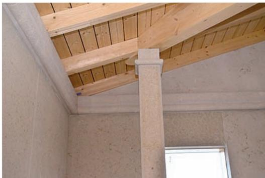
*Au premier étage, les murs intérieurs sont en pierre de Hauteville bouchardée, en tranches de 15 cm d'épaisseur. La corniche est aussi un élément structural de chaînage qui permet de supporter la charpente.*
