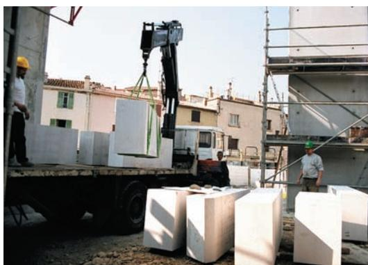
*De la carrière au chantier, avec le minimum d'interventions possibles. Pour répondre à cette nécessité économique, Proroch qui exploite la pierre de Cabéran, s'est équipée d'une débiteuse spécifiquement adaptée à la fabrication des éléments massifs de la coupole de la Sainte-Famille.*
