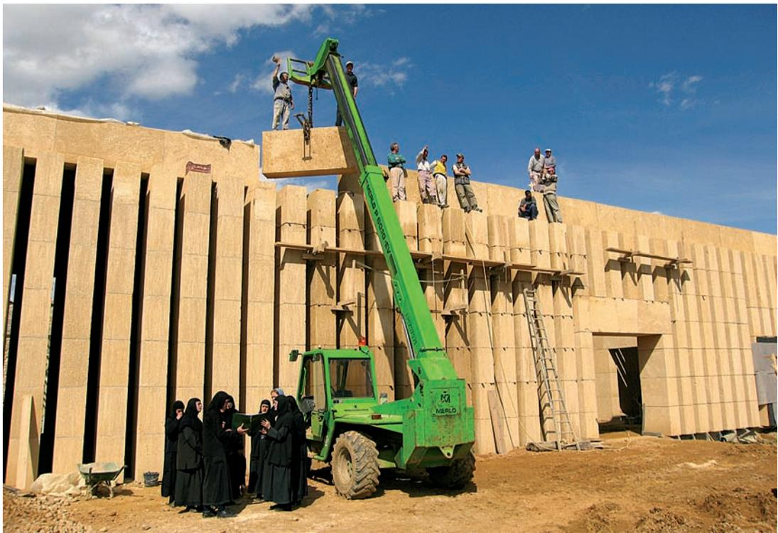
Photo symbolique du chantier qui montre néanmoins la simplicité de la mise en œuvre des blocs. Le chai du Monastère de Solan, un bâtiment de 42 m de long et 16,50 m de large, entièrement construit en pierre massive de Vers Pont-du-Gard.
