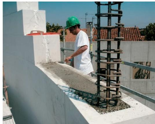
Fraisage des caniveaux et chaînages horizontaux et verticaux qui se rejoignent dans les murs droits et les murs courbes.
