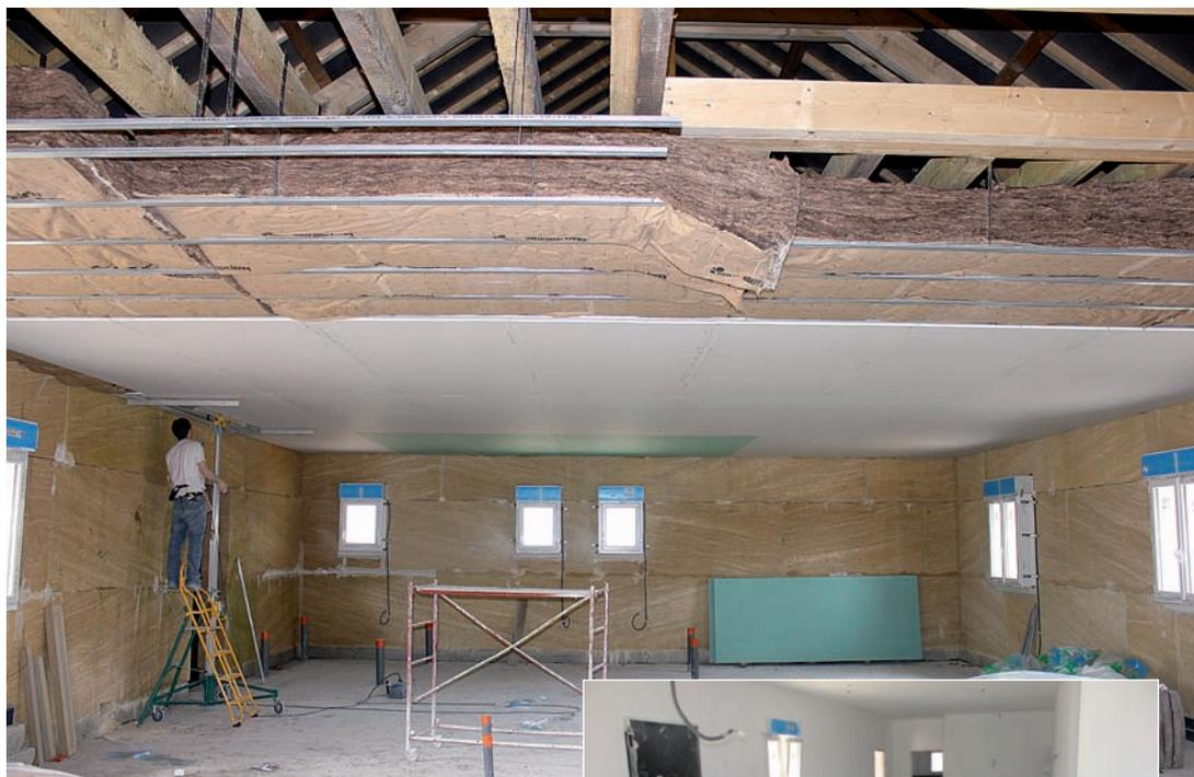
*Isolation du toit avec de la laine de verre de 300 mm d'épaisseur. Les murs ont été isolés avec de la laine de verre de 160 mm d'épaisseur. L'ensemble est plaqué de BA 13.*
