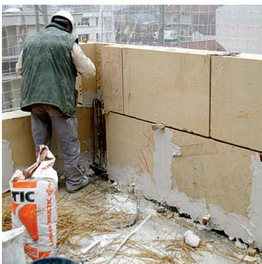
Vues de la pose de la pierre au niveau supérieur, avec coulage des joints au plâtre. C'est l'entreprise MPT qui a assuré la mise en œuvre de la pierre de Noyant.
