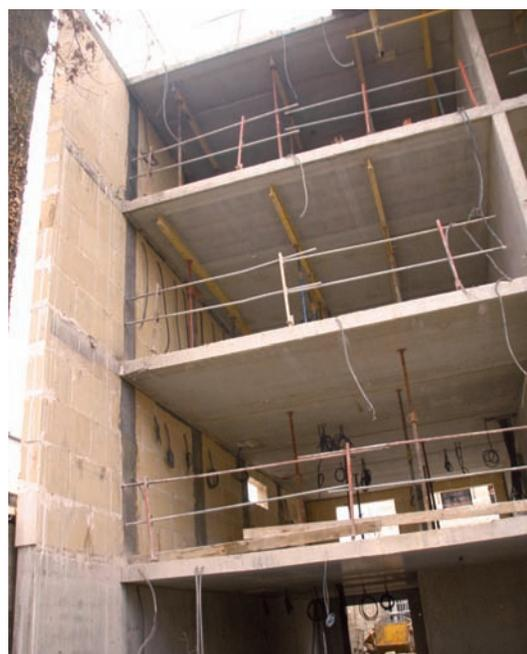
Vues des bâtiments en cours de construction avec le noyau central en béton et les planchers. Les logements bénéficient tous d'un balcon-terrasse en bois.
