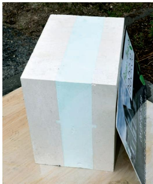
*Quelques vues de la maison construite avec le monomur Pierre Bio'Mur développé par l'entreprise Pierre Bois Habitat. Le panneau sandwich associe deux parements en pierre et un isolant polyuréthane. La maison est construite sur des fondations de type puits et longrines.*
