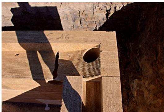
Détail sur les angles de murs, avec le carottage réalisé pour le coulage des raidisseurs verticaux en béton afin de répondre aux normes parasismiques.
