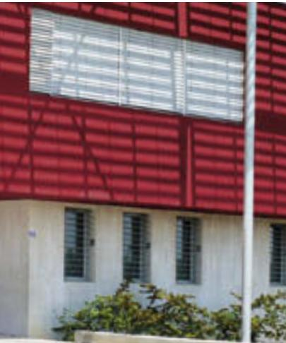
*La façade sud est protégée par une vaste ombrière. Au rez-de-chaussée, des lames horizontales servent de grilles anti-intrusion et de brise-soleil.*
