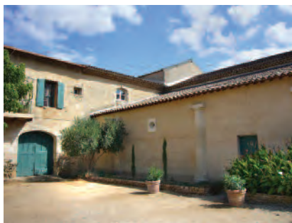
Bonne intégration au bâti ancien d'une partie récemment rénovée.
