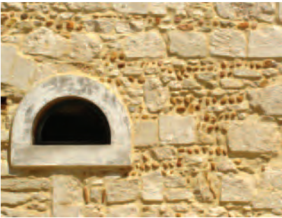
Un détail de la façade, récemment décastrée et rénovée.
