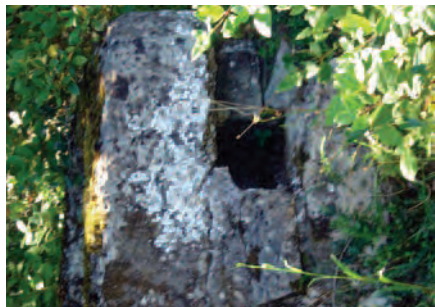
Puits en cours de réhabilitation.
