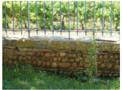
Parement mixte pierres-galets pour ce mur de clôture.
