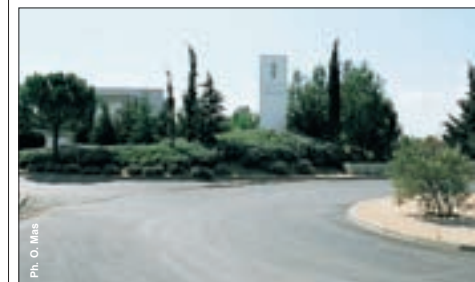
Vendargues - ZAE «Le Salaison» Le traitement des abords des bâtiments joue un rôle primordial notamment pour l'image de l'entreprise
