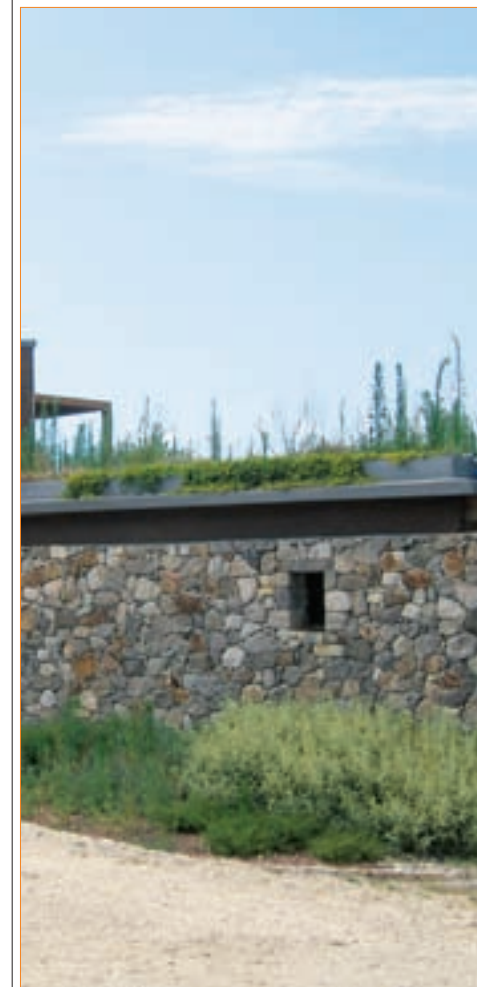
Toiture végétalisée - Concepteur Benoît Gillet, architecte
