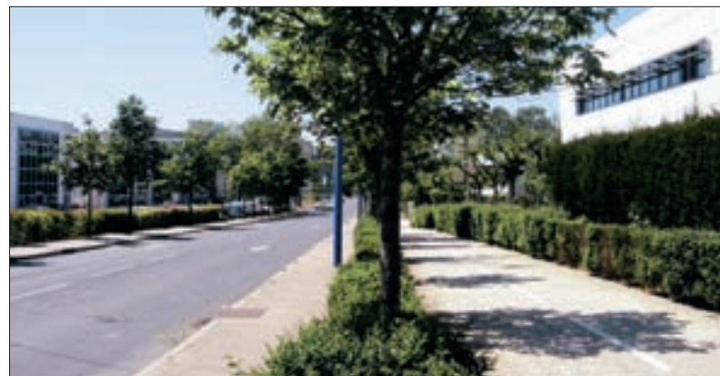
Montpellier - ZAE «Le Millénaire» Voirie, cheminement piétonnier et piste cyclable
