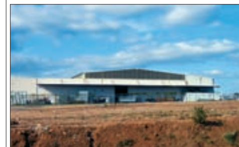
Bâtiment actuel avant extension
