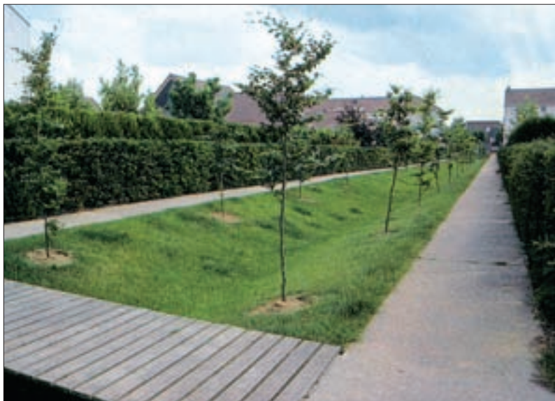
La double fonction d'une noue : le stockage et la régulation des eaux de pluie ainsi que l'agrément paysager.
