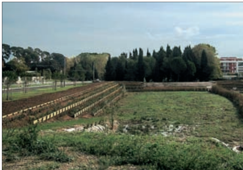
Montpellier - Le bassin de rétention du quartier Malbosc
