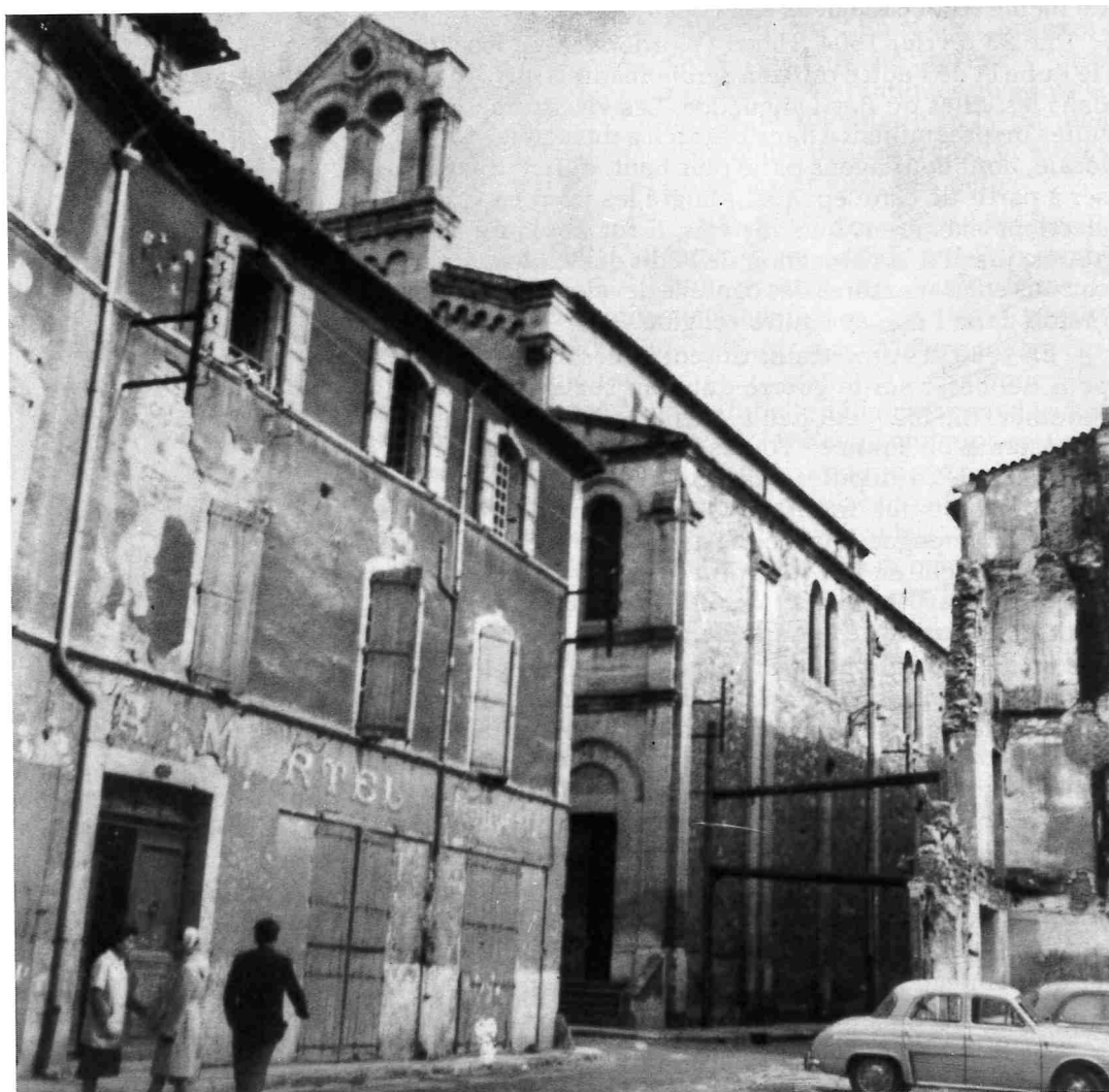
Au temps de la démolition d'Alès, la rue Peyrolerie, le Temple avec la Maison Martel Textiles aujourd'hui démolie.
