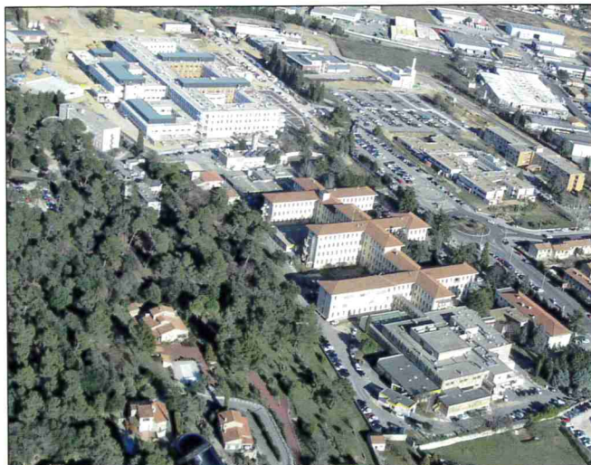
Ci-dessous : ancien et nouvel hôpital lors de sa construction
