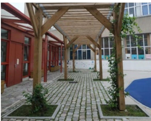
Pergola en bois avec ancrage au sol dans des fosses de pleine terre, cour Oasis de l'École Emile Levassor. © CAUE de Paris
