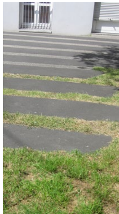
Asphalte découpé, aménagement paysagé, La Courneuve © CAUE de Paris
