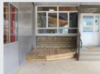
Plateforme en bois de la cour Oasis de l'École maternelle Maryse Hilsz.
