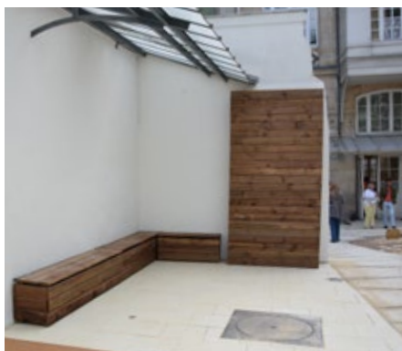
Récupérateur d'eau, cour Oasis de l'école Quatre fils, Paris. © CAUE de Paris
