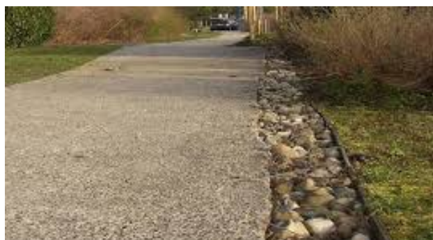
Tranchée drainante © Grand Lyon
