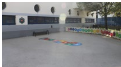
Enrobé drainant, école Daumesnil, Paris © CAUE de Paris
