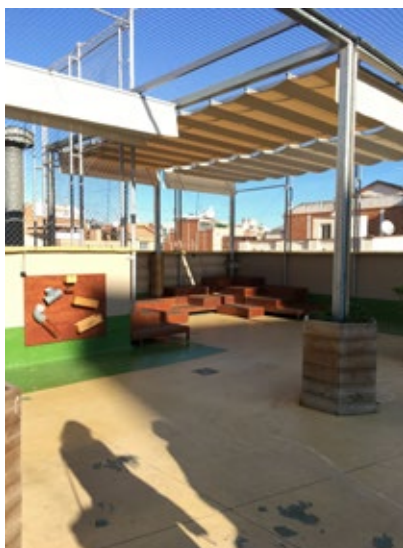
Voiles rétractables, école Dovella à Barcelone par Raons públiques et Coeducació © CAUE de Paris
