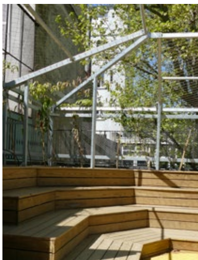
Pergola ajourée en porte-à-faux, treillis. Cour Oasis de l'École Parmentier © CAUE de Paris
