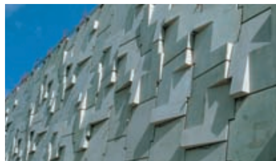
Autoroute A 40. Mur de soutènement en éléments préfabriqués en béton.
