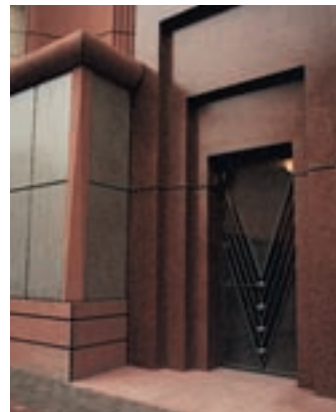
Manolo Nuñez, logements Batman, Alfortville. Entrée d'immeuble réalisée à l'aide d'éléments en béton lasuré rouge foncé et gris.
