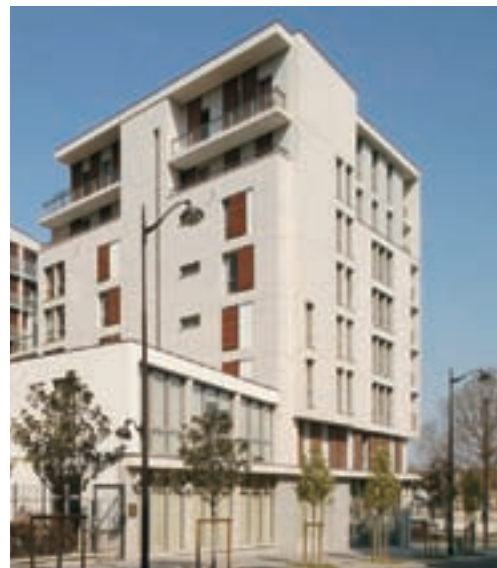
Catherine Furez, logements Zac Masséna, Paris. Façades composées de panneaux préfabriqués en béton beige poli.
