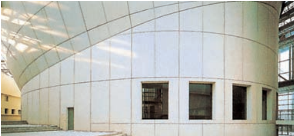
Christian de Portzamparc, Cité de la musique, la Villette. Éléments d'habillage issus d'un calepinage rigoureux.
