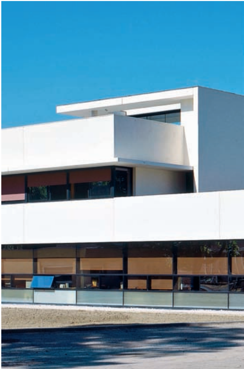
J.-B. Bethgnies et S. Leclair, laboratoire de l'INRA, Avignon. Éléments de façades de l'étage préfabriqués en béton blanc.
