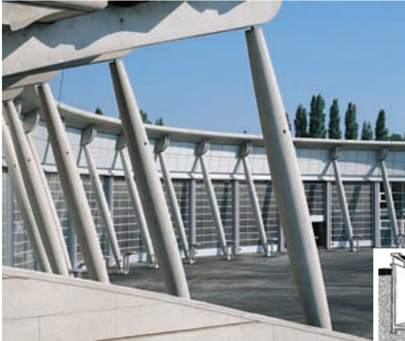
SCPA Béguin et Macchini, centre d'entretien routier, Argenteuil.
