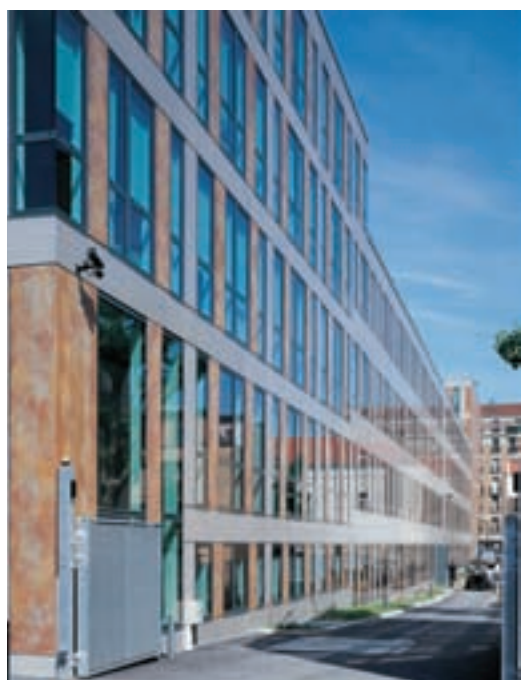
B.-J. Hubert et M. Roy, siège social, Montreuil. Façade en panneaux de béton préfabriqués.
