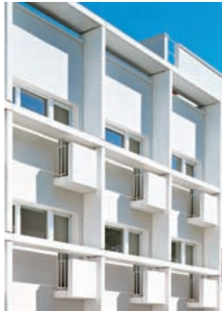
B. Dollé et C. Labbé, Logements, Palaiseau. Éléments préfabriqués pour quadriller la façade.
