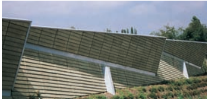
Douillet et Ritz, déviation de La Bergue (74). Mur antibruit avec bardage absorbant.
