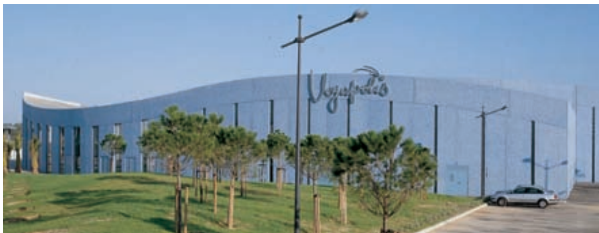
Atelier d'architecture Chaix et Morel et Associés, patinoire, Montpellier. Éléments de façade préfabriqués en béton bleu.
