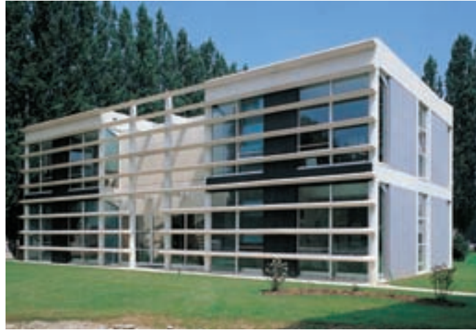
B. Dollé et C. Labbé, Logements, Palaiseau. Éléments préfabriqués pour quadriller la façade.
