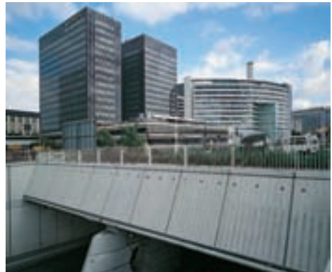
SCPA Arretche - Karasinski, passage dénivelé, Pont Charles-de-Gaulle constitué d'éléments en béton poli.
