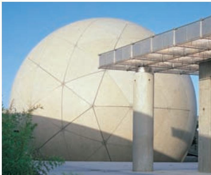
François Fontès, lycée Jean-Monnet, Montpellier. Enveloppe sphérique en béton blanc poli constituée d'éléments préfabriqués d'une grande précision dimensionnelle.
