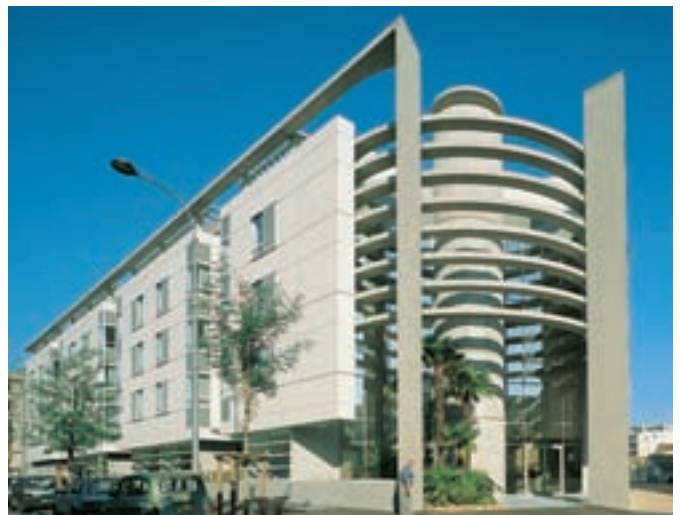
Brigitte Hellin et Hilda Sebbag, résidence hôtelière, Montpellier. Panneaux de béton blanc poli associés à des poutres pare-soleil.
