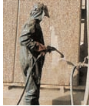
Traitement de finition par lavage au jet d'eau d'un béton préalablement désactivé.
