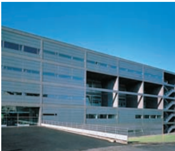
Jean Guervilly, centre de rééducation de Plémet. Éléments de coffrage préfabriqués associés au béton coulé en place.
