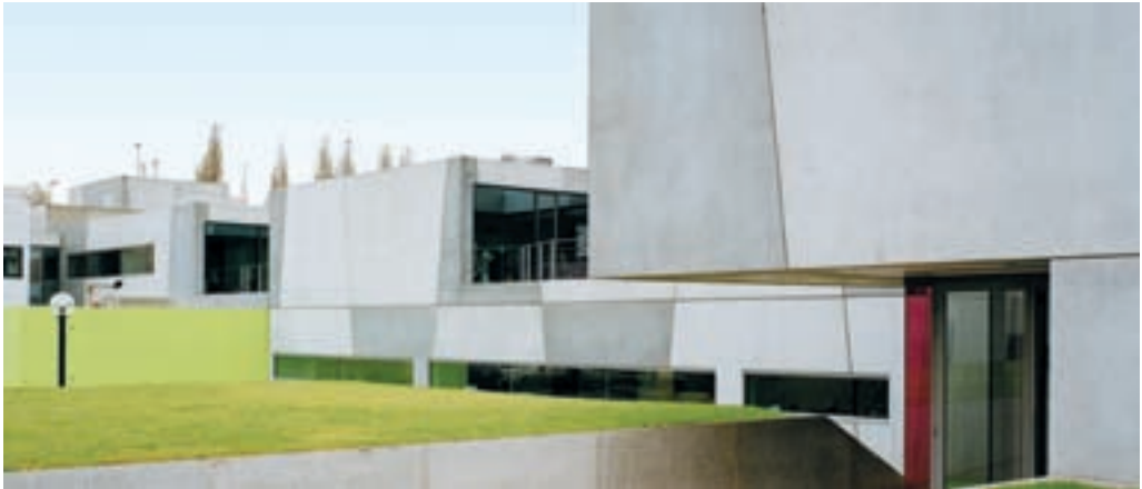
Vialet Architecture, laboratoire, Caen. Panneaux préfabriqués en béton, de deux tons différents, protégé par une lasure minérale.
