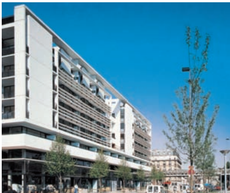
Jacques Ripault, logements Quai-de-la-gare, Paris. Lames horizontales contribuant à l'isolation acoustique du bâtiment.
