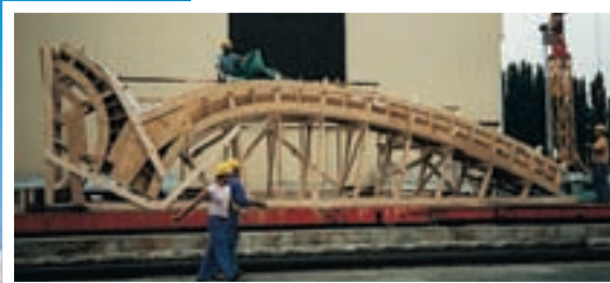
Flore Bringand, candélabres, Issy-Les-Moulineaux. Forme complexe présentant un porte- à-faux qui nécessite l'utilisation de béton précontraint par post-tension.
