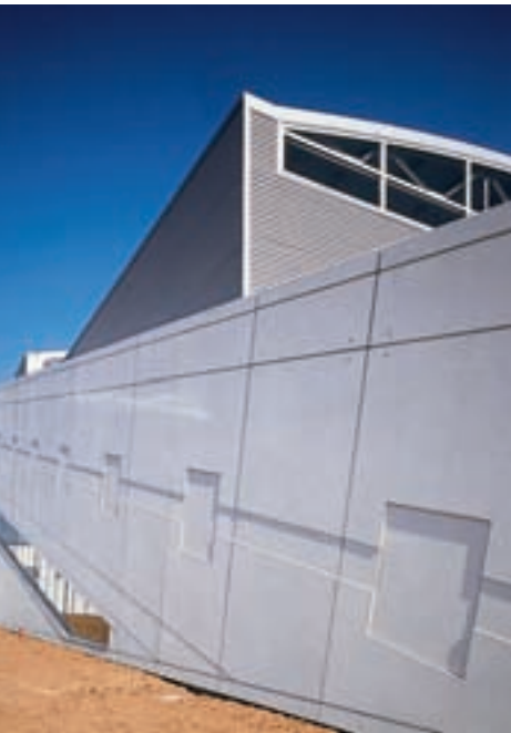
M. Labbé, station d'épuration, Arras. Les bâtiments sont masqués par un voile en panneaux de béton préfabriqués.
