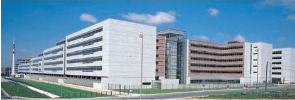
Denis Vallode, Jean Pistre et Philippe Matsakis, siège d'Air France, Roissy. Le béton architectural non porteur permet d'exploiter la multiplicité des états de surfaces offerts en préfabrication.
