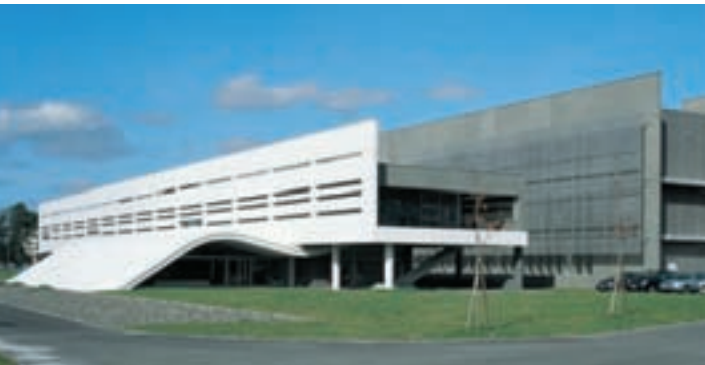
Franck Hammoutène, IECB, Pessac. Panneaux de façade préfabriqués en béton blanc et éléments de parement en béton préfabriqué de teinte grise.
