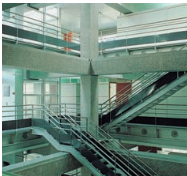
3A – Durand-Ménard-Thibault, Crédit industriel de l'ouest, Nantes. Pour la réalisation de cette structure en béton poli, toutes les poutres sont descendues verticalement à leur position définitive, aucun déplacement transversal n'étant possible. Un micro-béton sans retrait est coulé en final dans le volume de scellement constitué par les abouts des différents éléments.
