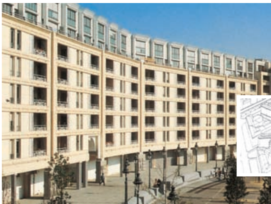
Stanislas Fiszer, place Chalon, Paris. Éléments de façade porteurs en béton de granulats de Seine associés à un ciment blanc. Finition acidée pour imiter l'aspect pierre de taille.
