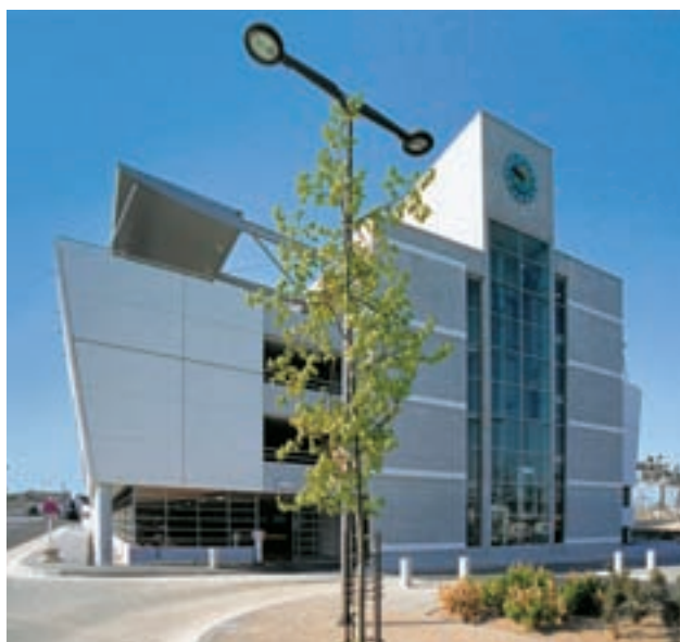
D. Jousset, parking-relais de la gare, Fleury-les-Aubray. Façades en faux aplomb habillées de panneaux préfabriqués en béton poli.
