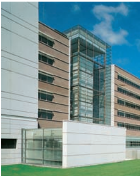
Denis Vallode, Jean Pistre et Philippe Matsakis, Air France, Roissy. Façade suspendue à la structure offrant une grande souplesse de mise en œuvre.
