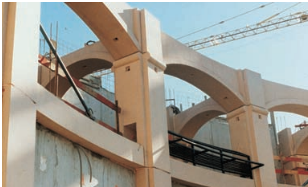
3A – Durand-Ménard-Thibault, Crédit industriel de l'ouest, Nantes. Pour la réalisation de cette structure en béton poli, toutes les poutres sont descendues verticalement à leur position définitive, aucun déplacement transversal n'étant possible. Un micro-béton sans retrait est coulé en final dans le volume de scellement constitué par les abouts des différents éléments.
