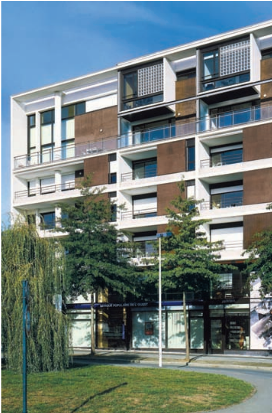
M. Kagan, logements, Rennes. Façade constituée d'éléments préfabriqués lasurés blancs, de couleur terre de sienne ou recouverts d'un enduit de couleur blanche.
