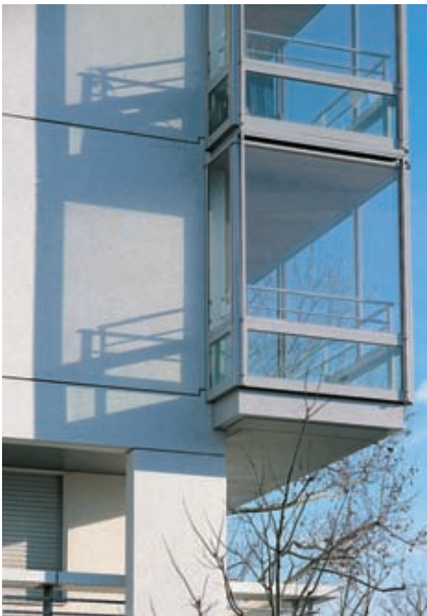
Daniel Kahane, logements, Porte d'Aubervilliers. Détails de joints en façade.
