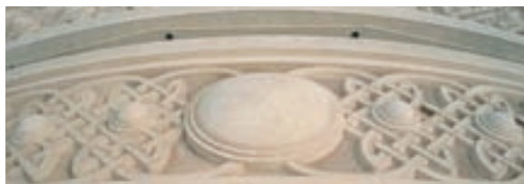
Skidmore Owings & Merrill, FC2, Canary Wharf, Londres. Entrelacs réalisés dans un moule élastomère permettant une reproduction parfaite du modèle.
