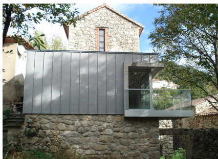
Extension de maison, TAUTEM Architectes, assurant à la fois la couverture, le bac-acier bloquant l'oxydation, pour traiter à la fois les façades et la toiture d'une maison cévenole, Yann Roubeau architecte
