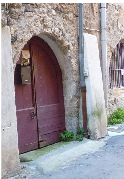
Portail en bois à 2 vantaux ouvrant à la française
