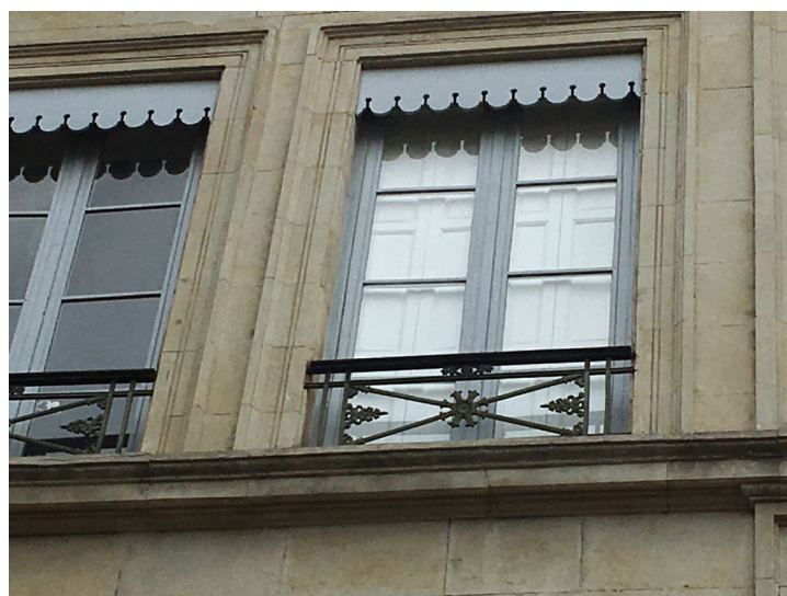
Exemple de lambrequins métalliques festonnés peints protégeant les stores de baies
