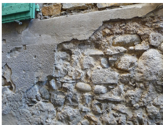
Appareil de tout-venant (éléments bruts d'extraction) et galets de rivière
