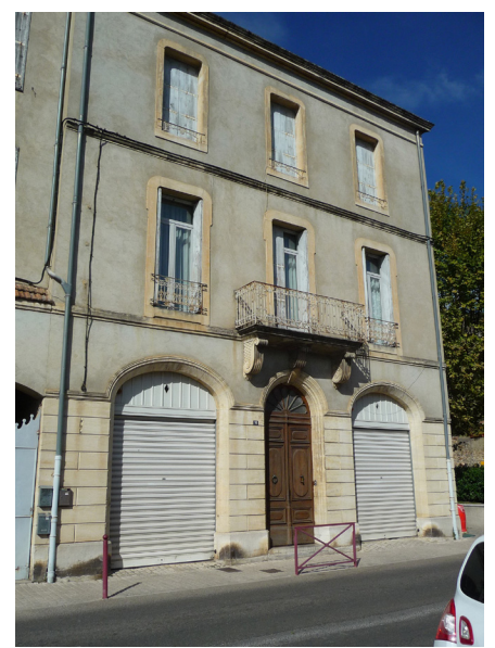
Façade XIXe à 3 travées et balcon au 1er étage, axé sur porte piétonne ; composition symétrique affirmée
