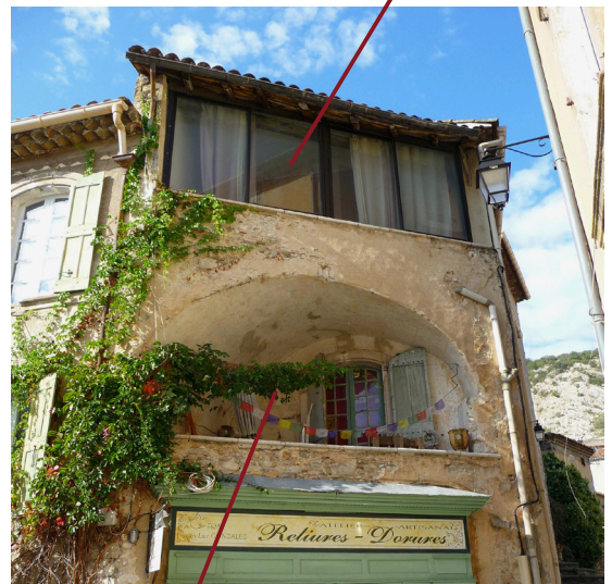
Loggia à conserver en l'état
