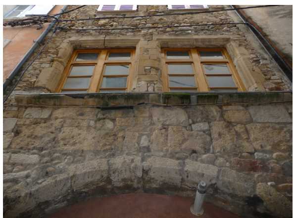
Vestiges de croisées (fenêtres à meneaux et traverses)
