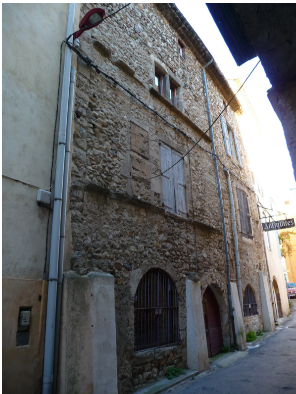
Sur cette façade, traces de vestiges Renaissance : bandeaux de longueur d'étages au niveau des appuis de fenêtres, meneaux et traverses d'anciennes croisées, 3 grandes portes cintrées (anciennes échoppes et porte cochère?)
