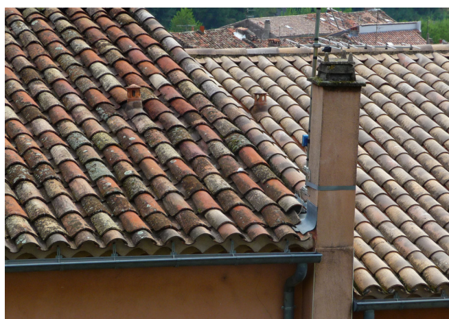
Couvertures en tuile ronde : à gauche, tuiles de récupération; à droite, tuiles neuves «vieillies»
