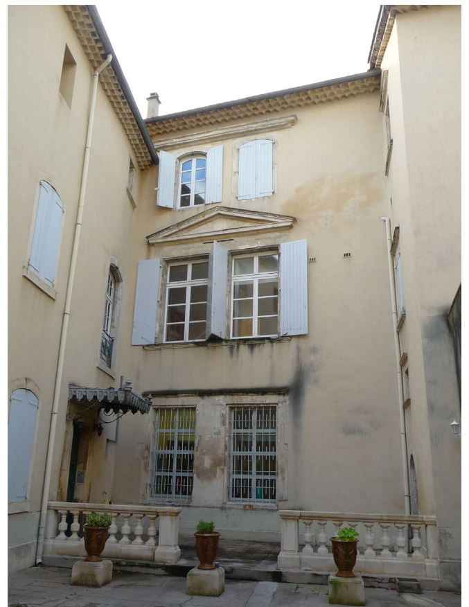
Façade présentant des vestiges de décor XVII e : fronton triangulaire, bandeaux marquant les étages et les appuis de fenêtre. (A noter : la balustrade s'inspire d'éléments des XVI-XVII e , la marquise métal peint et zinc est XIX e ...)
