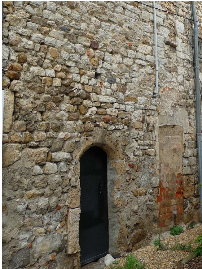
Appareil de tout-venant et de moellons dégrossis
