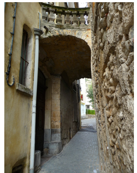
Passage reliant l'étage de 2 bâtiments et faisant office de balcon
