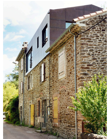
Extension contemporaine traitée avec des tôles métalliques stabilisées par une solution compatible avec une architecture contemporaine de qualité
