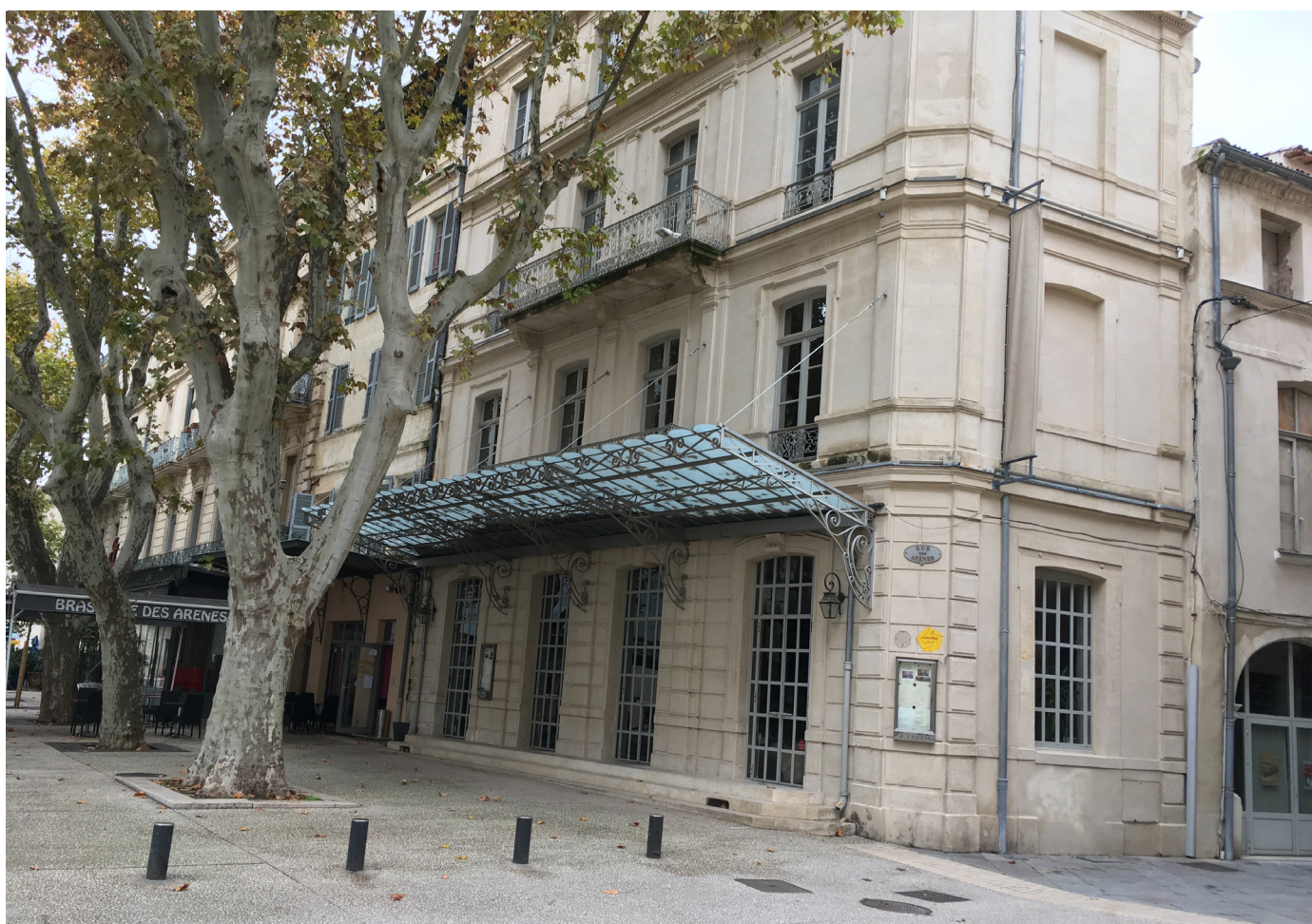
Marquise couvrant la terrasse d'un restaurant nîmois, en métal et macrolon, porté par des consoles métalliques et soutenu par des câbles fixés sur la façade.
