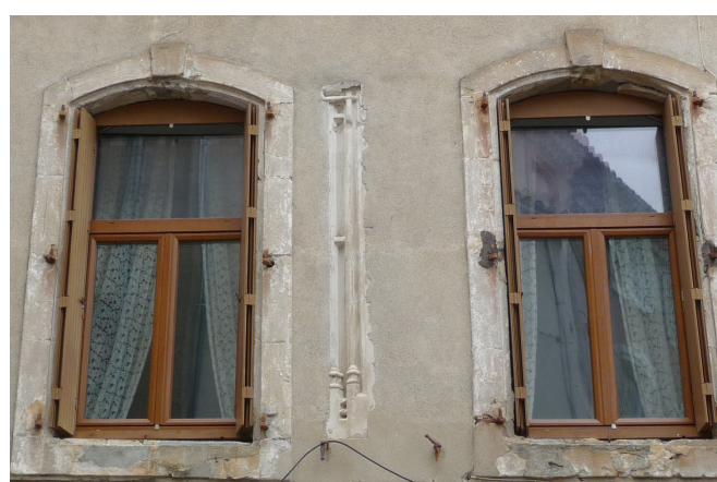
Vestige de meneau d'une ouverture Renaissance modifiée lors de la création de 2 baies du XVIIIe siècle
