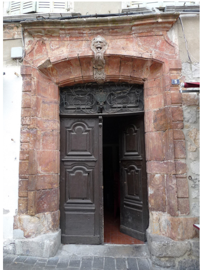
Porte piétonne à chambranle en granit rouge avec fronton en trapèze curviligne, clé de linteau saillante avec décor de masque grimaçant
