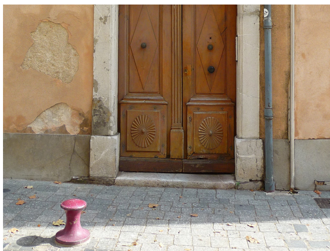
Soubassement en saillie, plus foncé que l'enduit de façade
