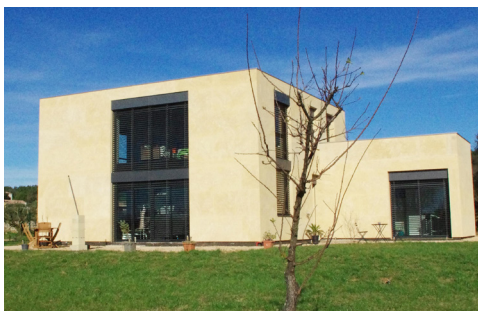
Villa dans l'Uzège, François Privat architecte Volume simple, frisant l'austérité, percements limités à quelques grandes baies, pour cette villa réalisée en blocs de pierre de Vers-Pont-du-Gard
