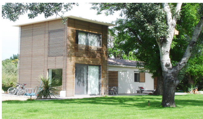
Maison, Emmanuel Delmas architecte Dans cette extension, le bardage ajouré en lames de bois assure à la fois les fonctions de brise-soleil, garde-corps et volets coulissants et la parure esthétique de la construction
