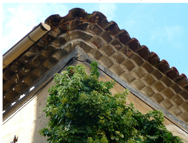
Génoise traditionnelle à 3 rangs de tuiles
