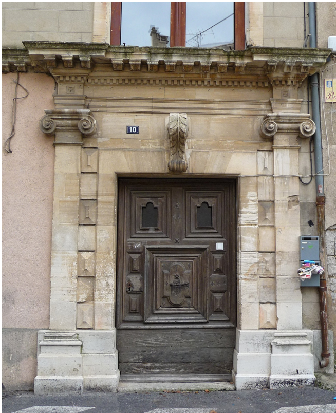
Porte piétonne à chambranle en pierre avec pilastres de type ionique, entablement souligné d'une corniche à denticules, clé ornée d'une console à décor de rameau de laurier, huisserie en bois à panneaux (médaillons percés et bossages en pointes de diamant, de style Louis XIII)
