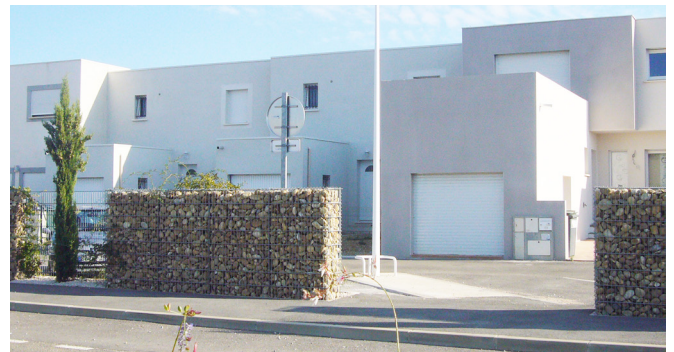
Ici des gabions, non pas utilisés en parement de façades mais pour réaliser des murs de clôture
