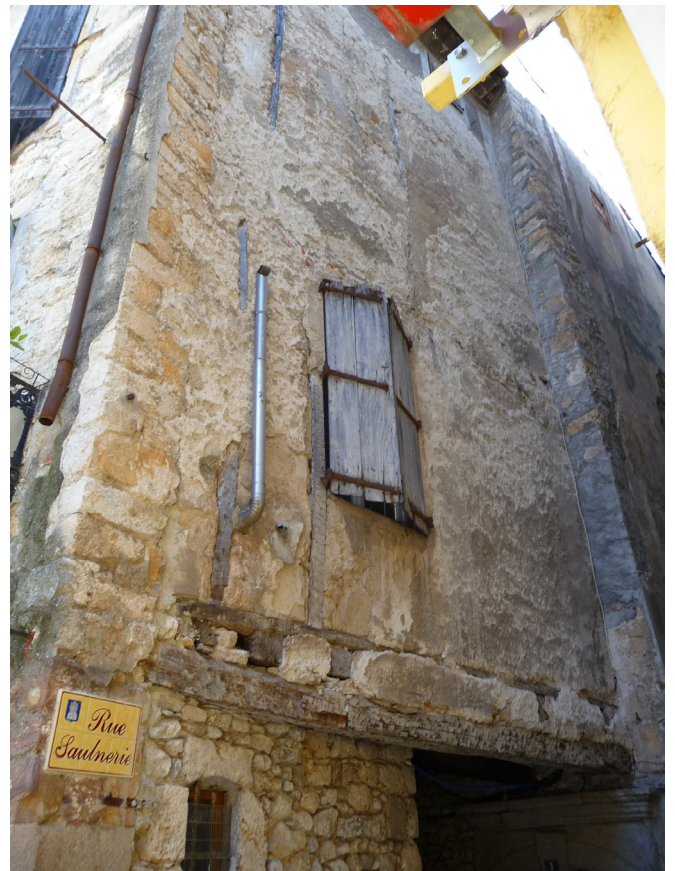
Maison dont le rez-de-chaussée en pierre est surmonté d'étages en pans de bois
