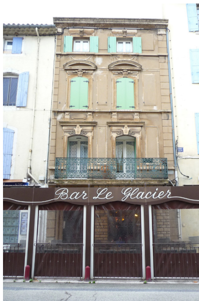
Façade XIXe à 2 travées et balcon filant au 1er étage. Décor éclectique et néo-classique
