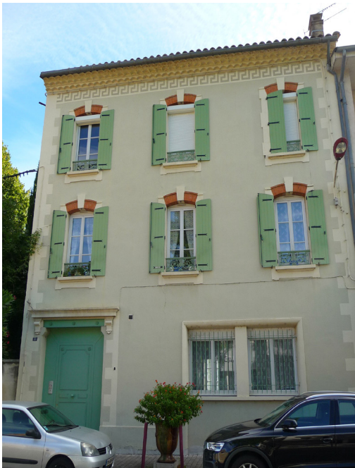
Façade début XXe, encadrements de baies en appareil mixte pierre et briques rouges
