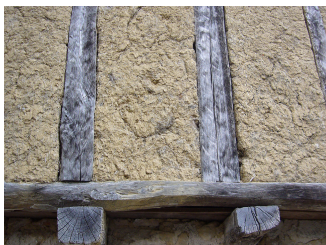
Paroi à pans de bois et remplissage en torchis (on distingue les éléments de paille mélangés au liant)
