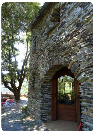
Mur en pierre et ouverture en plein cintre.
