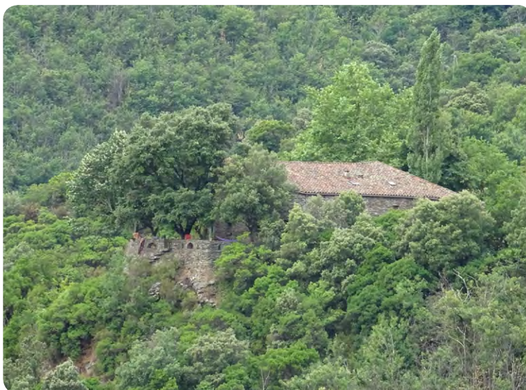
La maison disparaît sous la végétation.
