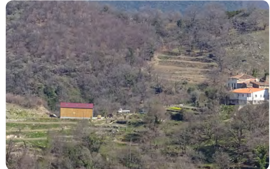
^ Sounalou-le-haut : bâtiment agricole en bardage bois
