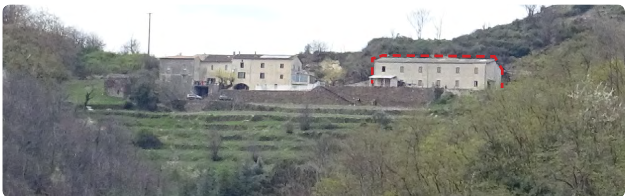
^ Cap de Coste : bâtiment agricole maçonné en continuité du corps de bâtiment existant (à gauche) : même proportion, volume simple, rythme des ouvertures.
