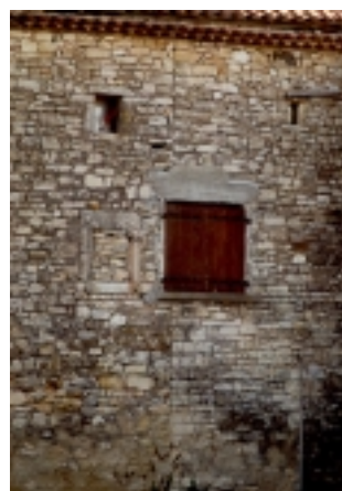
L'exemple d'un percement non respectueux du bâti dans lequel il s'insère
