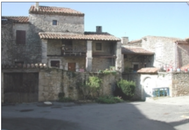
Russargues - Deux niveaux de terrasses sur soubassement en pierre et alignement des porteurs verticaux en pierre de taille.
