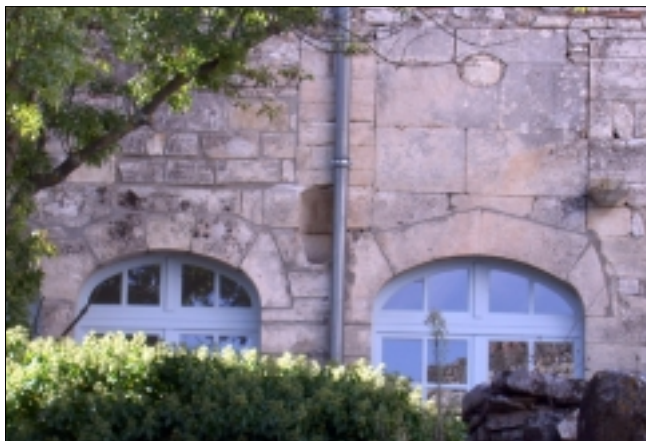
Ensembles menuisés s'insérant parfaitement dans les tableaux existants, le percement d'origine est respecté...
