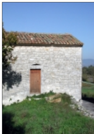
Linteau droit en pierre et «arc de décharge»
