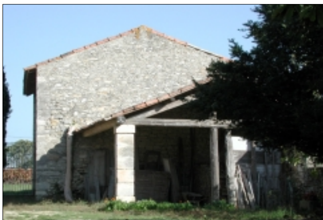
L'abri traditionnel : un ouvrage harmonieusement proportionné.
