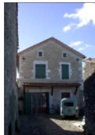
Auvent bois et tuile sur console bois : un élément d'architecture à éviter absolument...
