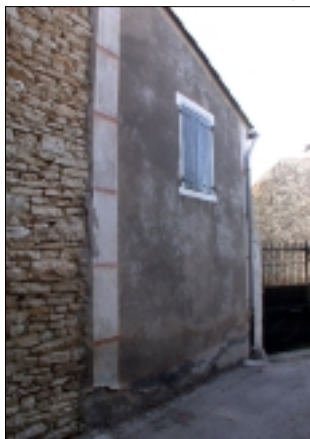
Les badigeons à la chaux soulignent chaînes d'angle, débords de couverture ou encadrement de baies.
