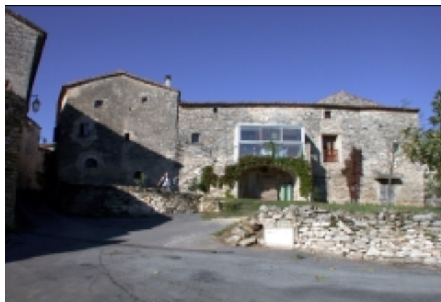
La «véranda» en aluminium et plaques polyester de couverture s'intègre difficilement à l'architecture traditionnelle...
