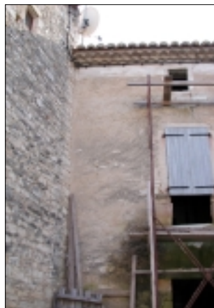
Parement enduit ... et parement à joints beurrés, deux autres finitions présentes sur le site.
