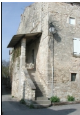
L'escalier en pierre extérieur, prolongé d'un porche ou d'une terrasse, permet d'accéder au logement
