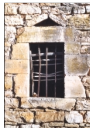
appui simple et linteaux avec arc de décharge,
