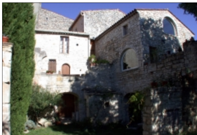
Attention au choix des ouvertures créées : la proportion trop carrée des deux baies et leurs linteaux pleins cintres ne se réfèrent à aucune baie traditionnelle
