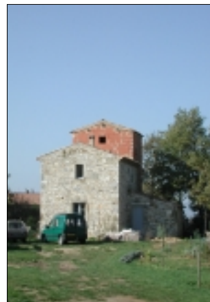
Construction récente isolée en cours d'exécution
