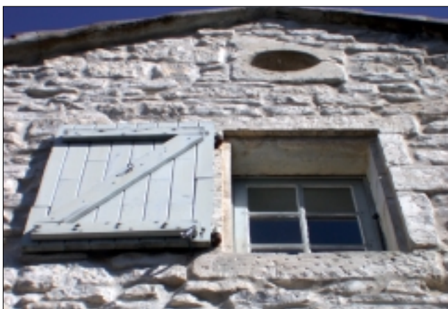
A éviter : volets à «barres et écharpes»
