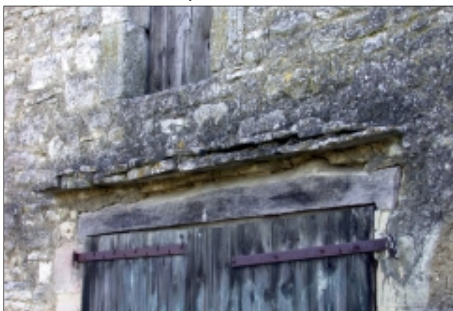
Protection de linteau bois
