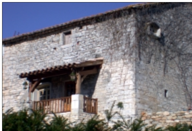
Auvent bois et tuile sur poteaux bois, garde-corps à barreudage bois, ouvrages types du chalet sont à éviter.
