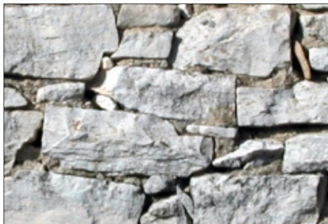
Un mur appareillé
