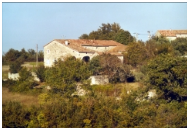
La végétation autour des bâtiments : un élément majeur d'intégration.
