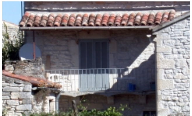
Exemple réussi de garde-corps métallique ; on regrette d'autant plus l'utilisation du «voutin» béton de la dalle porteuse...
