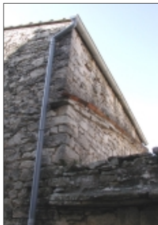
Cohabitation d'une gouttière contemporaine en zinc et d'une descente en pierre et terre cuite pour le recueil des eaux
