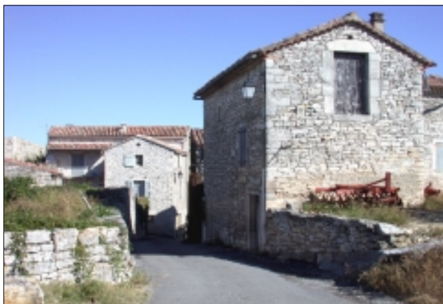
Les pignons sont peu percés
