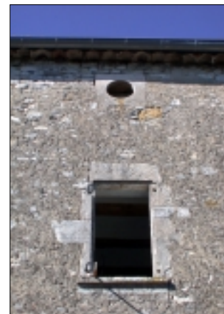
Parement enduit ... et parement à joints beurrés, deux autres finitions présentes sur le site.
