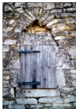
appui simple et linteaux avec arc de décharge,
