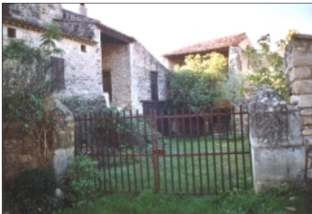
Le Mas - Percements verticaux toute hauteur ménageant des porches très importants.
