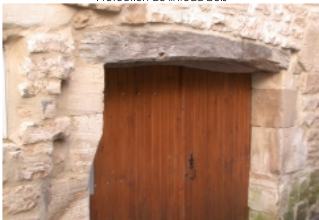
Linteau droit en bois
