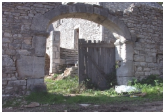
La Blaquière : accès à la cour Ouest et vue de l'escalier d'accès extérieur
