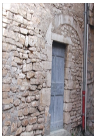
Les murs offrent les traces multiples de modification des ouvertures au fil des âges
