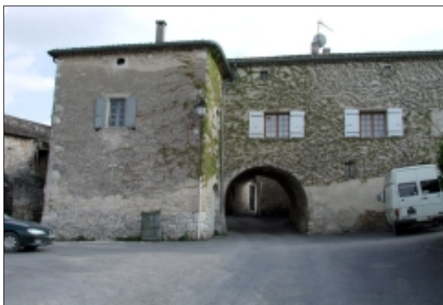
Le sable local donne sa couleur à l'enduit de finition ; le mimétisme avec la pierre naturelle est parfait.
