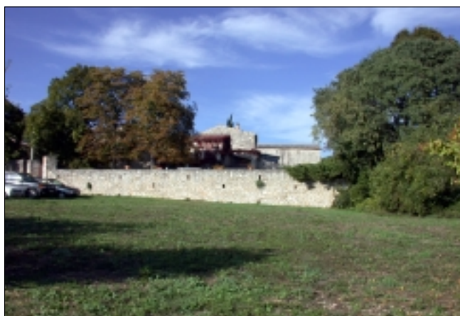
Mur de clôture et de soutènement
