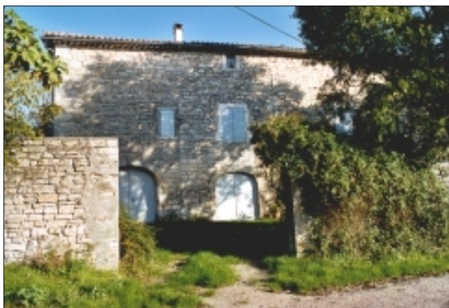
"Maison-bloc" traditionnelle : le rez-de-chaussée est affecté aux animaux (porcherie, étable...), le premier étage aux hommes (logement), le deuxième aux récoltes (pailler, grenier, magnanerie selon besoins)
