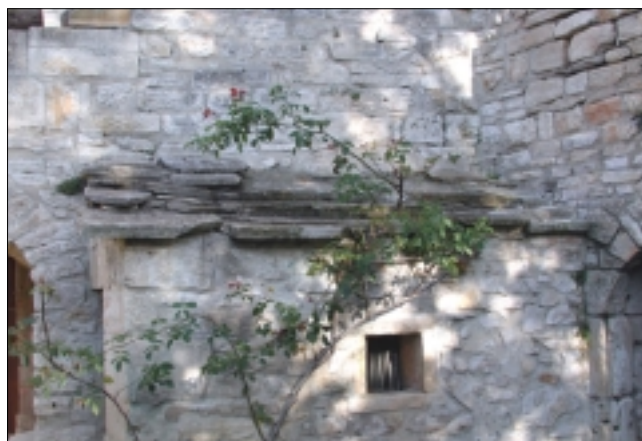
Cabiac : couverture de lauzes calcaires sur annexe réhabilitée
