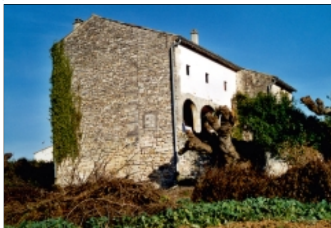
Attention aux contrastes de couleurs : ils nuisent à l'harmonie de l'ensemble bâti.
