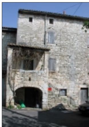
L'escalier en pierre extérieur, prolongé d'un porche ou d'une terrasse, permet d'accéder au logement
