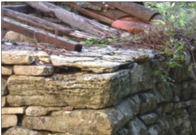
Une couverture de lauze remplacée par de la tuile ronde à Cabiac
