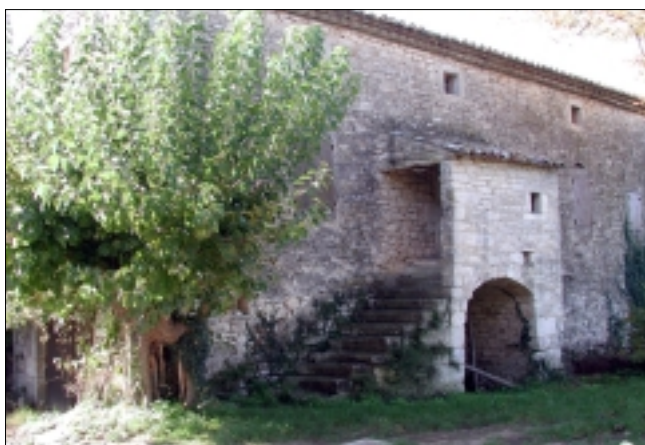
Porche d'entrée maçonné
