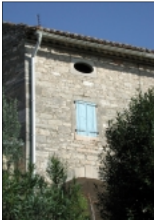
Volets à lames à «clés et emboitures»
