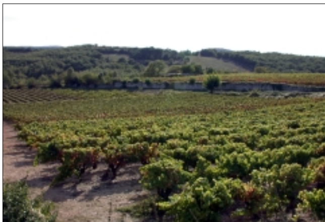
A la fois soutènement et clôture, le mur de pierre sèche s'inscrit harmonieusement dans le site.
