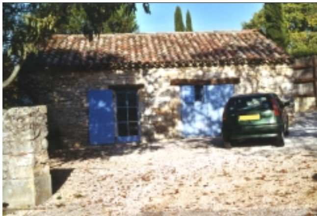
Un matériau recommandé : la tuile ronde, matériau le plus courant sur le site
