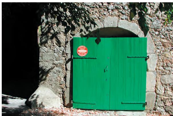
*La pose d'un portail standardisé qui ne respecte pas la structure de l'ouverture*
