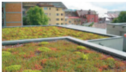
Exemple de toiture végétalisée
