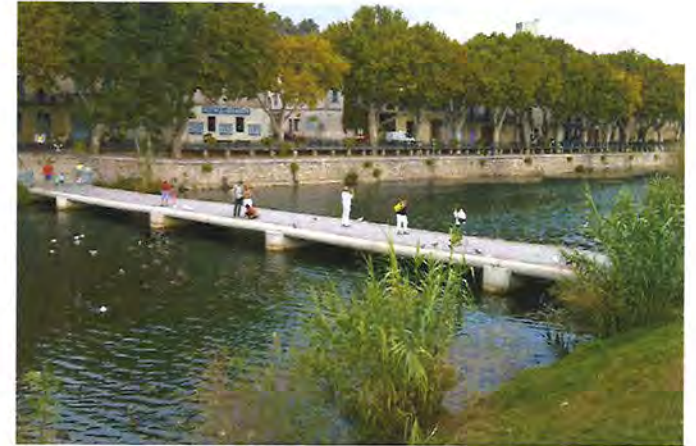
La passerelle submersible
