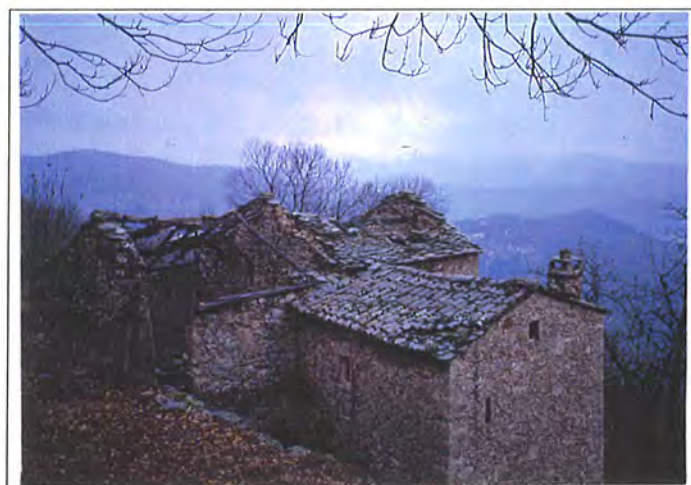
Toitures mixtes tuiles rondes et lauzes (Cévennes)
