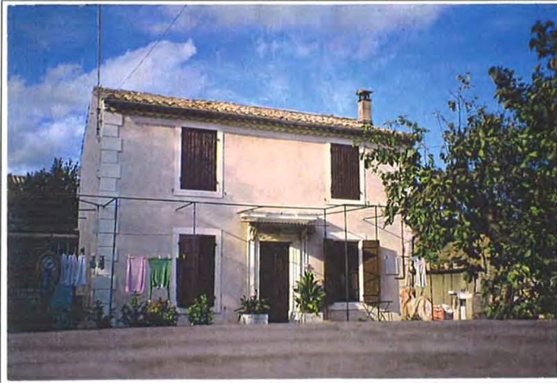
Porte d'entrée dans l'axe de la façade, fenêtres symétriques de part et d'autre. (Saint Gervasy)
