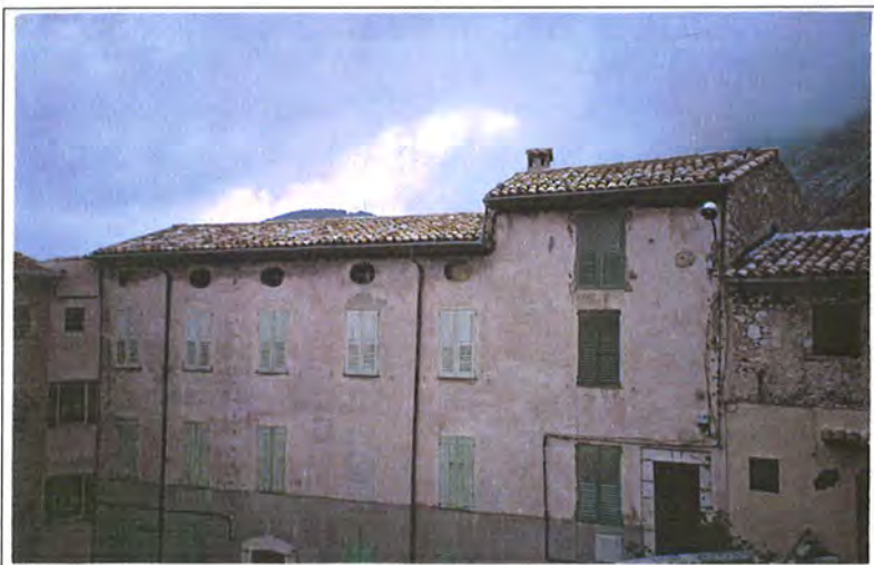
Alignement vertical des percements tous identiques. "Oeil de boeuf" ovale au dernier niveau. (Magnanerie) (Village perché de Provence)
