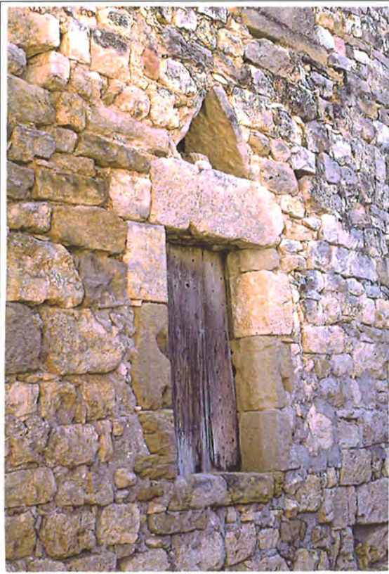
Pierre monolithe avec "arc de décharge" (Blauzac)
