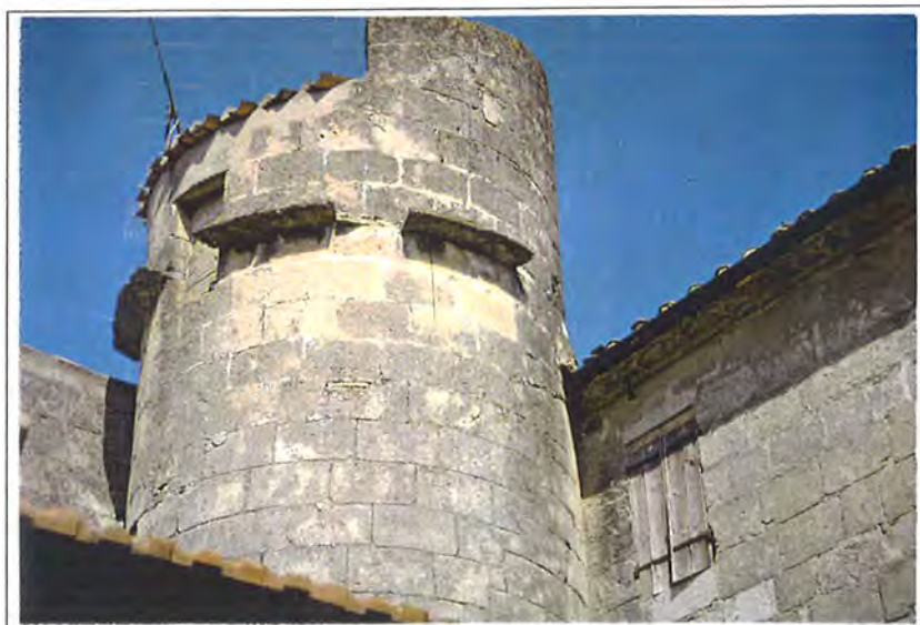
Pigeonnier rond intégré, adossé aux bâtiments dans un angle du mas. Seule la tour se distingue de la masse. (Almargues)
