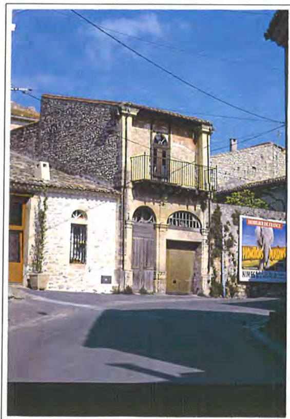
Utilisation du bois comme élément de structure en façade : "colombages" (Clarensac)
