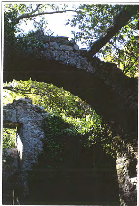
Arc en pierre formant ferme (Moulin de la Foux à Vissec)
