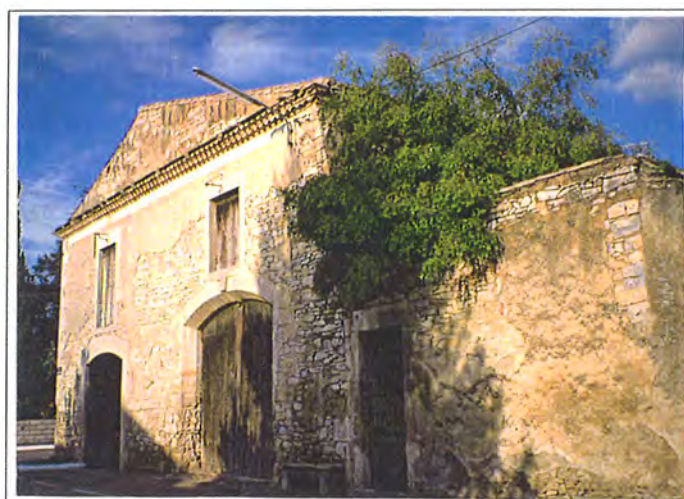
Génoise tournante en mur pignon (Saint Gervasy)
