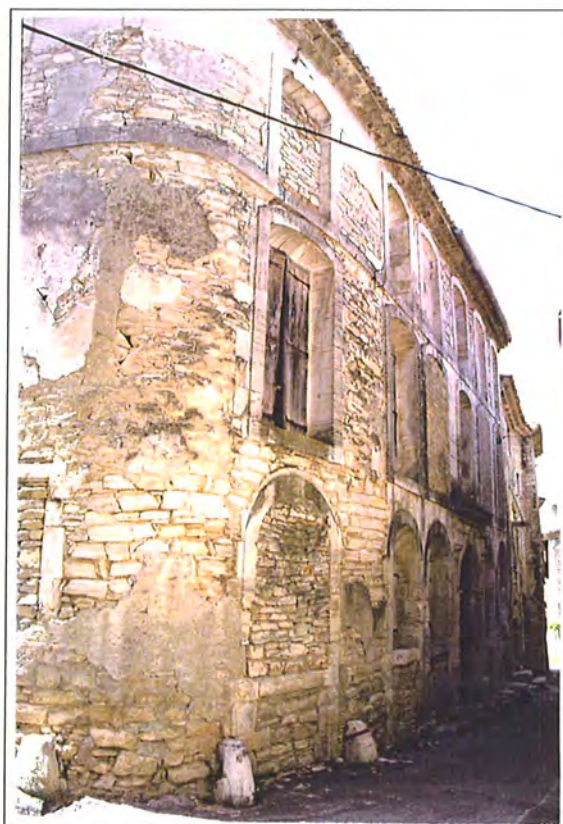
Construction sans chaîne d'angle, en "arrondi" (Rivières)
