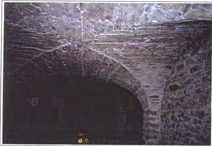
Voûte d'arête (Intersection de deux voûtes en berceau). (Conqueyrac)
