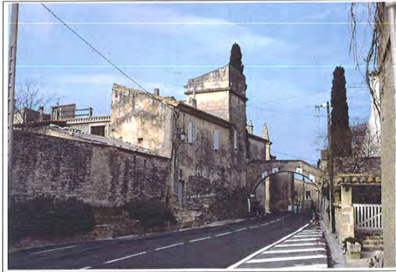
Pigeonnier intégré au mas. Inséré au corps du bâtiment, il se signale par l'émergence de sa haute toiture au-dessus de la ligne des faitages.
