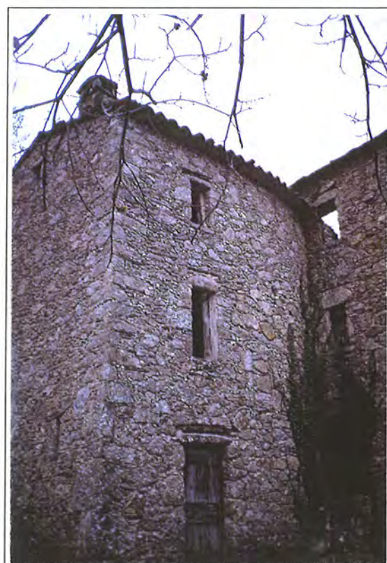
Granit et schiste en alternance (Cévennes)
