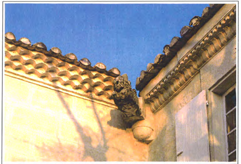
Génoise à trois rangs et corniche en pierre (Garons)
