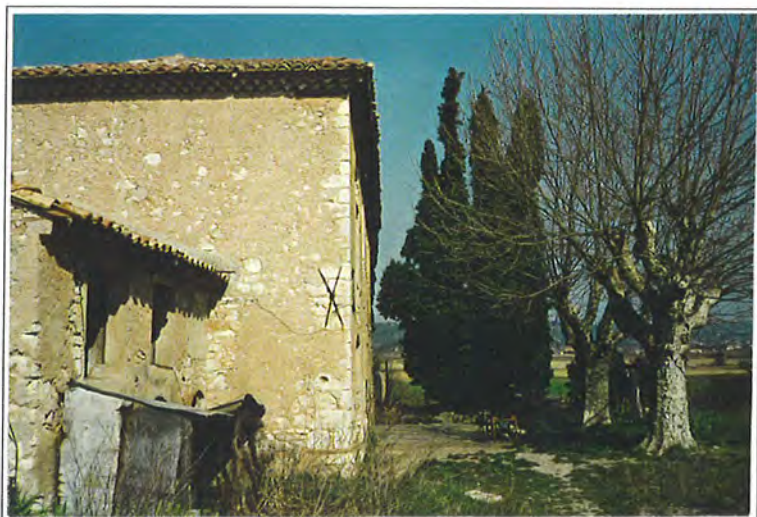
Enduits à joints beurrés (Eguelles)
