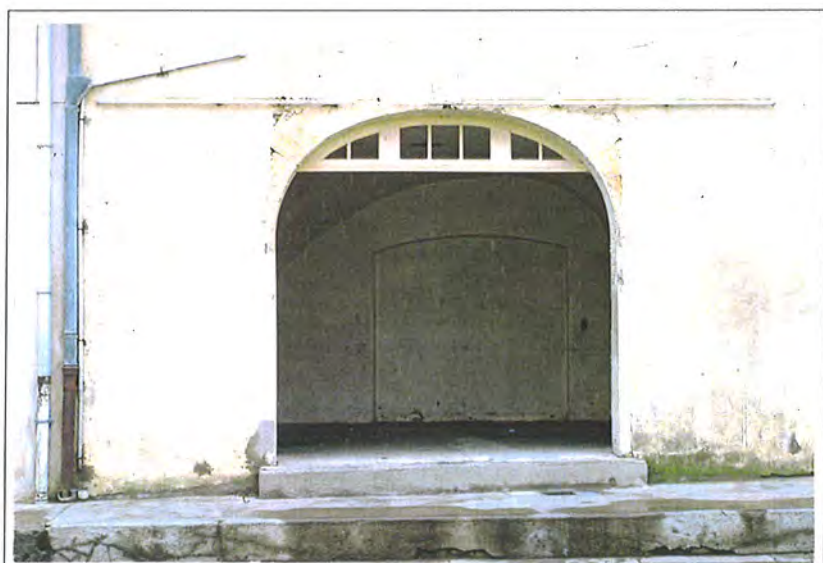
Cintre en pierre en "anse de panier" (Caissargues)
