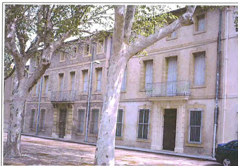
Pierre taillée pour encadrements, traitement du plancher d'étages, châinages verticaux. (Marsillargues)
