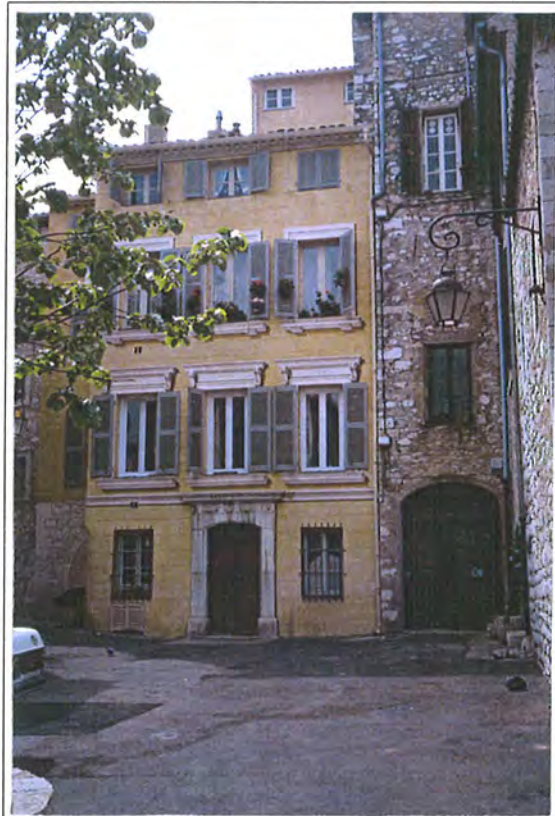
Encadrements des fenêtres du 1er et 2ème étage traités en "trompe-l'oeil" décor au lait de chaux (Vence)
