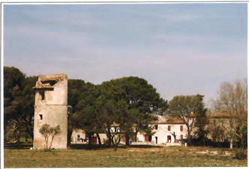
Pigeonnier rond, isolé, toiture en cascade. (Lançon-de-Provence)
