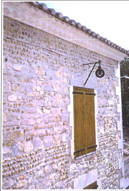
Génoise peinte sur mur gouttereau (Boullargues)
