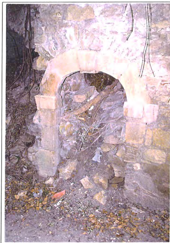
Plein cintre à claveaux et clé de voûte + corbeaux taillés et pieds droits taillés (Saint Alexandre)
