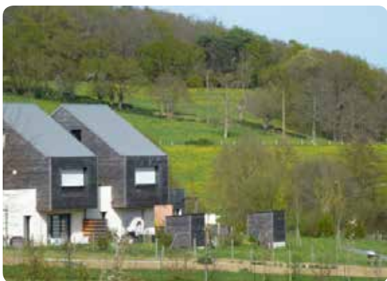
Au sein de l'écoquartier de la Barberie : réduction des voiries et des stationnements, les espaces végétalisés représentent 60 % de la surface totale du quartier.
