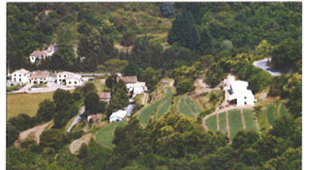
Couverts de fibrociment naturel, deux bâtiments agricoles se démarquent trop au sein du site.
