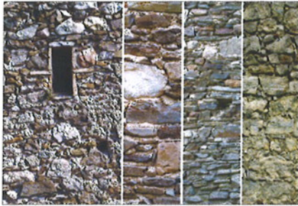
Une palette de parements à joints secs
