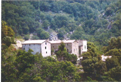
Liron - Juxtaposition de volumes simples, répétitifs, implantés perpendiculairement aux courbes de niveau
