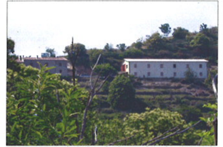
Bâtiment agricole à Cap de Coste : la volumétrie et la modénature des façades sont parfaitement adaptées au site ; on regrette d'autant plus le choix de la couverture en fibro-ciment gris, caractérisée par une surface trop lisse, trop claire et une facture trop uniforme.
