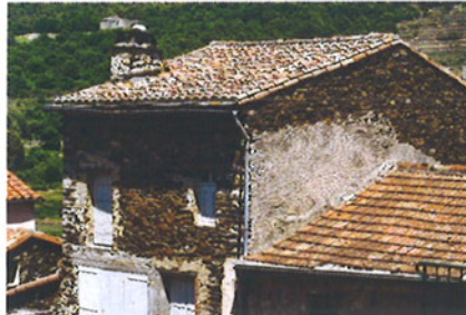
Tuiles plates à emboîtement dites "de Marseille" avec tuiles rondes
