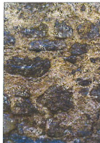
Parements "à pierres vues"
