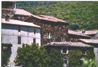
Attention à la cohabitation "enduit clair" avec "parement naturel foncé"...
