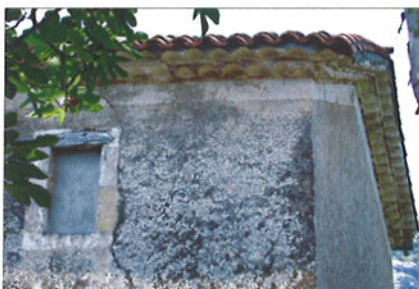
Les badigeons à la chaux soulignent chaînes d'angle, débords de couverture ou encadrement de baies.
