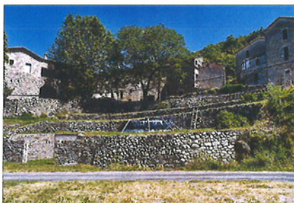
Le Mazel - Soutènements de pierre sèche à joints secs
