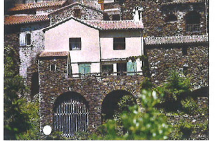
Saint Martial, façade Sud du village : les soubassements des terrasses rattrapent la pente très escarpée du relief.
