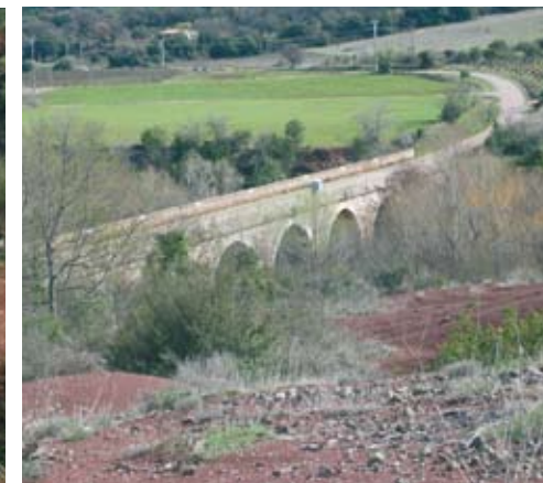
Le joli pont du Salagou, peu avant sa jonction avec la Lergue
