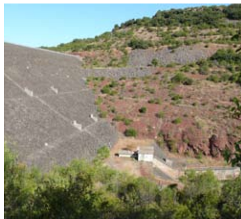
L'arrière du barrage, construit en pierre basaltique
