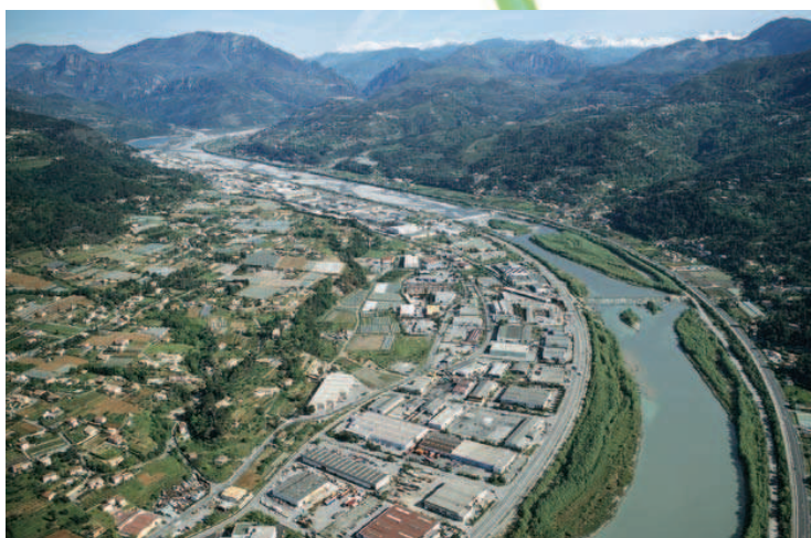
La concentration des activités dans les fonds de vallées génère de fortes pressions sur les corridors rivulaires : urbanisation, zones industrielles et commerciales, voies de communication. Le Var à Carros (Alpes Maritimes).
