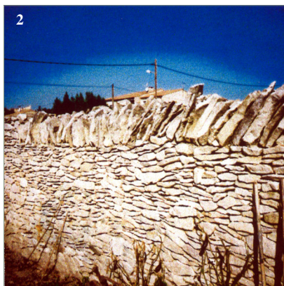
2. Dans la plaine viticole du Gard rhodanien : clôture en pierre calcaire avec couronnement de pierres dressées.
