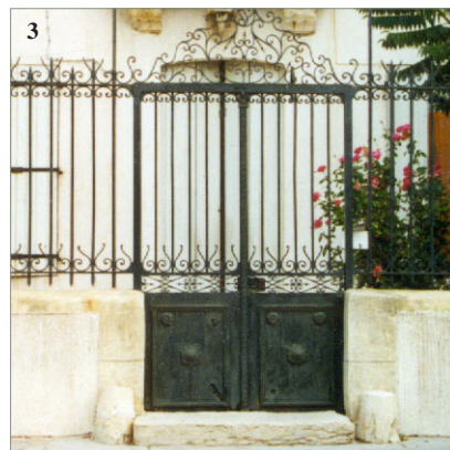
3. Dans un village de la Vaunage : mur bahut en pierre et grille en fer forgé.
