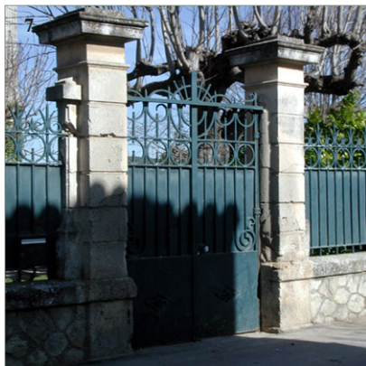
7. Village de plaine : fer forgé peint et piliers massifs en pierre constituent la clôture.
